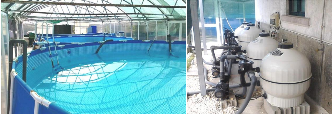
Figura 3 - Zona exterior coberta. Podem-se observar dois dos tanques redondos de grandes dimensões e a estrutura de suporte da cobertura semelhante à de uma estufa.
