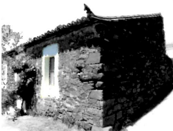
Fig. 27 - Habitação construída em alvenaria de xisto à vista. Tacões, Alcoutim
