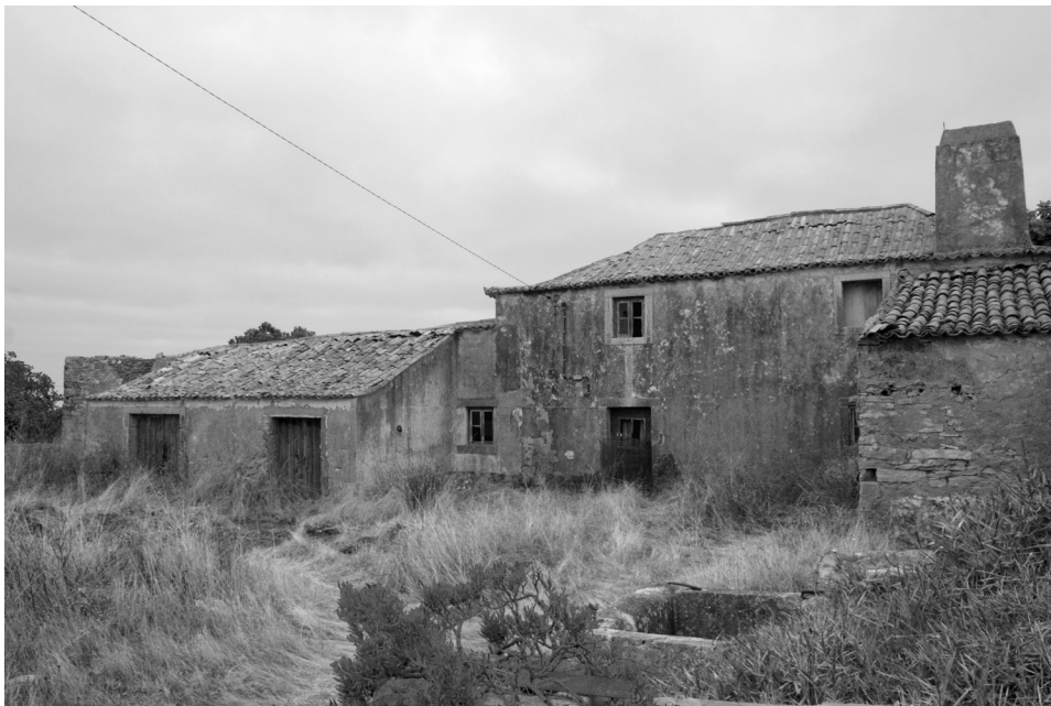
63. Habitação saloia em ruína, onde se observa construções térreas e de dois pisos. Assafora. Sintra. Ana Sofia Nero
