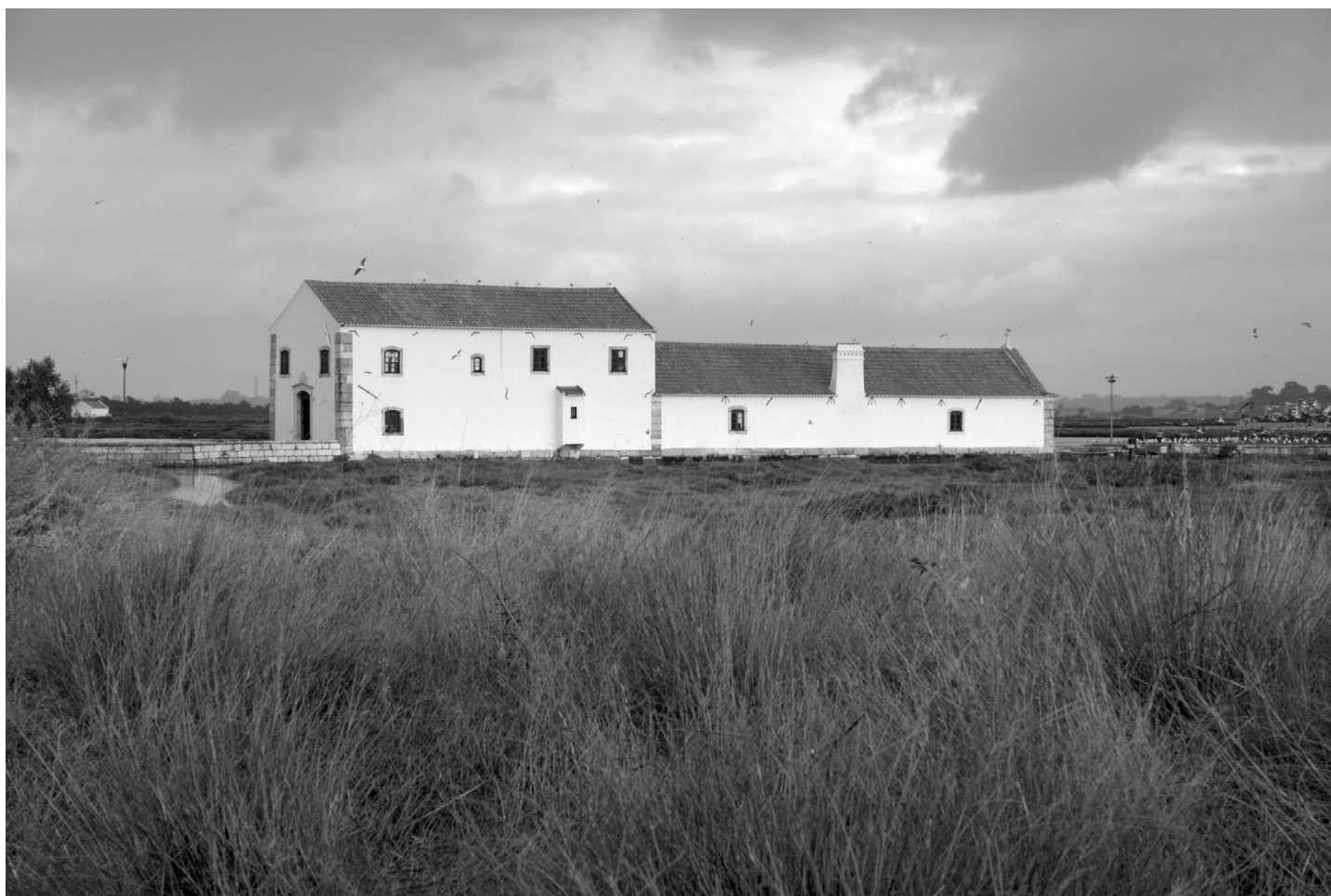
48. Vista do alçado poente do moinho de maré de Corroios. Seixal. Ana Sofia Nero
