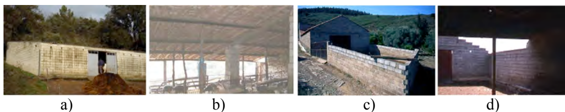
Figura 3.20 - Tipos de modelo arquitectónico dos edifícios: quatro paredes fechadas (a), com uma fachada aberta (b), com parque exterior (c) e com área interior descoberta (d).
