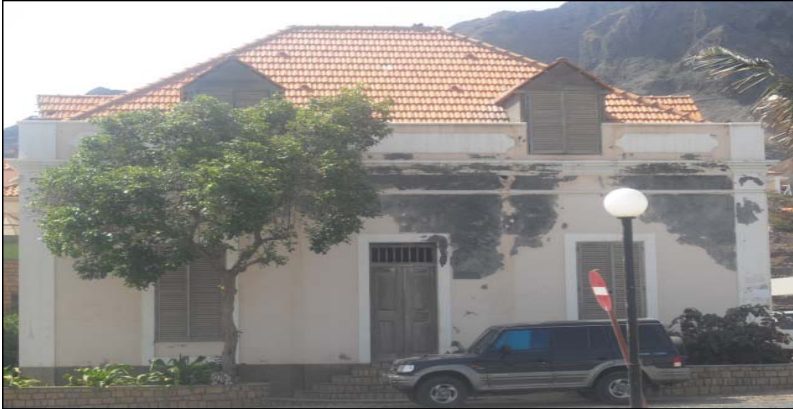
Fig. 4. Fachada principal de uma casa na Vila da Ponta do Sol
