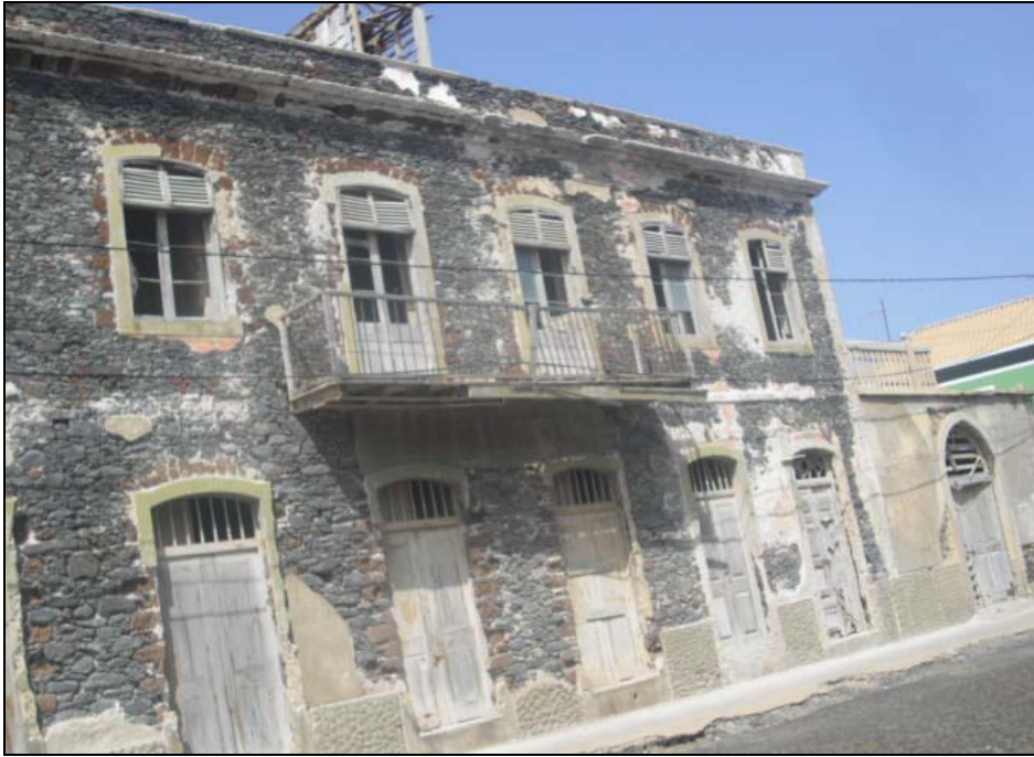
Fig. 16. Fachada principal de uma casa na Vila da Ponta do Sol.
