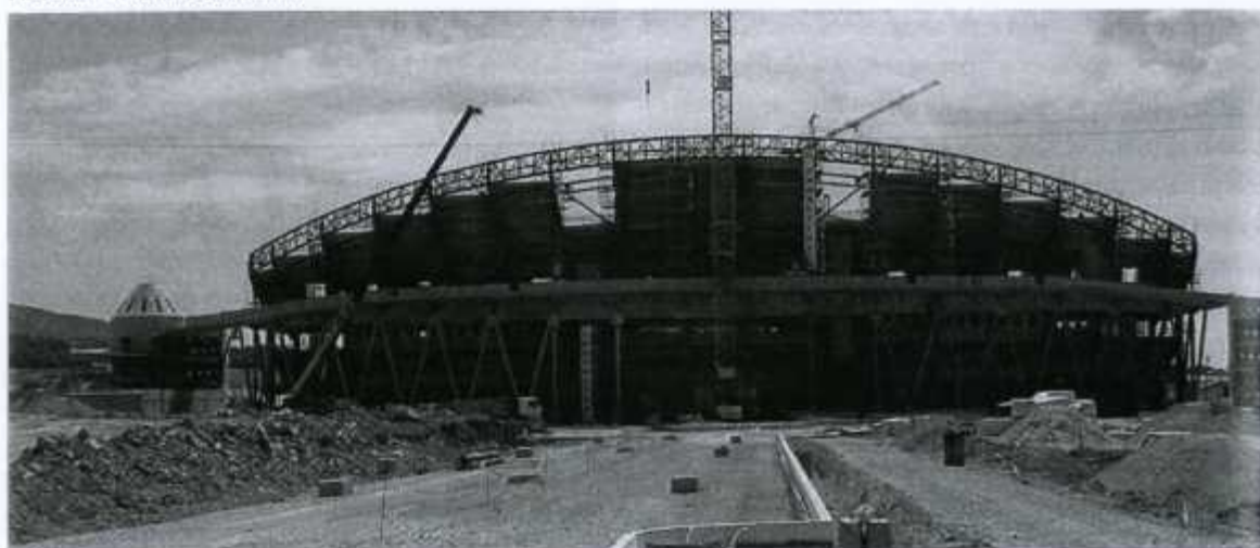
FIGURA 6 – Obras do Estádio
