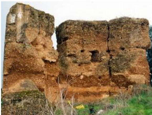
Figura 2.9 – Ruínas em Alvalade de construção em taipa (Quaresma, 2011)
