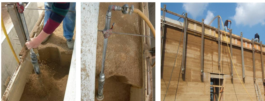
Figura 2.20 - Compactador pneumático, utilizado na Adega da Herdade do Rocim - Cuba (Fotos facultadas pela empresa Betão & Taipa, Lda.)
