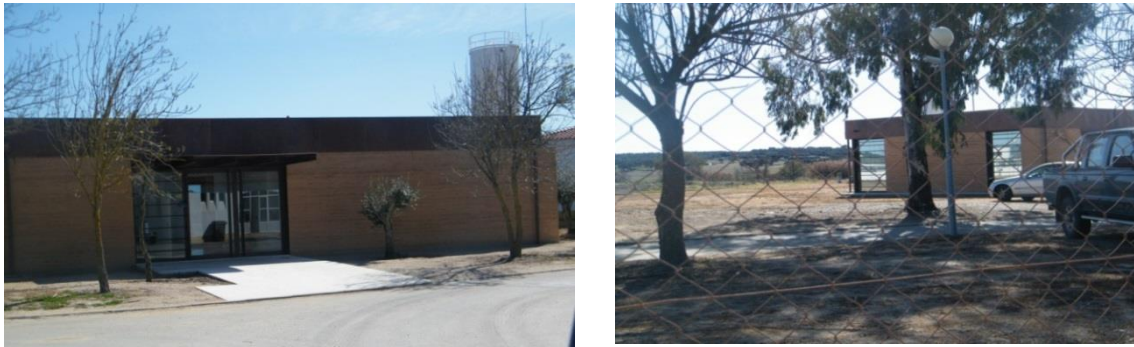
Figura 2.19- Centro de Monitorização da ETAR de Évora
