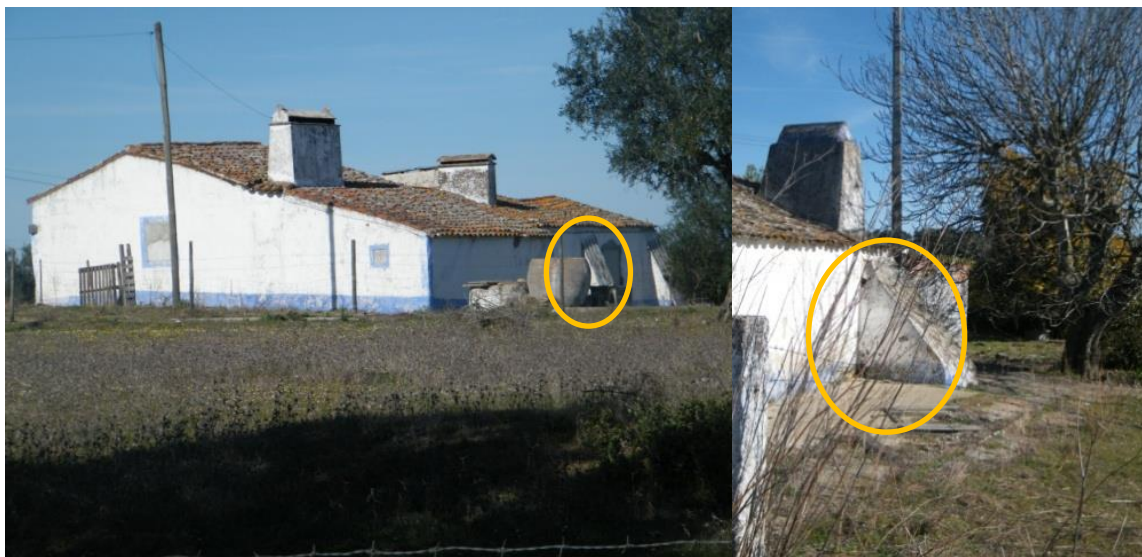
Figura 2.21 - Presença de contrafortes na construção em taipa
