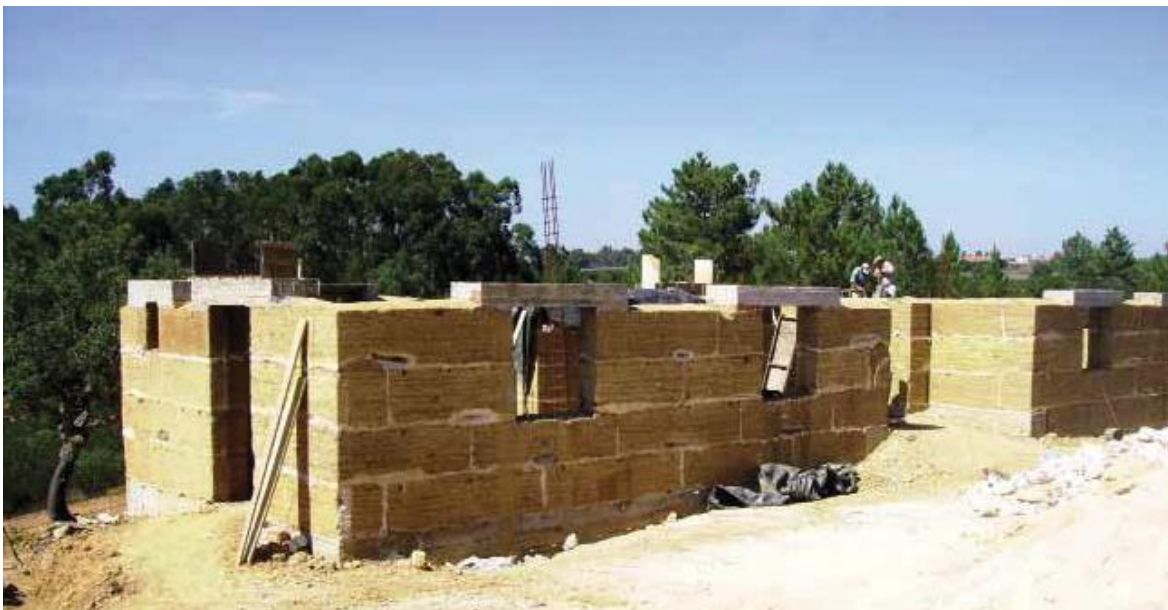
Figura 2.16 - Construção recente com vigas e pilares em betão (Schereck, 2010)
