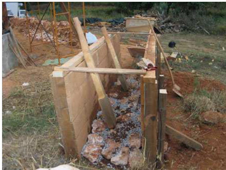
Figura 2.8 - Foto do curso de construção taipa em Cabaços, Odemira (Nelson, 2006)
