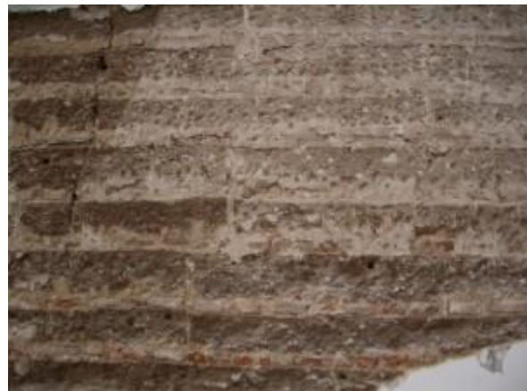
Figura 2.9 – Ruínas em Alvalade de construção em taipa (Quaresma, 2011)
