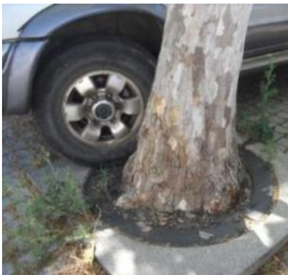
Figura 67 - Caldeira desadequada no B° da Senhora da Saúde Fonte: Própria
