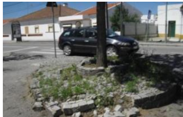
Figura 71 - Caldeira levantada na Av a da Horta das Figueiras – Antiga Estrada de Viana Fonte: Própria
