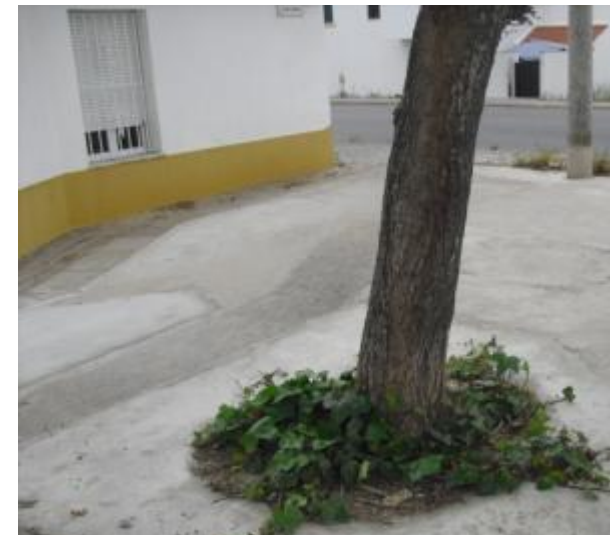
Figura 44 - Pavimentação da área adjacente da caldeira, efetuada possivelmente pelo morador do prédio contíguo Rua Prof. António Maria Godinho – Bº António Sérgio Fonte: Própria
