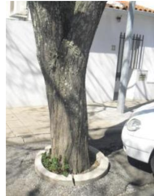
Figura 63 - Dimensão da caldeira desadequada no Bairro do Alto dos Cucos Fonte: Própria
