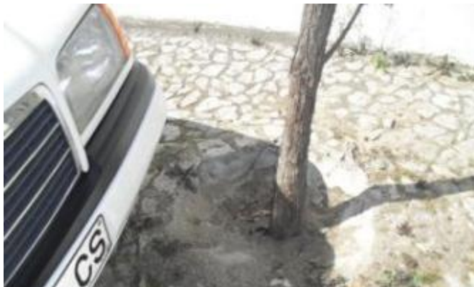
Figura 43 - Impermeabilização da caldeira com restos de cimento, provavelmente proveniente de obras nas imediações Rua da Sobreira – Bairro da Malagueira Fonte: Própria
