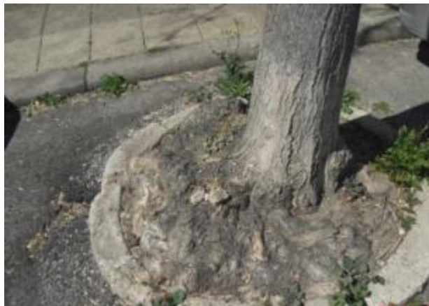
Figura 64 - Caldeira desadequada no do Alto dos Cucos provoca estrangulamento das raízes Fonte: Própria
