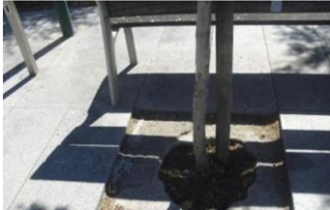
Figura 42 - Impermeabilização de caldeiras com betão após as obras de construção do espaço. Rua dos Altos – Bairro das Coronheiras Fonte: Própria
