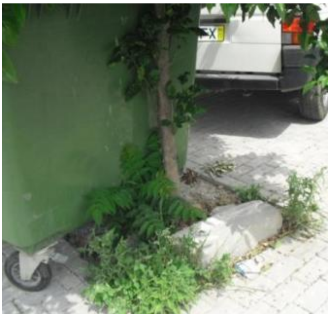
Figura 39 - Equipamentos urbanos instalados sobre as caldeiras, poderá provocar para além da compactação do solo, feridas no colo da árvore e asfixia radicular, para além de contaminar o solo com produtos provenientes dos contentores e deteriorar o pavimento em redor Fonte: Própria
