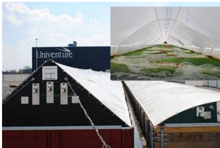
Figura 2. Fotobiorreactor raceway cerrado con inyección de CO 2 (Algaenergy)
