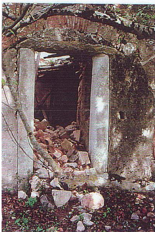
Fig.17 - Antigo Lagar dos Frades, Porta de acesso ao piso térreo.
