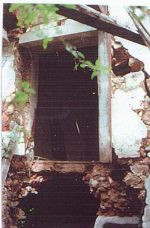
Fig.18 - Antigo Lagar dos Frades, Acesso ao primeiro piso.
