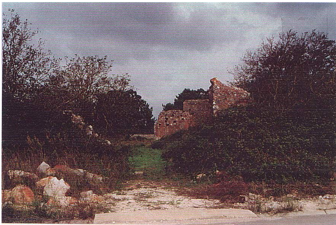
Fig.16 - Antigo Lagar dos Frades, Alçado Sudoeste.
