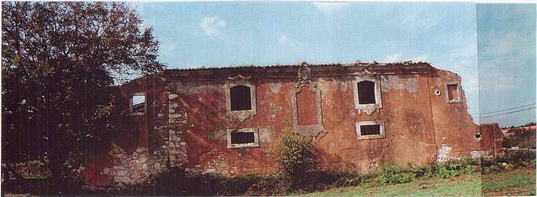
Fig.3 - Antigo Lagar dos Frades, Alçado Principal/ Sudeste
