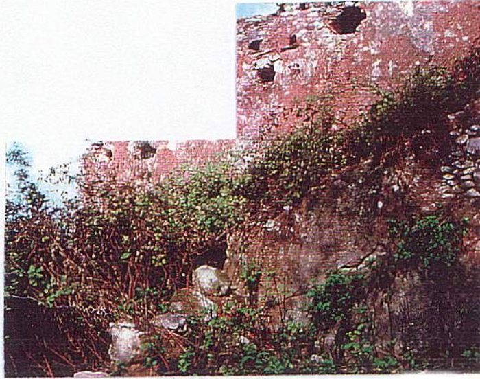
Fig.19 - Antigo Lagar dos Frades, Escada de acesso ao primeiro piso.
