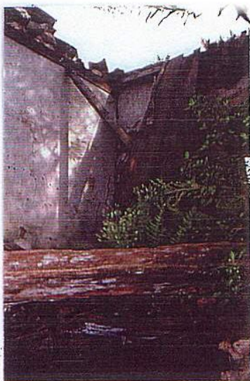
Fig. 21 - Antigo Lagar dos Frades, Aspecto do interior.
