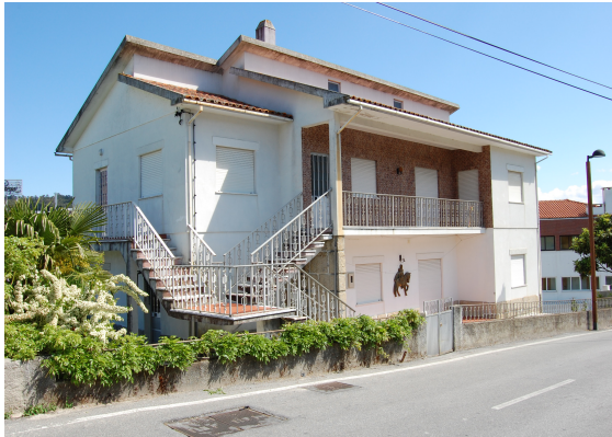
A casa de fim-de-semana que se dissemina no território sem suporte urbano e sem nada gerar.
