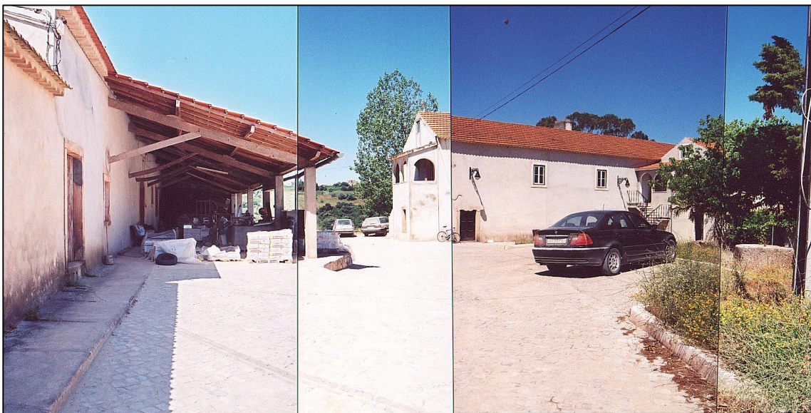
Fig. 15 - Turquel. Quinta da Granja, vista do conjunto dos edifícios de habitação e lagar.
