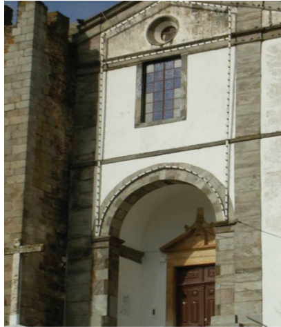
Fig.8. Diogo Pardo Osório. Igreja-Matriz de Nossa Senhora das Candeias. Mourão (ca. 1690). Fachada axial. Detalhe do portal central, entre pilares-contraforte inscritos e torreão da muralha medieval, com nártex reentrante sob arco redondo e em articulação com abertura superior e óculo no tímpano de frontão
