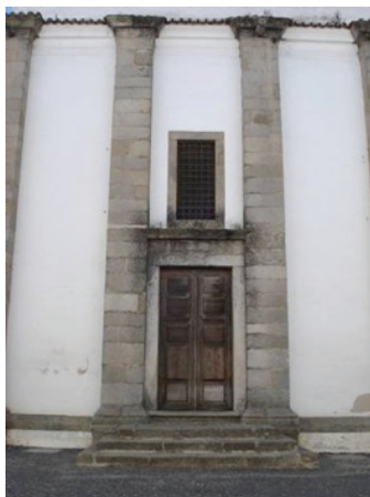
Fig.5. Igreja do Convento de Santa Helena do Monte Calvário. Évora (1578). Fachada lateral. Detalhe do portal central, com duplo adintelado, e articulação com abertura superior entre pilares-contraforte
