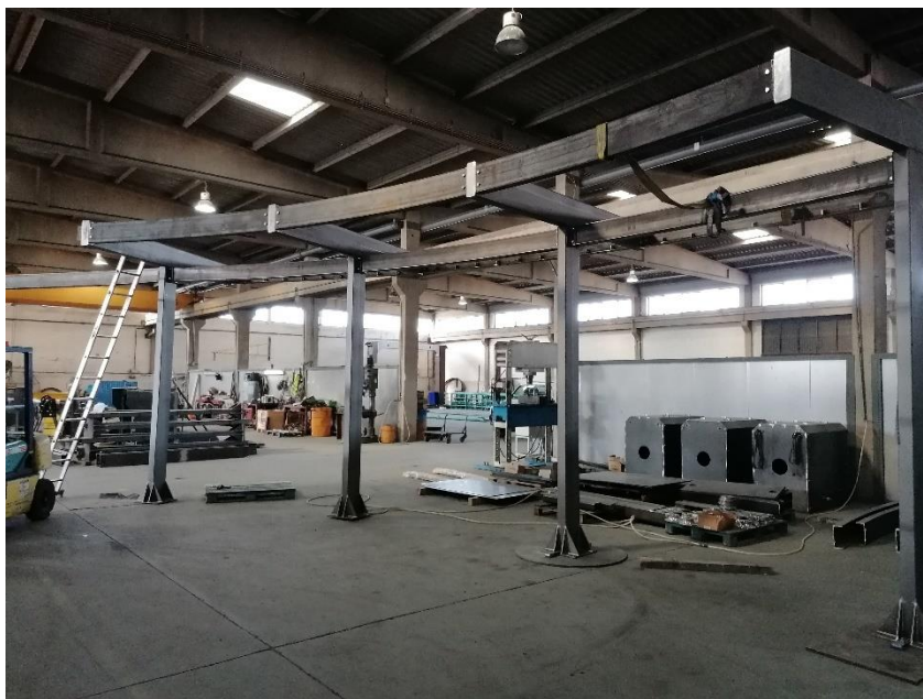
Figura 34-Montagem da pérgula em fábrica
