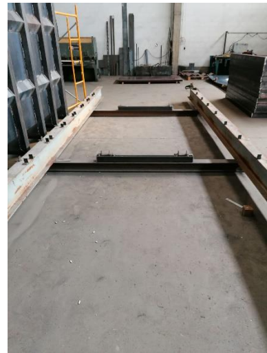
Figura 43-Molde para construção dos contentores
