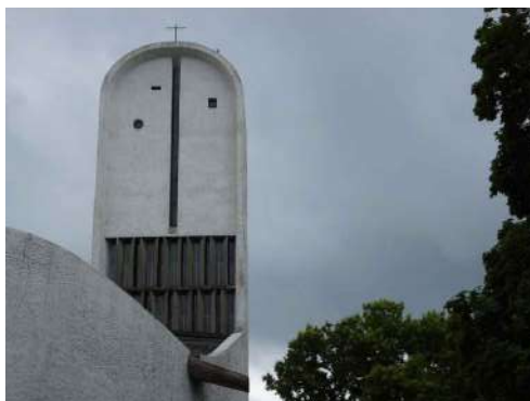
[fig. 264] Torre Sul
