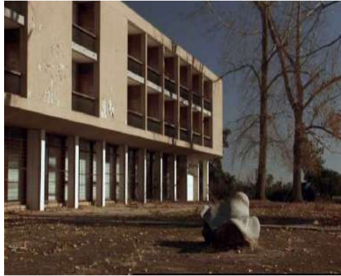
d) Casas dos Engenheiros, Aldeia de Barrocal do Douro
