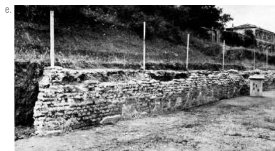
[fig. 196] Fotografias das escavações no Euripus . 1953-1955 © Gabinetto Fotografico Nazionale
