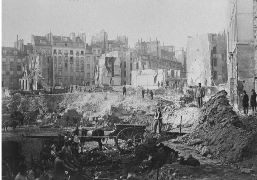
[fig. 101] Avenue d'Opéra. Chantier de la Butte du Moulin et de la rue Saint-Roch (1848-1862). Charles Marville
