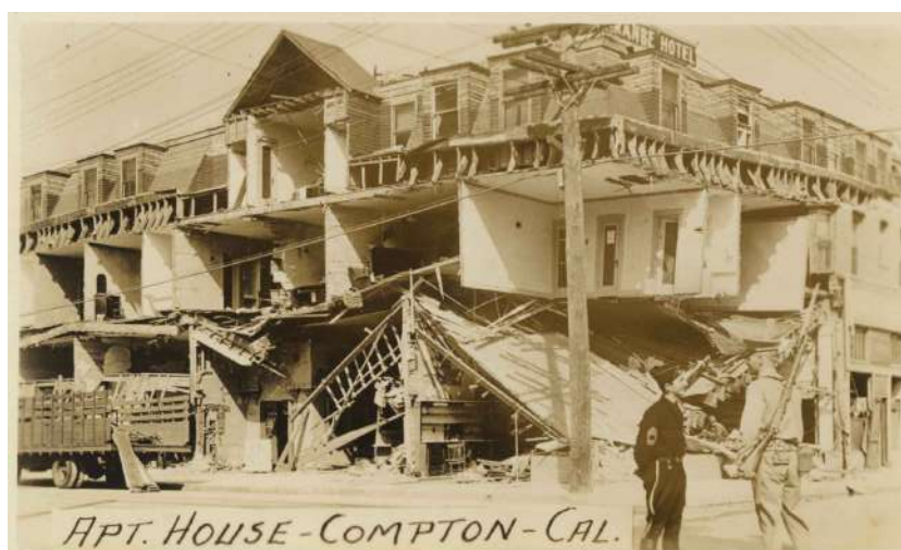
[fig. 093] Casas Compton em ruína após o terremoto de 1933, Adams McCafferty, 1933
