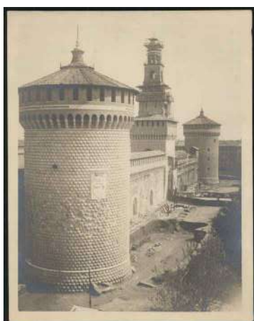
[fig. 156] Trabalhos de reparação do fosso externo durante o restauro liderado por Luca Beltrami (1905)
