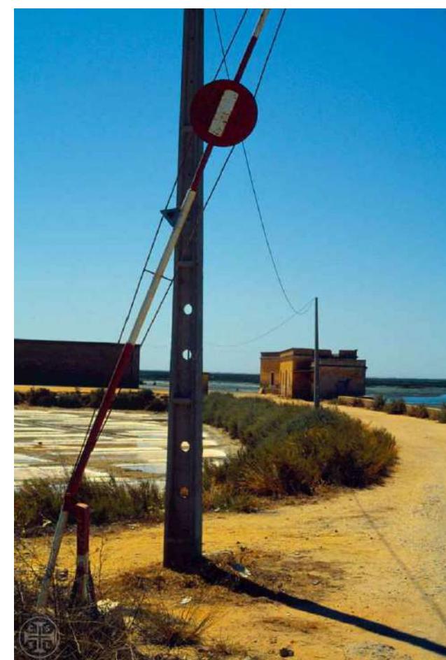
[fig. 418] O acesso à salina pelo Largo de São Francisco. Moinho com as platibandas e telheiro intactos, anos 80
