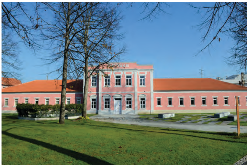
Fotografia 2 - Edifício Taipas Termal – (José Maia Freitas, 2018)
