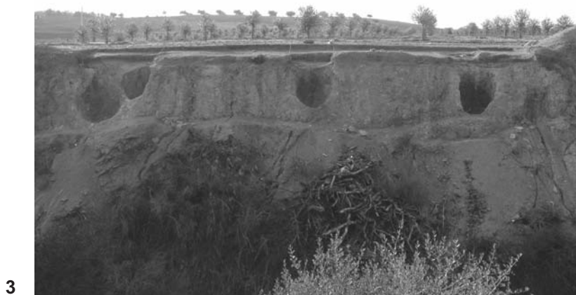
Fig. 12. Salsa 3. 1. Vista desde Sul; 2. Planta geral composta (Áreas I e II); 3. «Silos» 6-7-4-5.
