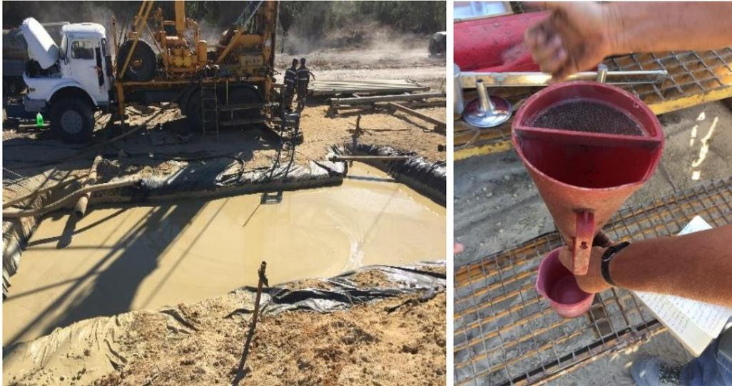
Figura 10. Tanque de lamas (à esquerda) e funil de Marsh (à direita).
