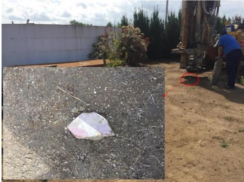
Figura 3. Marcação do ponto onde se realizou a sondagem. O destaque do círculo vermelho, indica o local exato a sondar, por baixo do martelo pneumático acoplado à máquina de sondagem.
