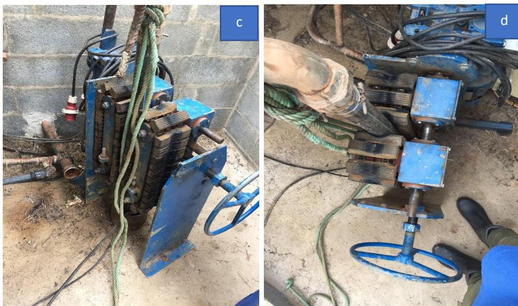
Figura 16. Remoção da tubagem através da lagarteira no furo F2.
