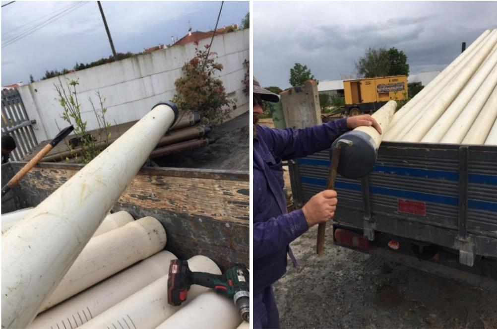
Figura 9. Colocação da tampa inferior no tubo de PVC.
