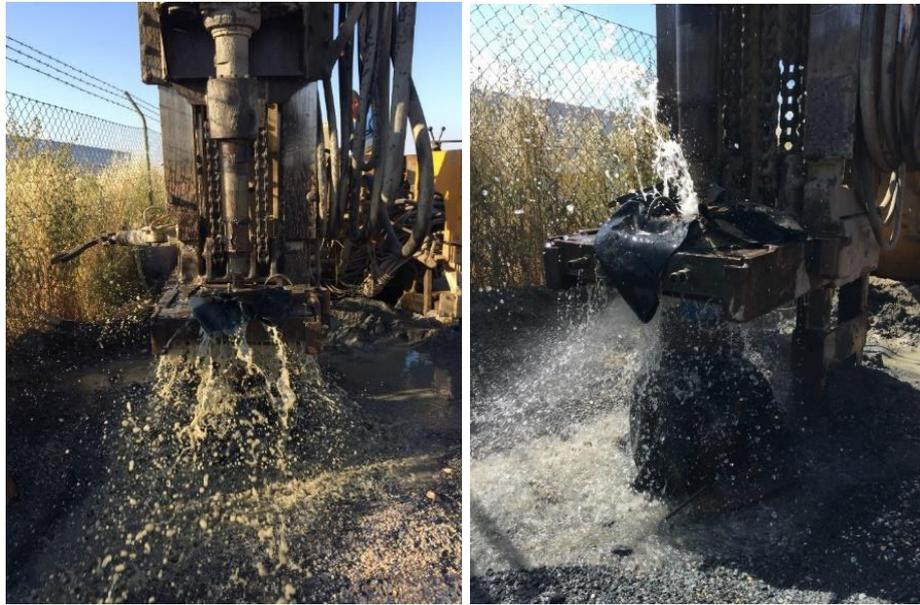
Figura 9. Evolução da limpeza do furo de captação (à esquerda ilustra o início da limpeza e à direita ilustra o fim da limpeza).
