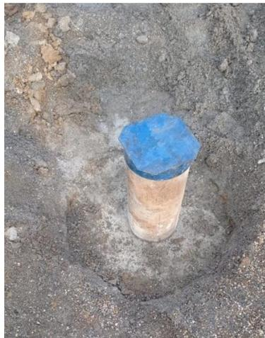
Figura 14. Captação de água destacando-se o selo e a tampa amovível de aço com cor azul.
