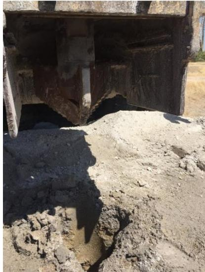
Figura 6. Trialeta prestes a alargar a coluna.
