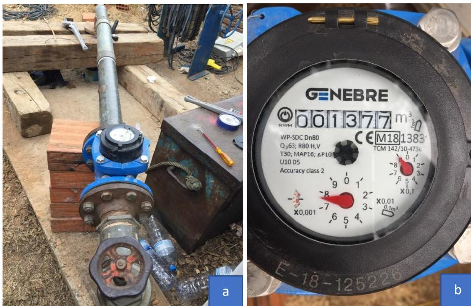
Figura 15. Contador para medição do volume extraído.
