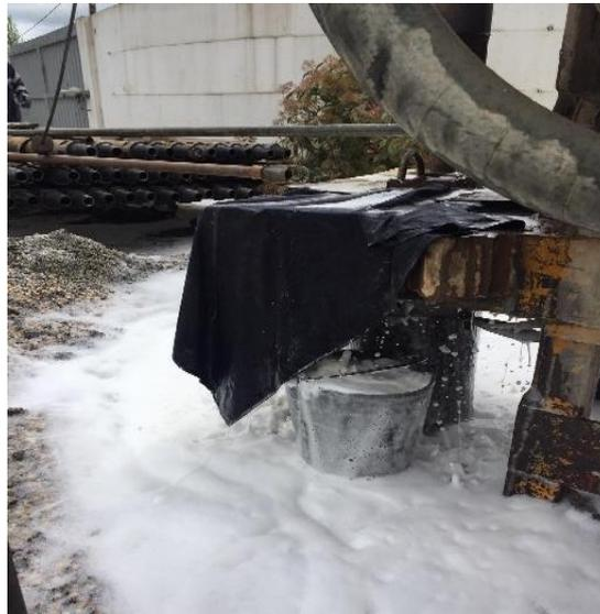
Figura 12. Limpeza do furo através do sistema de ar direto.
