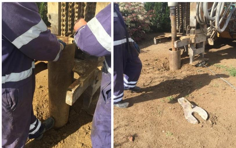
Figura 6. Inserção do tubo de isolamento no furo de pesquisa.
