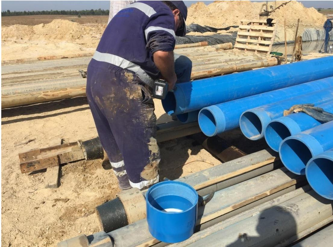
Figura 15. Tubos de PVC georoscados.
