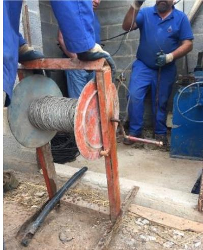
Figura 13. Cabo de aço sendo introduzido no furo de captação F7.
