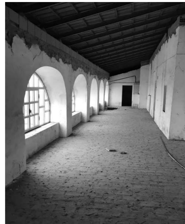
Fig. 74/75 | Piso Superior - Local Oeste
