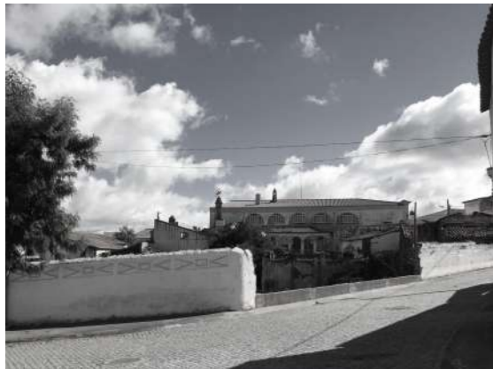
Fig. 50/51/52 | Muro de limite do terreno lado Sudoeste
