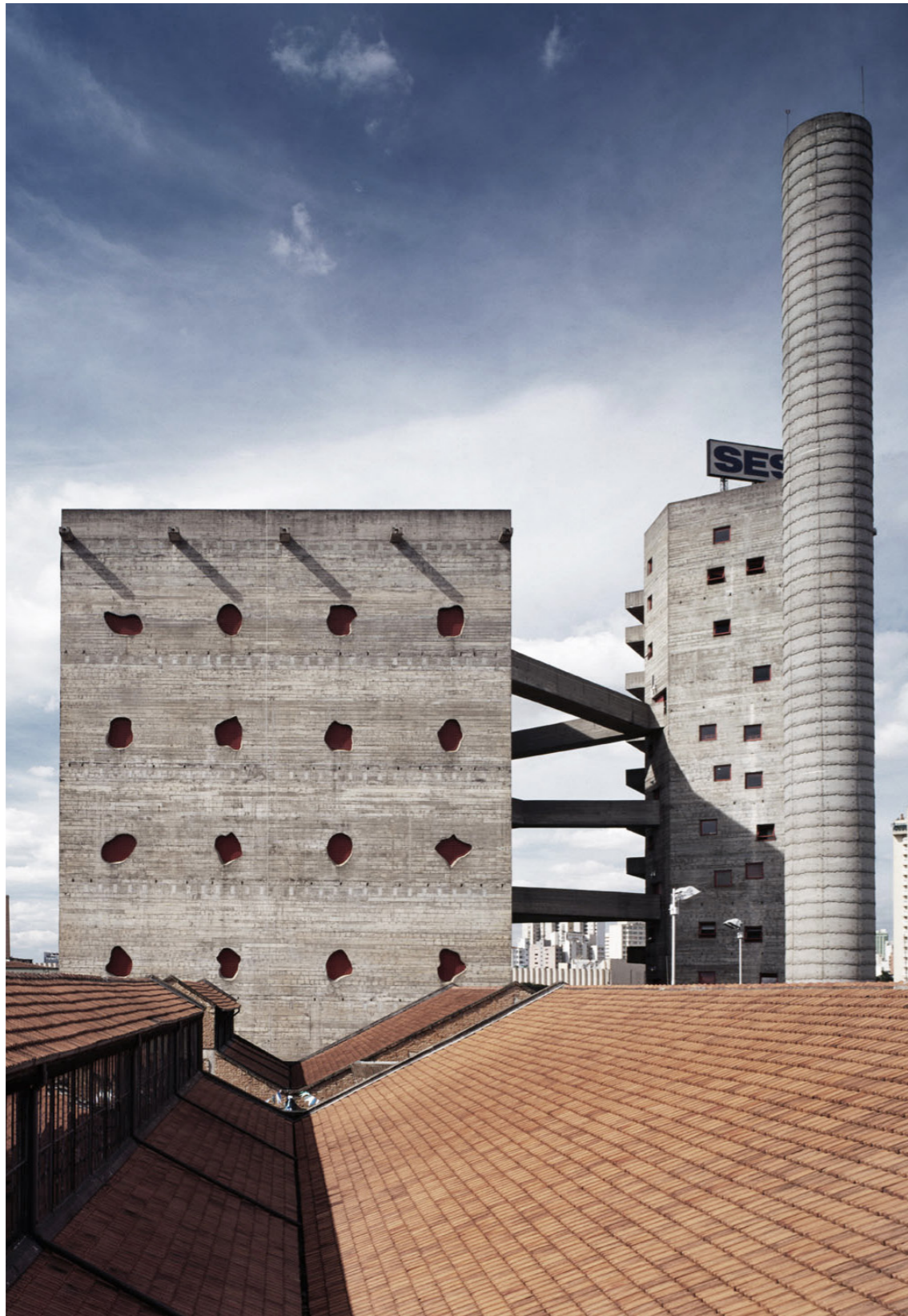
Figura 40. Fachada oeste do SESC Pompéia. N. Kon, 2002.
