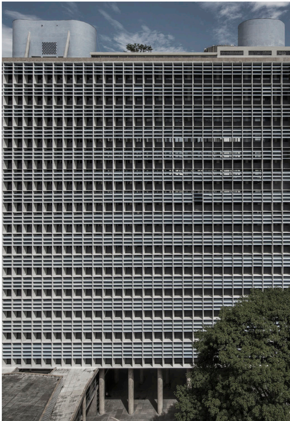
Figura 32. Fachada norte do Palácio Gustavo Capanema. N. Kon, n.d.
