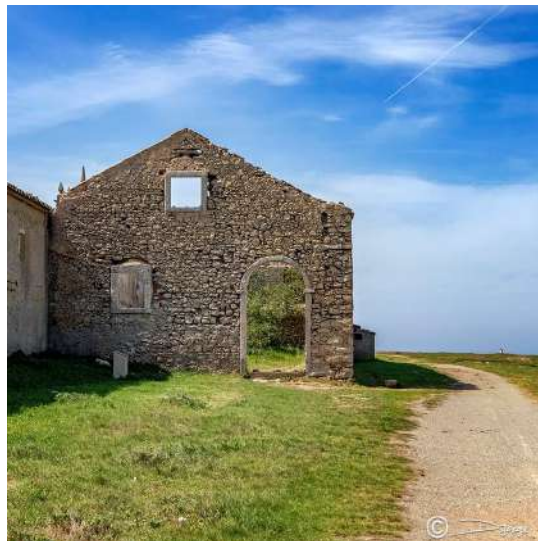
Figura 36– Ruínas da Casa da Ópera | © Daniel Jorge 2020
