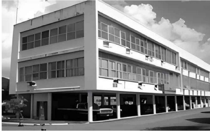
Fig.02.27. 1950/Edfício DER-SE (Departamento de Estradas e Rodagens de Sergipe) . ©Isabella Aragão.
