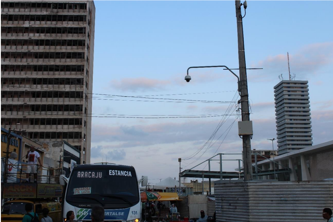
Avenida Mamede Paes Mendonça. O Terminal Rodoviário Luís Garcia à direita
