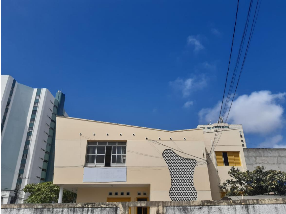
Fig. 02.25. 2022/ Residência João Gonçalves. © Fotografia da autora.
