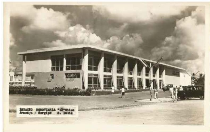
Fig. 02.30. 1962 /Terminal Rodoviário Luís Garcia. Rafael Grimaldi ©Autor desconhecido.
