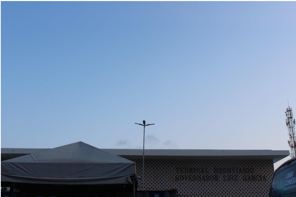
Fachada do Terminal Rodoviário Luís Garcia em obra de reabilitação
