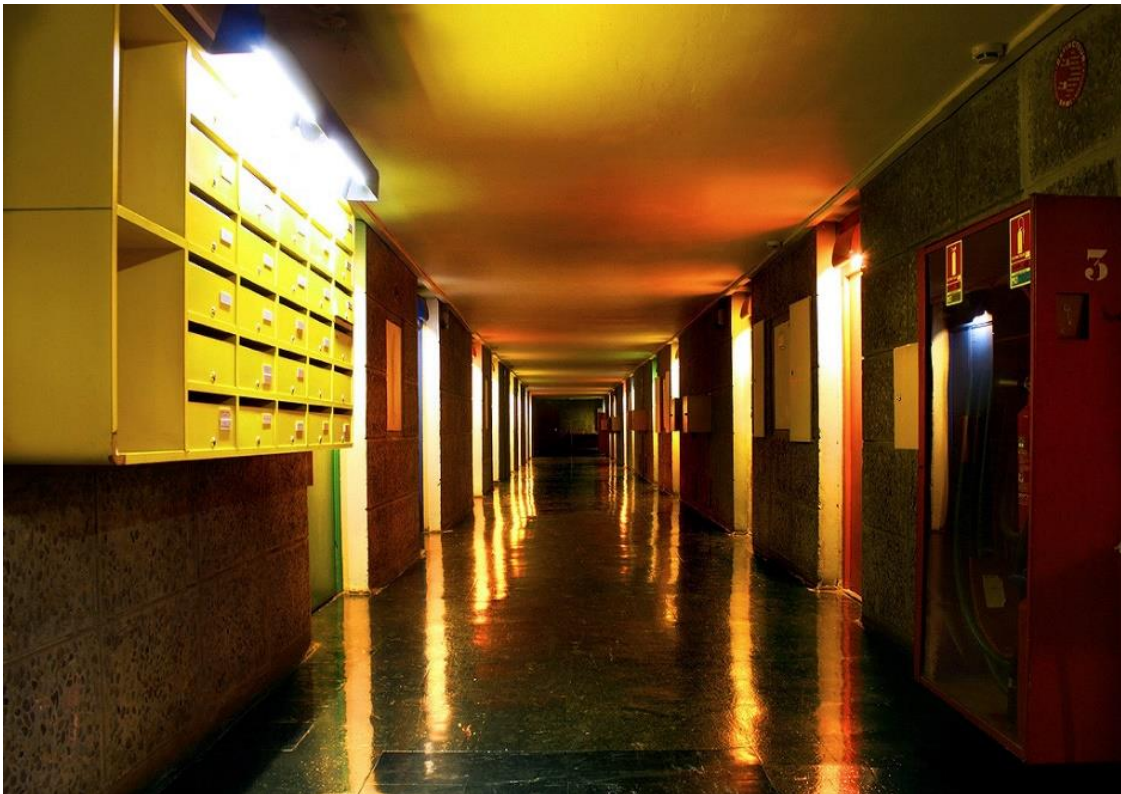
Fig. 02.05. 1947 - 1952/ Interior da Unidade Habitacional de Marselha. Le Corbusier . © Guzman Lozano.
