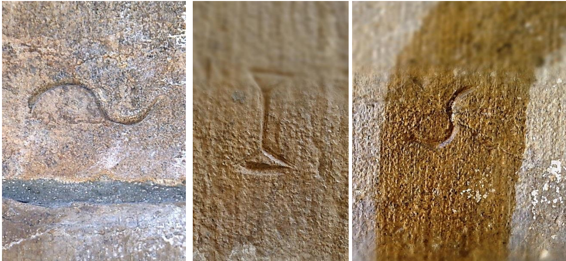
Fig. 121- Marcas de canteiro na galeria Este do claustro. Fotos Pedro Tavares, 2020.
