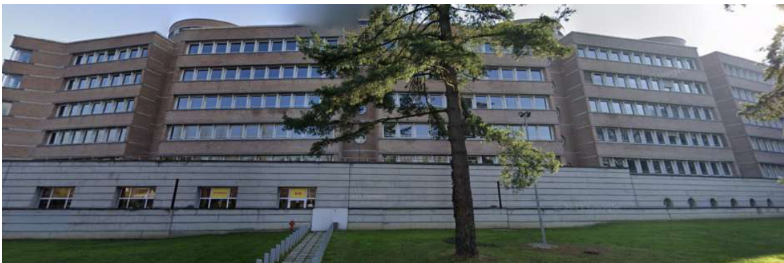
Nuovo Palazzo Uffici Olivetti, 1985-1988
