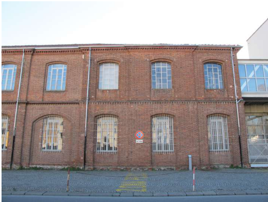
Edificio Mattoni Rossi, 1898
