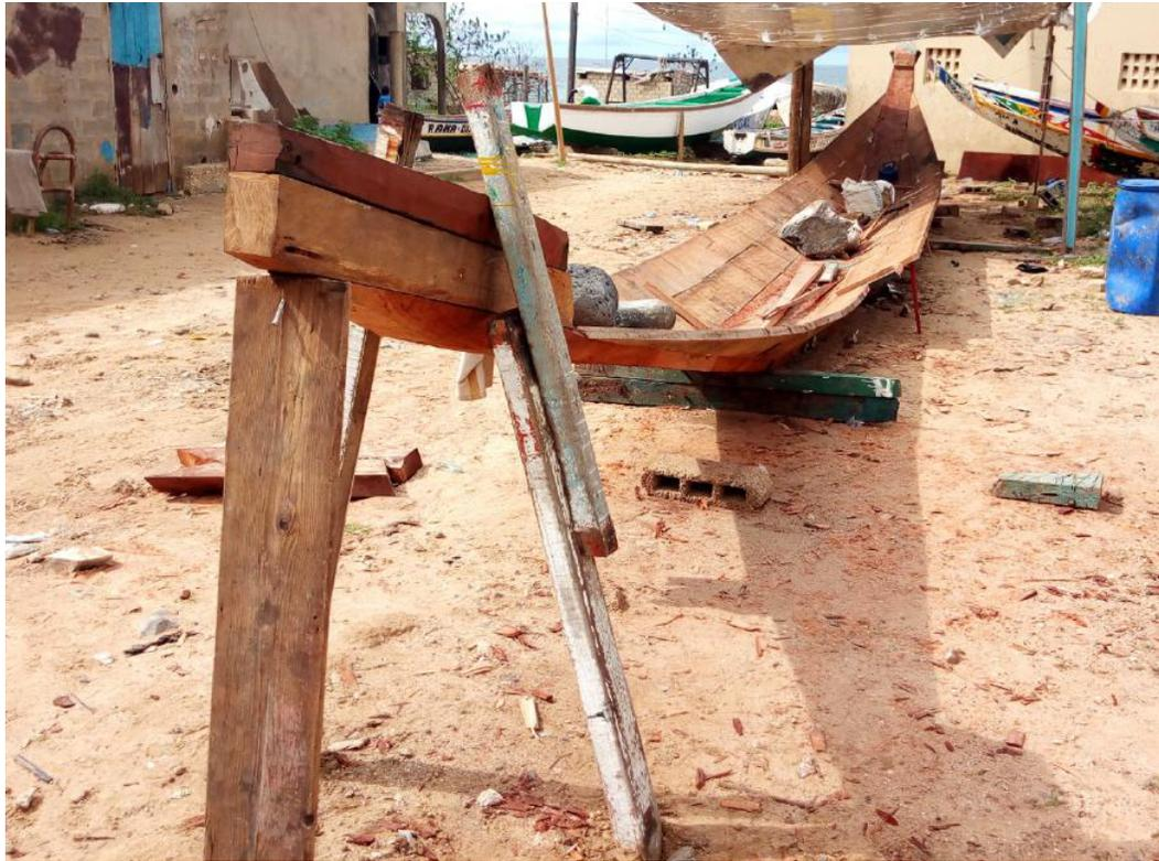
*Figure 16: Fixation des membrures (Photographie P. L. DIOP, 2019)*
