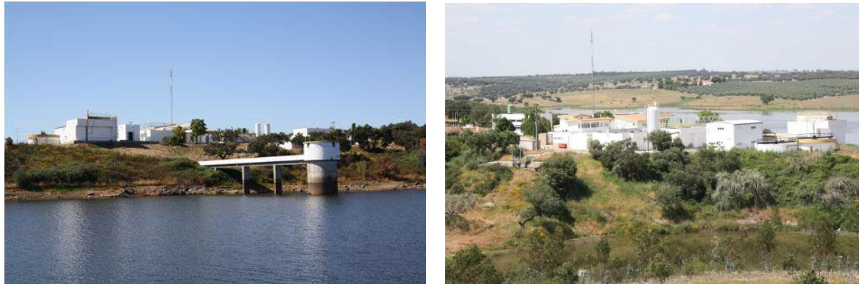
ETA de Monte Novo, Évora
