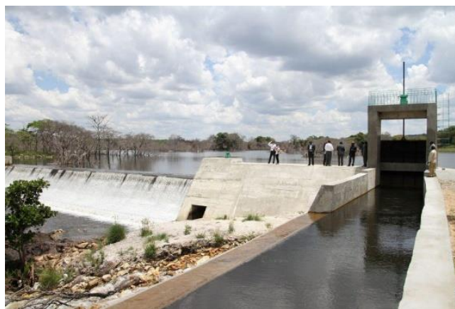
Figura 2.7 – Canal de adução [36].
