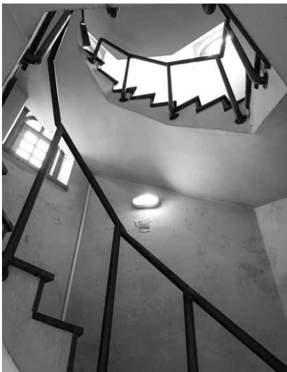
Figura 42 Na subida à torre da Casa Vieira Guimarães.
