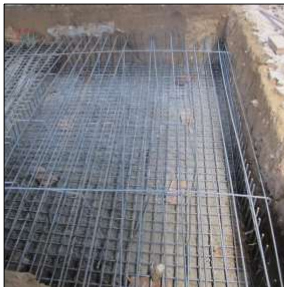
Figura 9. Armação de ferro para o betão.
