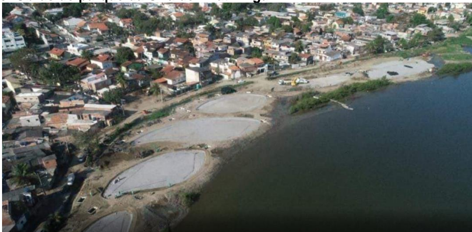
Figura 6: Obras do parque da Orla de Piratininga
