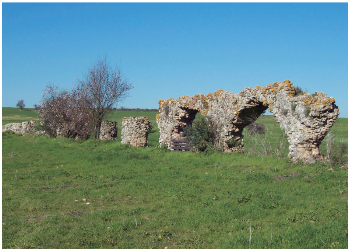
Figura 5. Aqueduto em Correio-Mor (Elvas), imagem de 2012.
