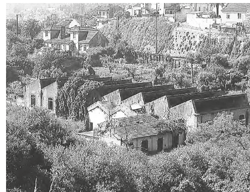
27. Vista para telhado em shed da Fábrica da Pólvora, Chelas.
