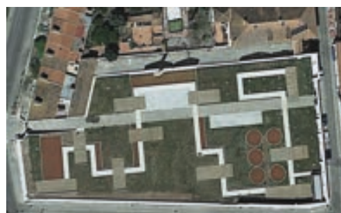
49. Vista aérea da antiga moagem, após a intervenção.
