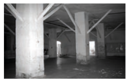
149. Vista do sótão nave industrial.
