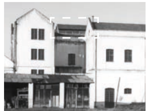
225. Vista do lanternim.
