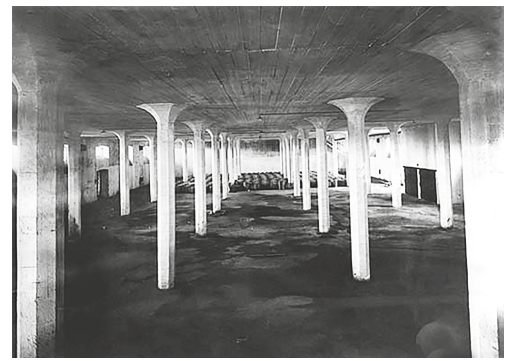
32. Armazém de cereais, Zúrich, 1912. Construído por Robert Maillart .
