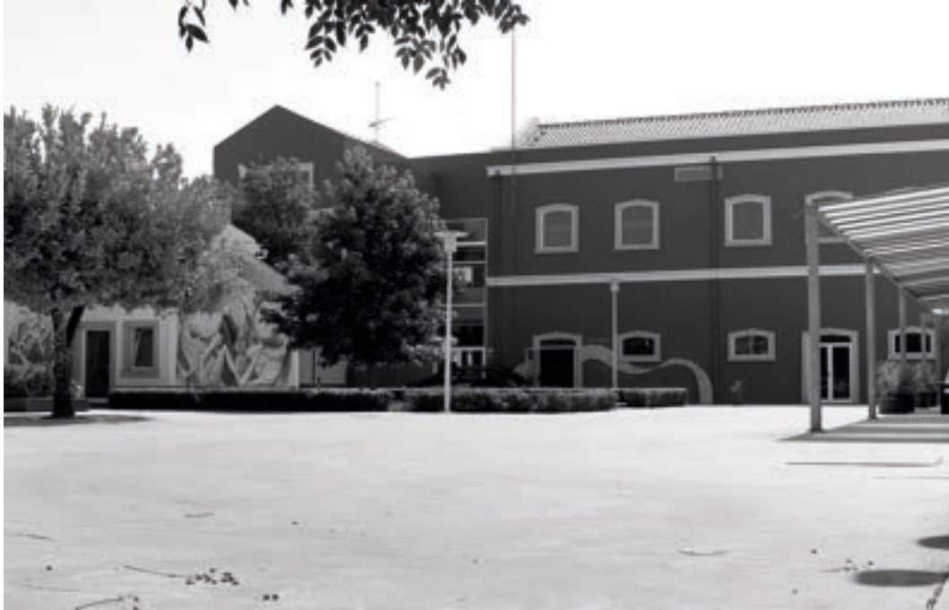
238. Vista Nascente do recinto e da fachada da antiga fábrica.
