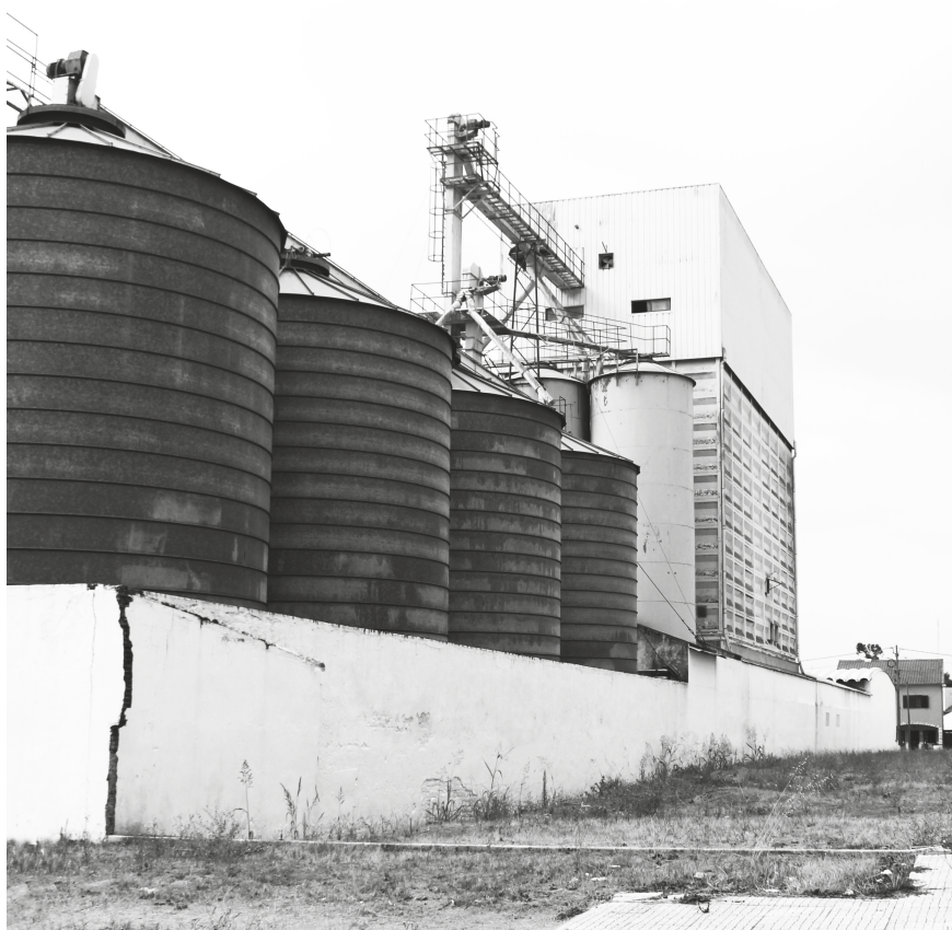
13. Silos, Ponte de Sor.
