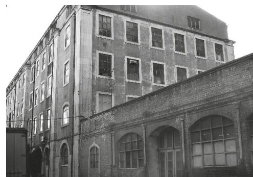
24. Vista a partir da entrada norte para Fábrica de Fiação e Tecidos de Algodão de Santo Amaro, Lisboa.
