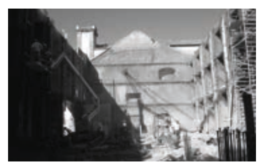
148. Vista da antiga nave fabril com as paredes estruturais.
