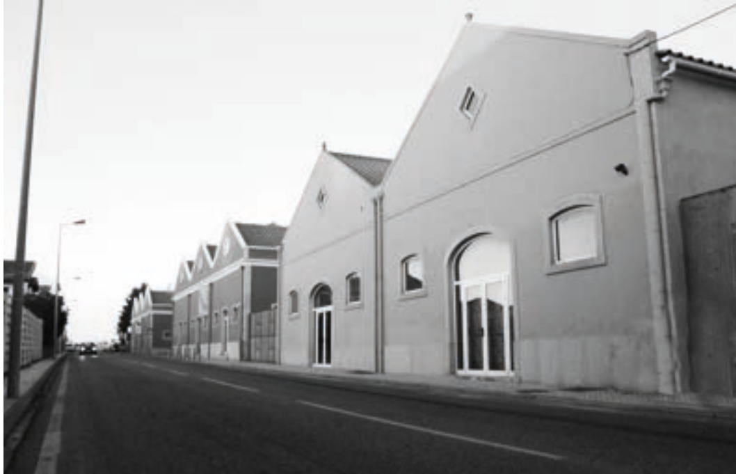
233. Perspetiva Sul da fachada principal da antiga fábrica, virada para a Avenida da Liberdade.
