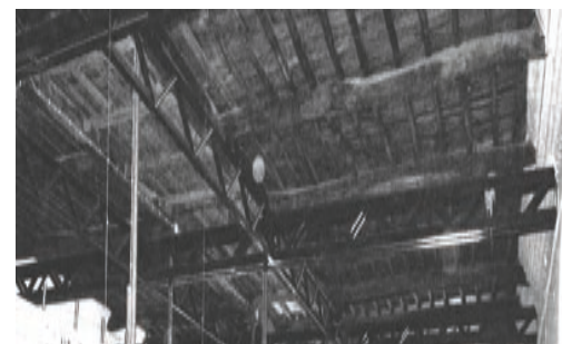
142. Vista da estrutura do pavimento do 2º piso.
