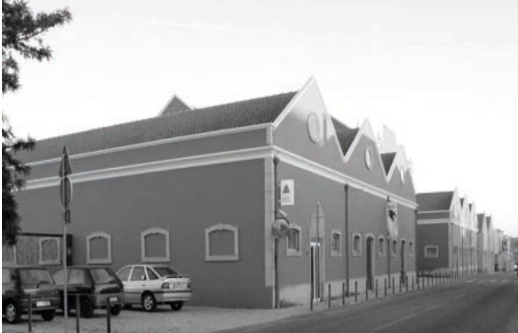
232. Perspetiva Norte da fachada principal da antiga fábrica, virada para a Avenida da Liberdade.
