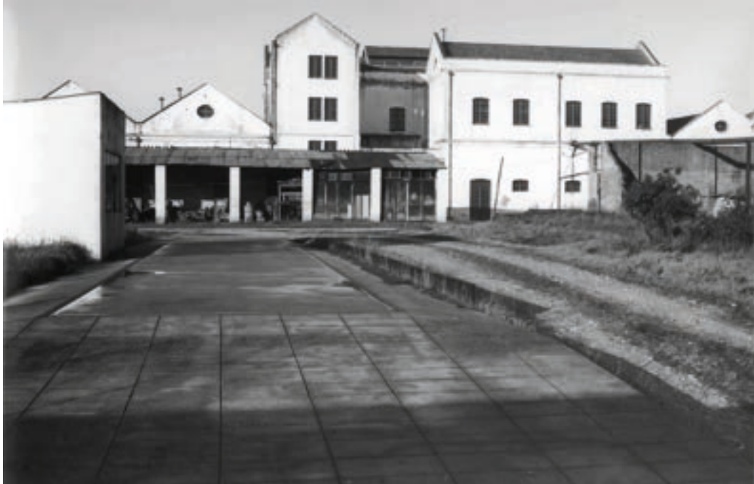
235. Vista Nascente do recinto e da fachada da fábrica. Em primeiro plano no solo, estrado e balança (capacidade até 60 toneladas); à esquerda, casa da balança.
