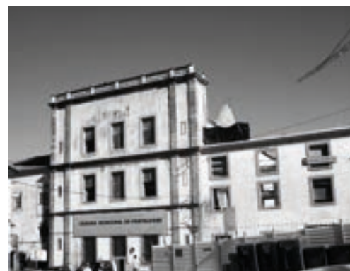
135. Vista fachada da antiga Igreja dos Jesuítas no decorrer das obras de requalificação.
