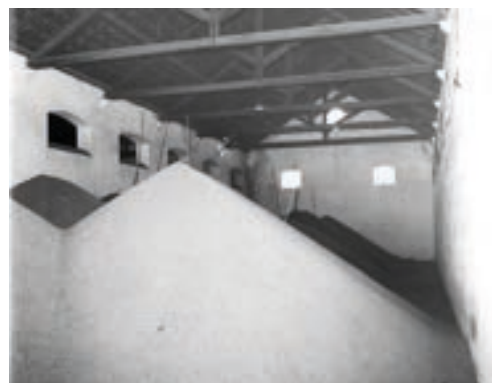
205. Interior de um dos pavilhões de armazenamento voltados a Norte, com grande quantidade de arroz a granel.
