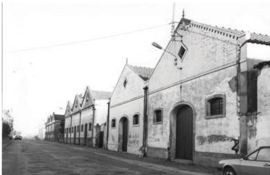
230. Perspetiva Sul da fachada principal da fábrica virada para a Avenida da Liberdade.
