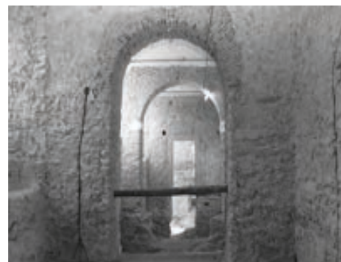
129. Colégio de São Sebastião no decorrer das obras de requalificação.
