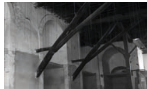
143. Vista das escoras de madeira inclinadas.
