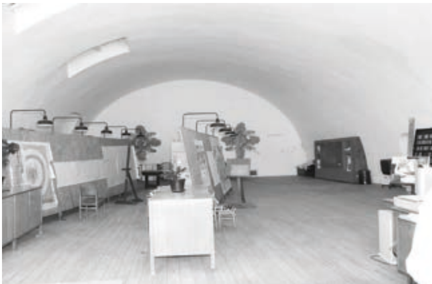
183. 2º piso das Tapeçarias de Portalegre. Antiga igreja de São Sebastião (observa-se na parede do fundo alguns vestígios do altar).
