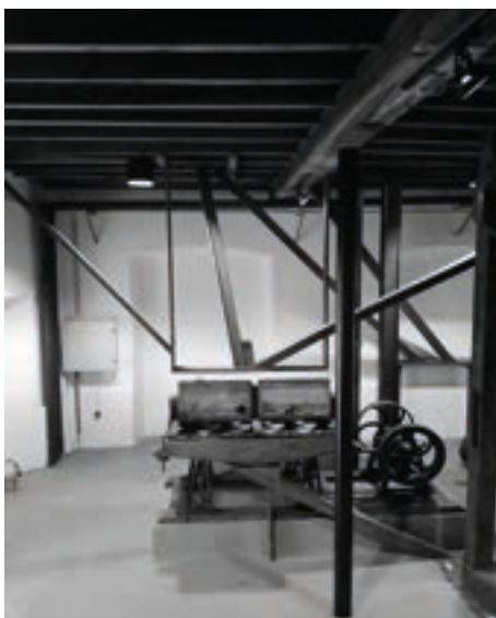
268. Espaço e maquinaria da secção de moagem em rama.
