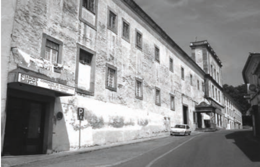
152. Perspetiva Sul da fachada principal da Fábrica, virada para Rua Guilherme Gomes Fernandes.
