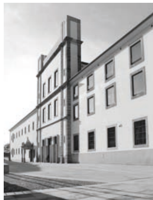
136. Fachada a Câmara Municipal de Portalegre, após as obras de requalificação.
