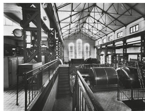
29. Sala das maquinas, Central Tejo, Lisboa.
