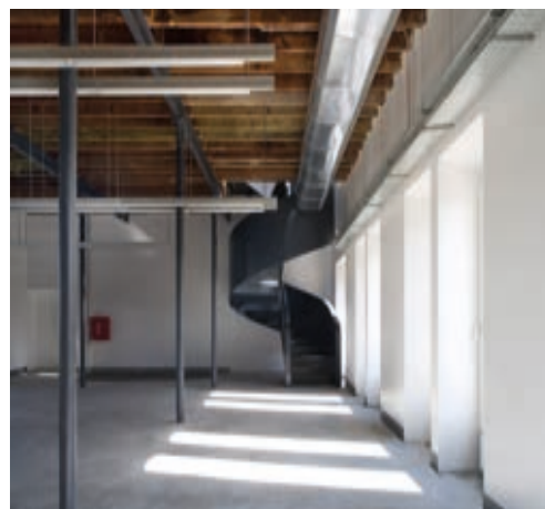
55. Polo dos Leões, edifício de arquitetura.
