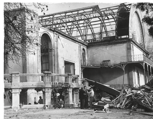
44. Demolição do Palácio de Cristal, fachada posterior, 1951.
