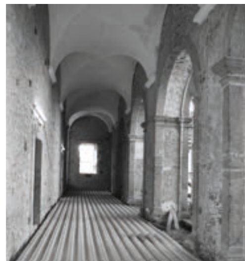
128. Colégio de São Sebastião no decorrer das obras de requalificação.
