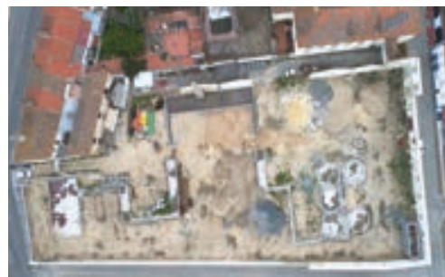
48. Vista aérea da antiga moagem em obras.
