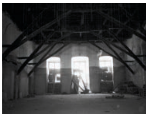
109. Vista da estrutura de madeira.
