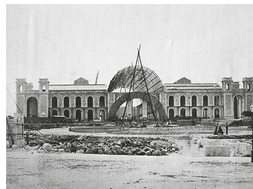
10. O Palácio de Cristal em construção.
