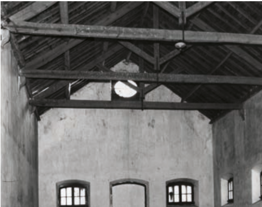
220. Interior de um dos pavilhões de armazenamento, onde se observa a estrutura original da cobertura.
