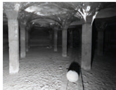
114. Vista do interior da cisterna de água.
