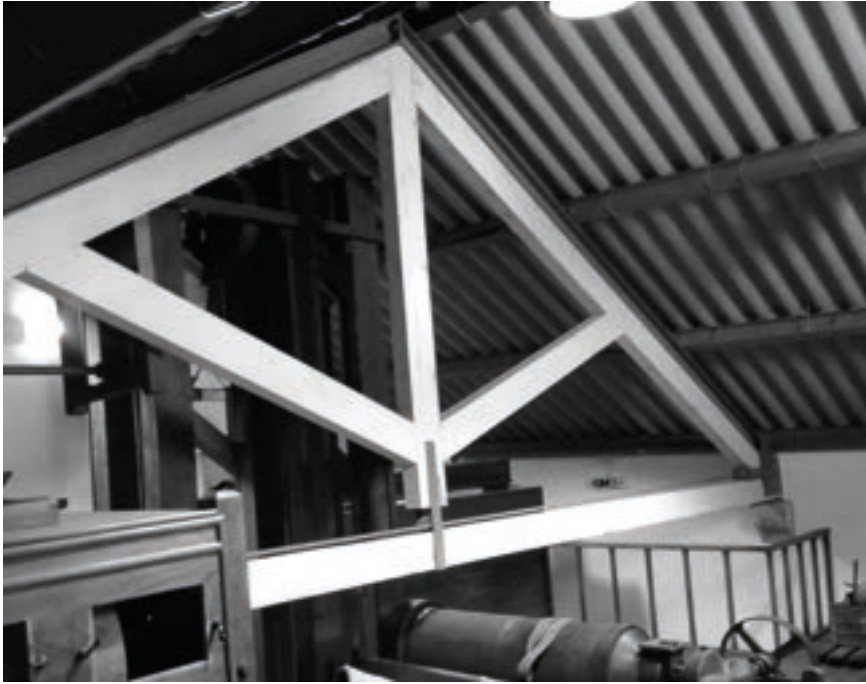
226. Interior do edifício da moagem, onde se observar a estrutura da cobertura requalificada.
