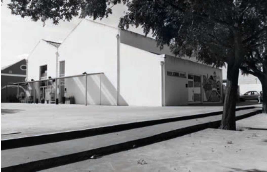
251. Vista da fachada do auditório.
