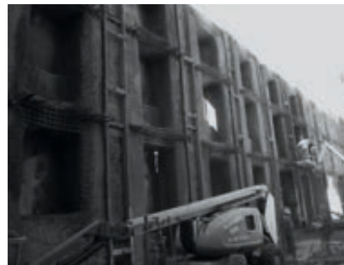
132. Nave industrial no decorrer das obras de requalificação.
