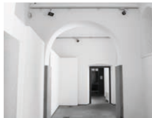
130. Colégio de São Sebastião após as obras de requalificação.
