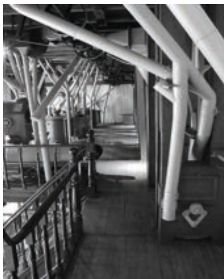
262. Vista para as tubagens de transporte.
