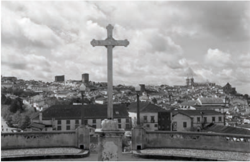
158. Perspetivada fachada Norte da Fábrica, vista do Calvário de Portalegre.
