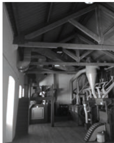
263. Espaço e maquinaria da secção de limpeza de arroz. Espaço e maquinaria da secção de limpeza de arroz.
