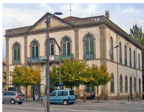
Figura 2 - Edifício CRCB - Fotografia 2006
