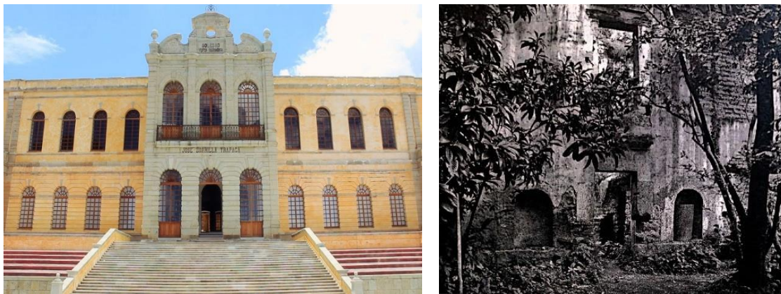
Figure 105. À gauche : Façade de l'ancienne usine textile de La Soledad ; à droite : ruines de l'ancien moulin de San Diego.
