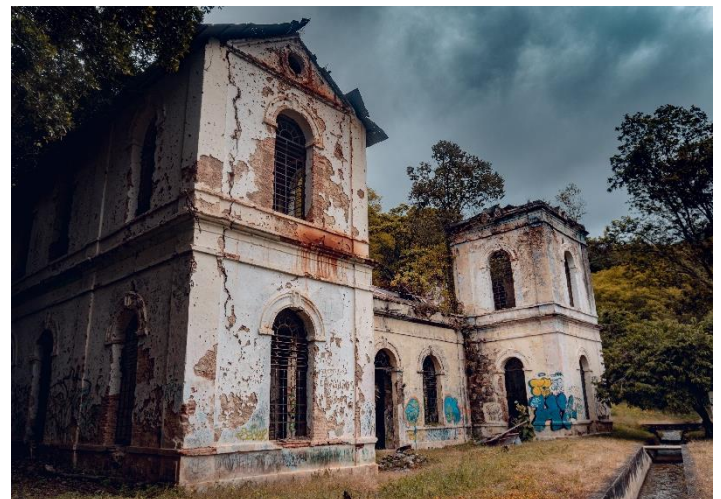
Figure 94. État actuel de l'ancienne centrale hydroélectrique de La Luz . Façade sud
