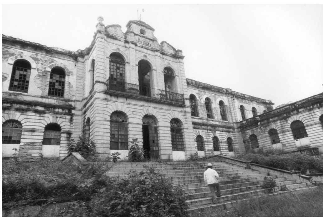
Figure 77. Façade principale Ancienne usine textile La Soledad avant sa restauration en 2000.
