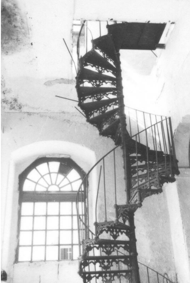
Figure 63. Escalier métallique en usine La Soledad . Source: Photographie Architecte Claudina López.
