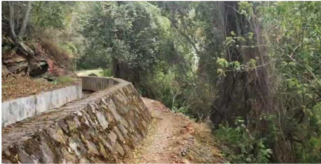
Figure 70. Infrastructure de canalisation des eaux de l'ancienne centrale hydroélectrique de La Luz . Source: Photographie Arturo Salinas
