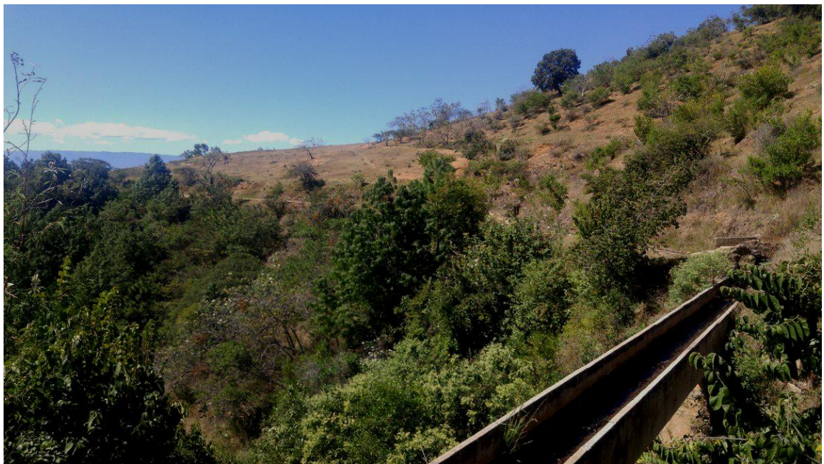
Figure 111. Pointe de vue et canalisation d'eau d'hydroélectrique La Luz à l'usine de La Soledad .
