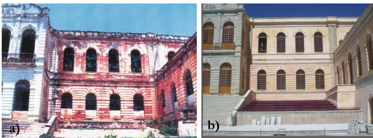
Figure 78. Détail de la façade a) avant sa restauration en 2000; b) après sa restauration en 2006. Source: Photographies Architecte Claudina López.
