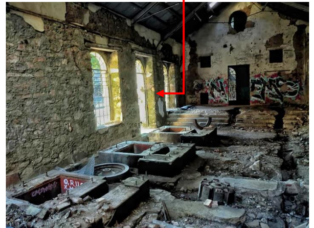
Figure 98. Intérieur de la salle des machines. Source : Photographie Arturo Salinas
