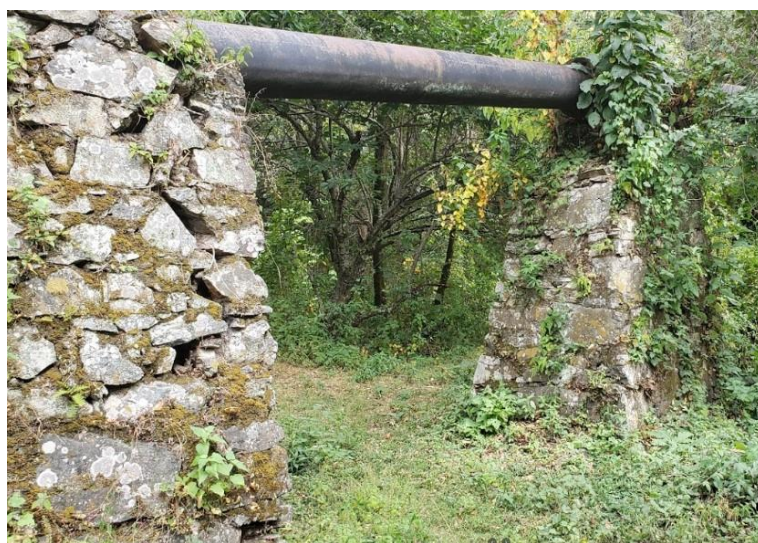
Figure 42. Infrastructure pour la canalisation de l'eau. Source : Photographie Arturo Salinas
