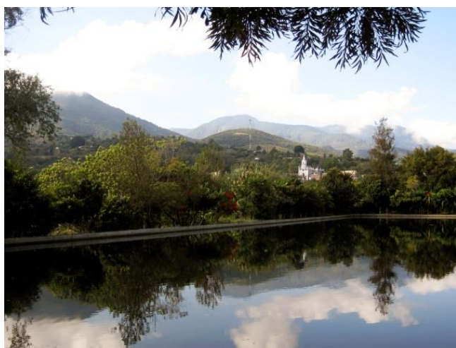
Figure 107. Réservoir d'eau. Source : Photographie Manuel Soriano.
