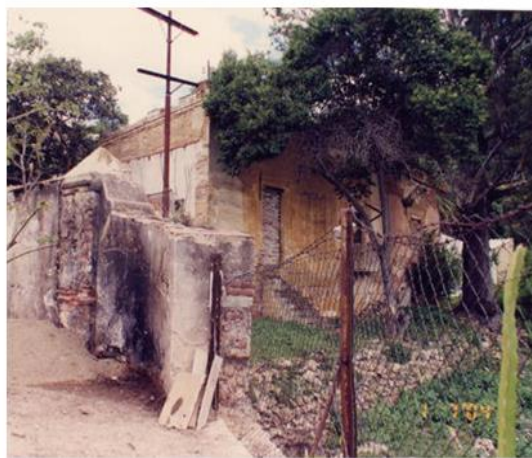
Maison des travailleurs Maison chambre
