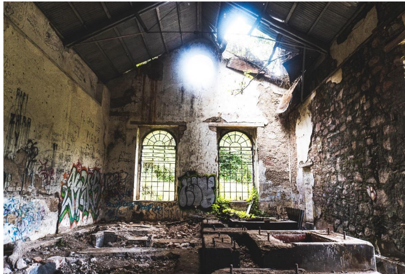
Figure 54. Intérieur de l'ancienne Hydroélectrique La Luz . Source : Photographie de Bruno Vallejo.
