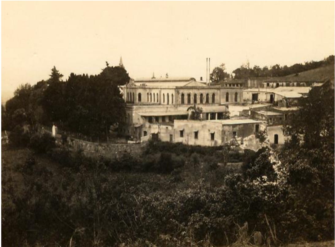
Figure 69. Construction de l'usine textile La Soledad . On peut voir le changement drastique qui a impacté le paysage. Source : Photographie Veronica Espinosa
