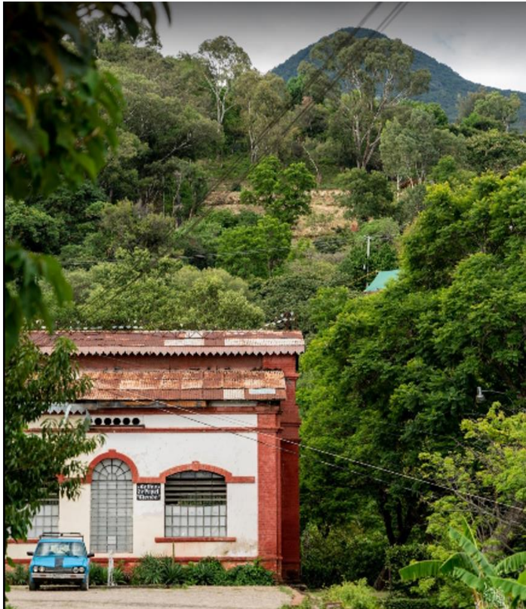
Figure 76. Ancienne Hydroélectrique La Soledad . Source: Taller Arte Papel Oaxaca
