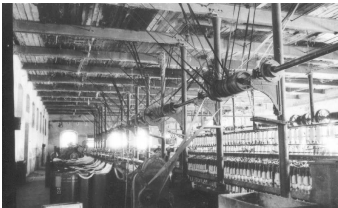
Figure 59. Rez-de-chaussée Usine La Soledad. On observe les colonnes de fonte dans ce qui était le salon pour machines de filature. Source: Photographie Architecte Claudina López
