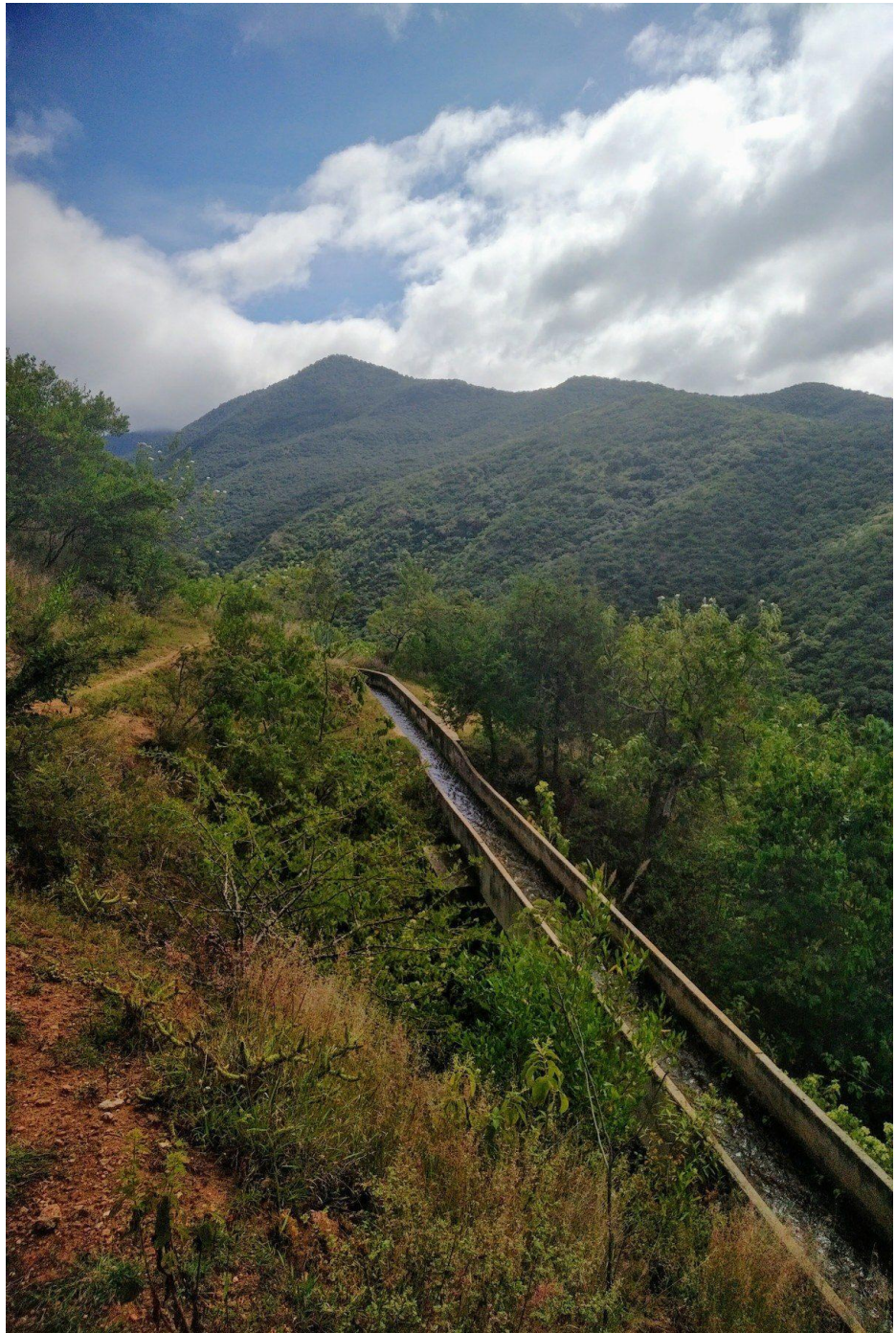
Figure 50. Canalisation d'eau de la central hydroélectrique La Luz vers l'usine La Soledad . Source: Photographie de Arturo Salinas
