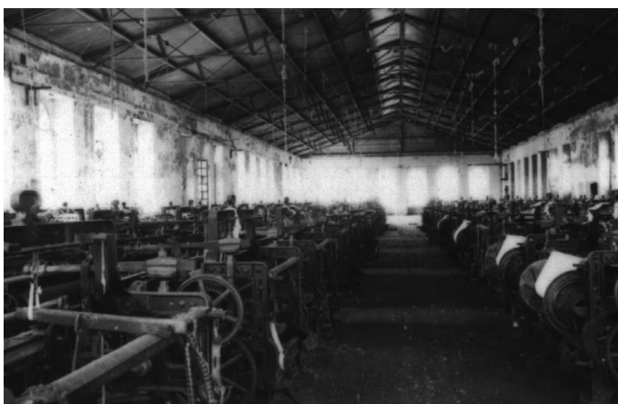
Figure 60. Premier étage Usine La Soledad, salle des métiers à tisser. Avant du remodelage. Source: Photographie Architecte Claudina López
