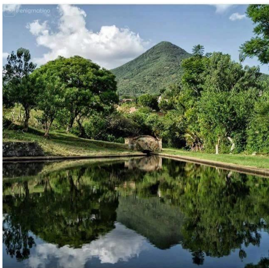
Figure 41. Réservoir de stockage dans San Agustín Etla. Source : Photo Site Web de la municipalité
