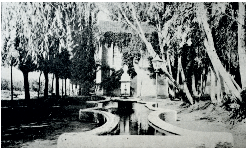
Um aspecto da instalação das aguas medicinaes de Fadagosa de Marvão
