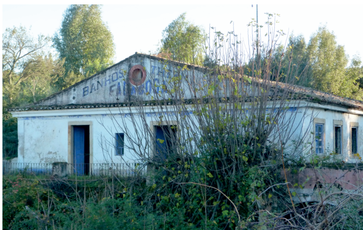
Fig. 13: Pormenor da ruína de um dos edifícios da Fadagosa
