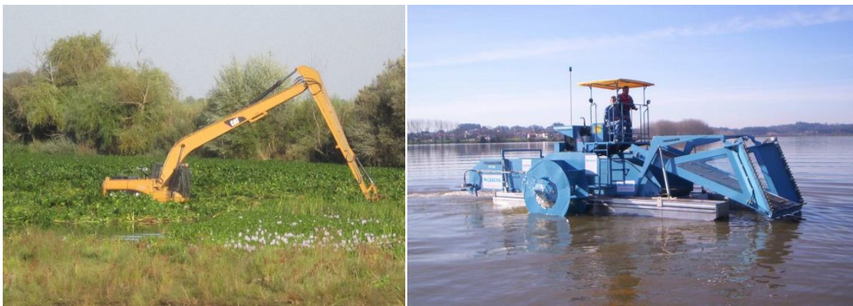
FIGURA 6: REMOÇÃO MECÂNICA DO JACINTO-AQUÁTICO A PARTIR DA MARGEM UTILIZANDO A MÁQUINA GIRATÓRIA (ESQUERDA – RIO SORRAIA; SETEMBRO 2019) E NO LEITO DA MASSA DE ÁGUA RECORRENDO A UMA CEIFEIRA-AQUÁTICA (DIREITA – FOTOGRAFIA: CÂMARA MUNICIPAL DE ÁGUEDA; PATEIRA DE FERMENTELOS).
