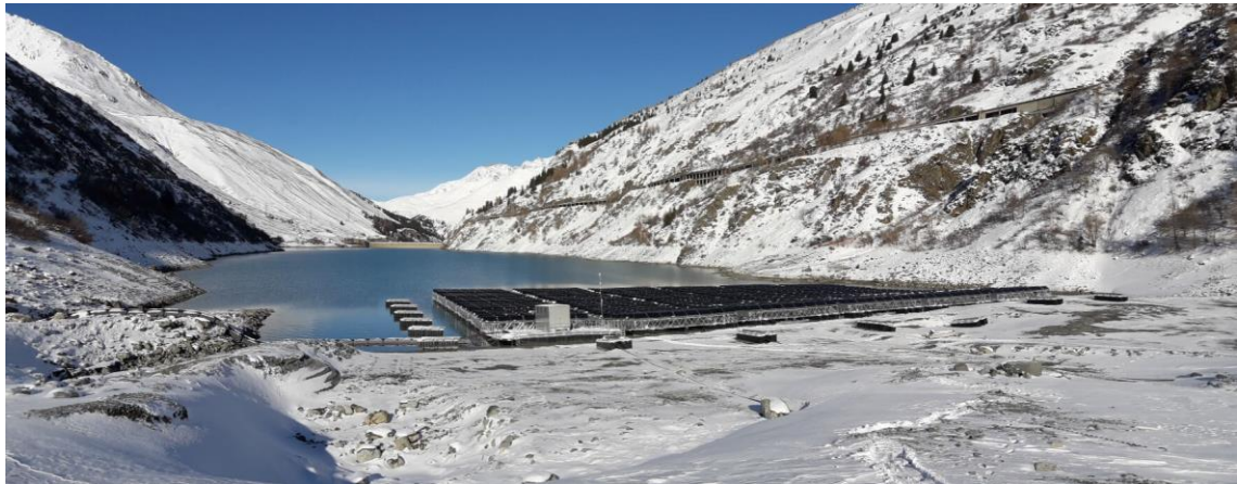
Figura 5. Sistema fotovoltaico, Alpes Suíços, 448 kWp
