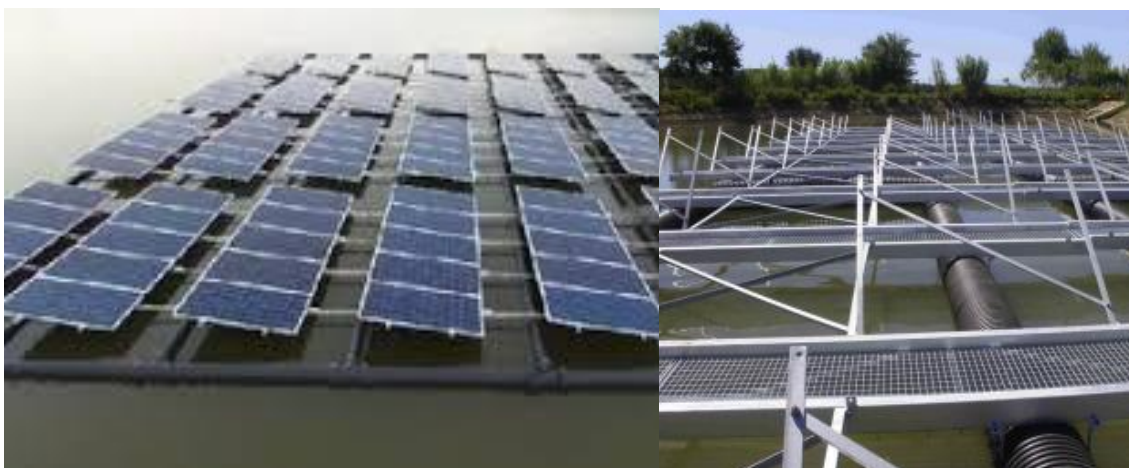
Figura 8. Pontão e estrutura metálica [10]
