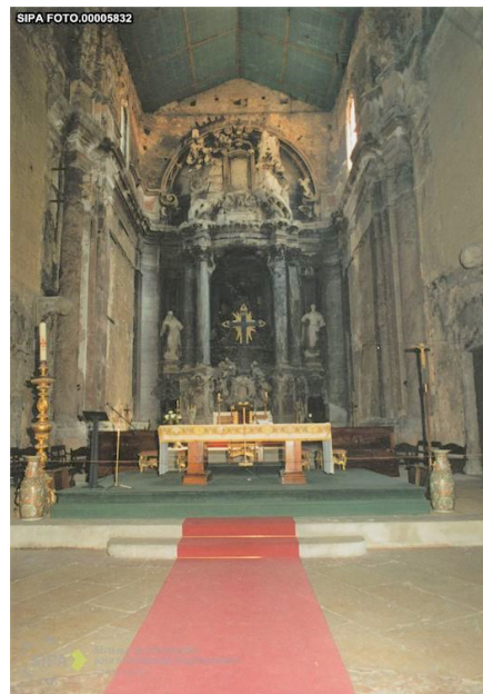
Fig.42. Nave da igreja após a instalação da cobertura de duas águas revestida a estafe verde. © SIPA, IPA.00005258, FOTO.00005832
