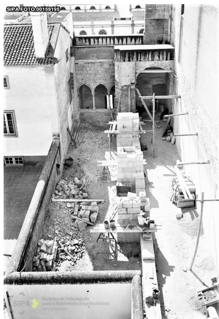
Fig.74. Obras de reconstrução da ruína do claustro. © SIPA, IPA.00002724, FOTO.00159195.
