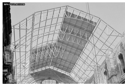
Fig.61. Montagem do ripado em perfis de chapa sobre a estrutura metálica. © SIPA, IPA.00005258, FOTO.00112195
