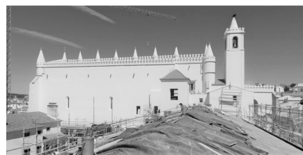
Fig.95. Execução da cobertura da ala das celas, revestida a tijoleira de terracota. © Fábrica da Igreja Paroquial da Freguesia de S. Pedro
