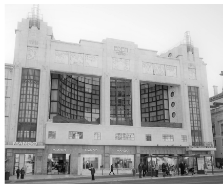
Fig.27. Cineteatro Éden em Lisboa. Em 1990 foi alvo de demolição interior e reconstruído para acolher um apart-hotel, obra de Frederico Valsassina e George Pencreach. © http://www.jornalarquitectos.pt/pt/jornal/j-a-256/o-fachadismo-da-reabilitacao
