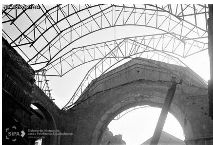
Fig.59. Montagem da nova estrutura metálica do cruzeiro. © SIPA, IPA.00005258, FOTO.00112264
