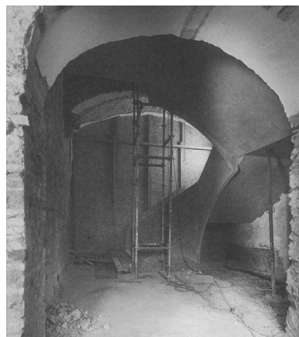
Fig.102. Construção da caixa de escadas em betão armado e de desenho contemporâneo. © Manuel Ribeiro
