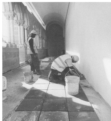
Fig.101. Aplicação do revestimento de pavimento em tijoleira na ala norte do claustro. © Manuel Ribeiro
