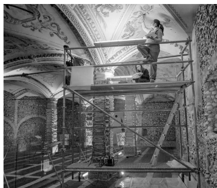
Fig.108. Trabalhos de conservação e restauro na abóbada da Capela dos Ossos © Hugo Rainho
