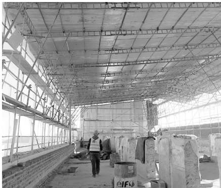
Fig.103. Obra na antiga ala das celas - à esquerda nota-se arranque da nova parede em alvenaria de tijolo maciço; à direita notam-se as paredes existentes com pinturas sobre estuque. © Gepectrofa
