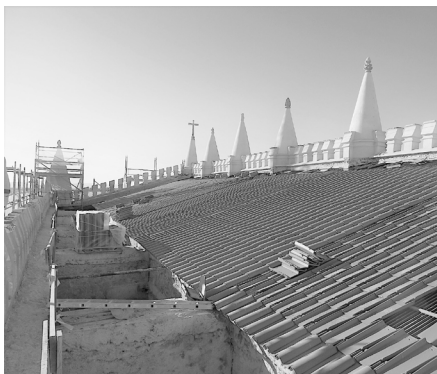
Fig.93. Montagem da cobertura da nave, utilizando o sistema de cobertura de telha romana para canal e de canudo em cobrideira. © Gepectrofa
