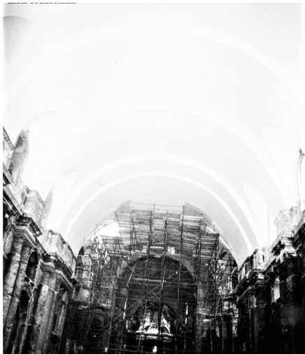
Fig.63. Fotografia do final da 2ª empreitada, vê-se a cobertura já com revestimento de estafe pintada a branco. © SIPA, IPA.00005258, FOTO.0054195.
