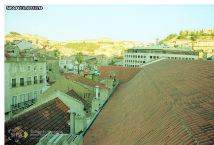
Fig.62. Telhado da igreja revestida a telha lusa pigmentada. © SIPA, IPA.00005258, FOTO.00112218
