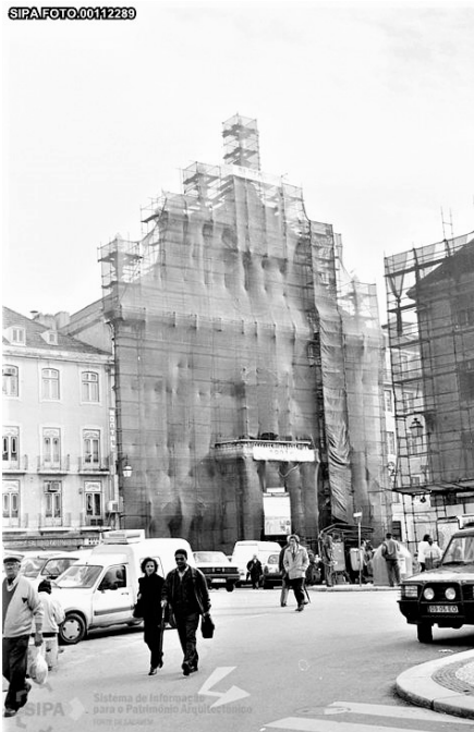
Fig.67. Fotografia captada durante os trabalhos de reparação da fachada principal. © SIPA, IPA.00005258, FOTO.00112289.
