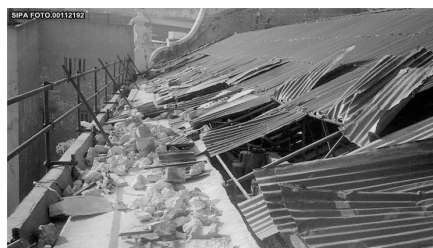
Fig.56. Desmorte da cobertura em chapa metálica existente. © SIPA, IPA.00005258, FOTO.00112192
