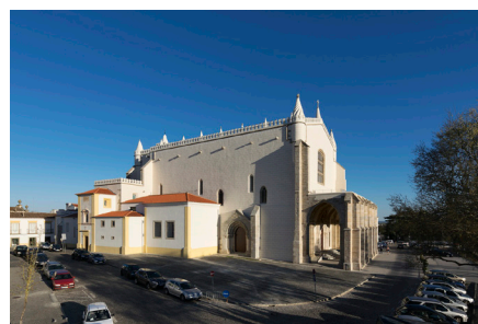
Fig.78. Vista sobre a fachada norte do conjunto. © Manuel Ribeiro
