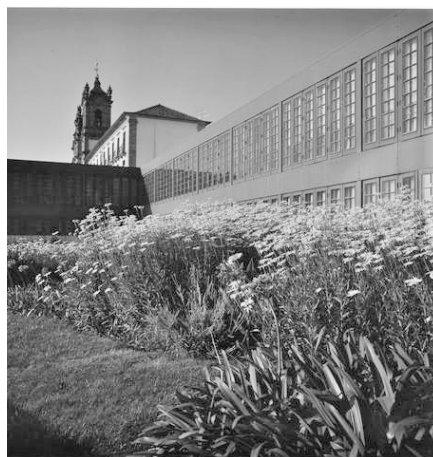
Fig.29. Vista exterior das traseiras da Pousada de Santa Marinha de Guimarães, projeto coordenado por Fernando Távora. © Fundação Instituto Arquitecto José Marques da Silva. PT FIMS TAV-2-2.2-2.2.3-2.2.3.1-2.2.3.1.2-01-0179-foto0018
