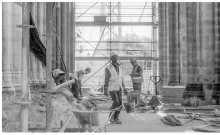
Fig.97. Obra na galilé da igreja, vê-se o entulho resultante das demolições da antiga escadaria. © Tribuna Alentejo
