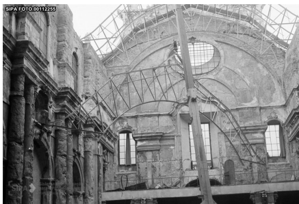
Fig.60. Montagem da nova estrutura metálica da nave. © SIPA, IPA.00005258, FOTO.00112255
