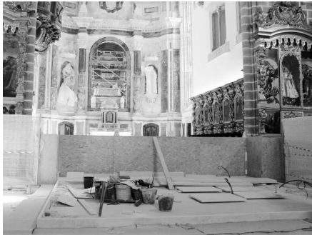
Fig.98. Montagem da plataforma de mármore branco sobre a qual se colocou o altar e o ambão. © Rádio Renascença
