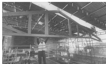
Fig.96. Montagem das asnas metálicas sobre lintel de betão, para a nova cobertura da ala das celas. © Manuel Ribeiro
