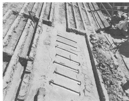
Fig.90. Consolidação das abóbadas, conseguida pelo seu gateamento. © Manuel Ribeiro
