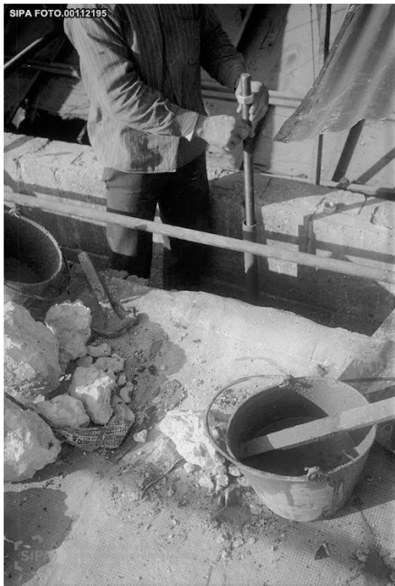
Fig.58. Inserção do tubo de aço galvanizado no furo vertical executado no coroamento das paredes laterais da nave. © SIPA, IPA.00005258, FOTO.00112195
