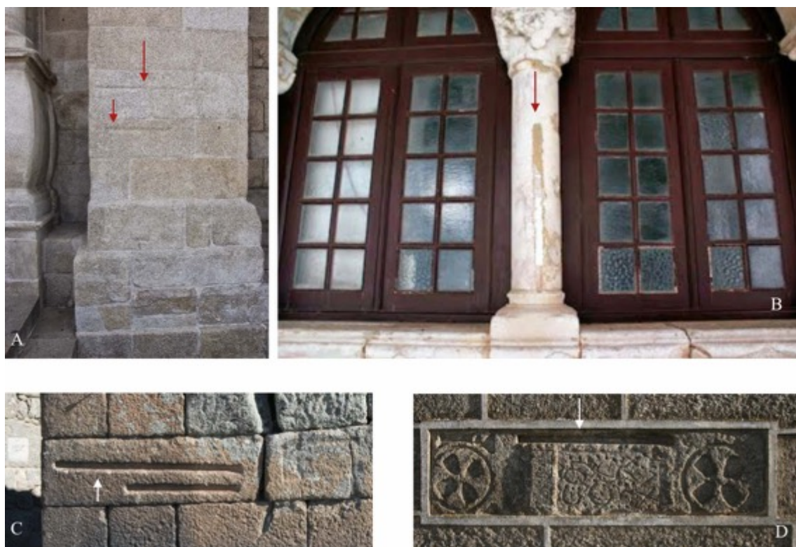
Figura 36. Medidas-padrão gravadas na pedra, segundo Mário Barroca. A- côvado e braça gravados na sé do Porto; B- côvado gravado no paço do concelho de Estremoz; C- côvado e braça gravados nas portas de muralhas de Sortelha; D – côvado gravado na igreja da Misericórdia do Sabugal.
