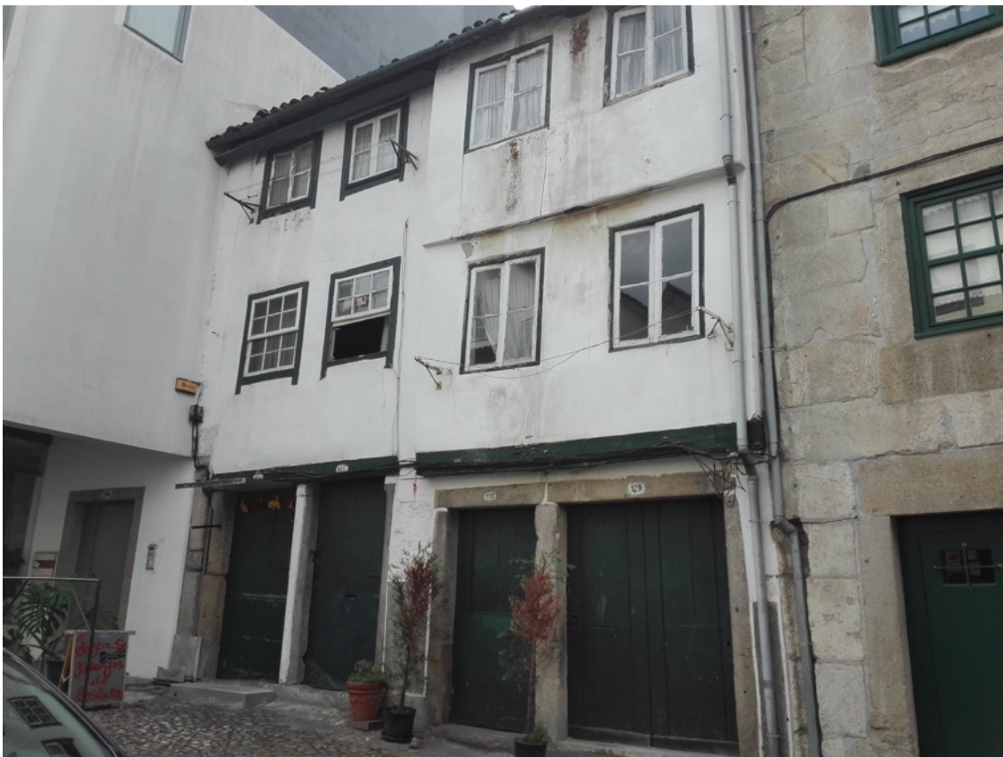
Figura 23. Braga. Exemplo de casa com pilastra e arquitrave na rua da Violinha, perto da praça do Peixe (atual praça Velha), em Braga (fotografia Daniela Pereira, 2017).
