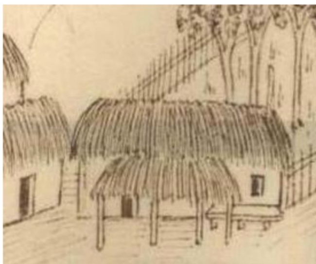
Figura 44. Portelo. Alpendre com cobertura de colmo, desenhado por Duarte de Armas (1508-1509). ANTT, Livro das Fortalezas, fl. 99.
