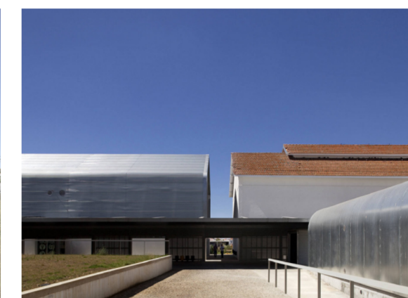
Fig. 152 - Fachada edificio C y B.
