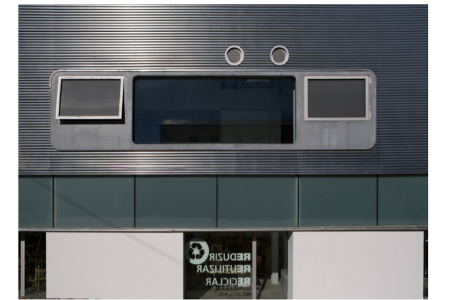
Fig. 166 - Materialidad edificio C.
