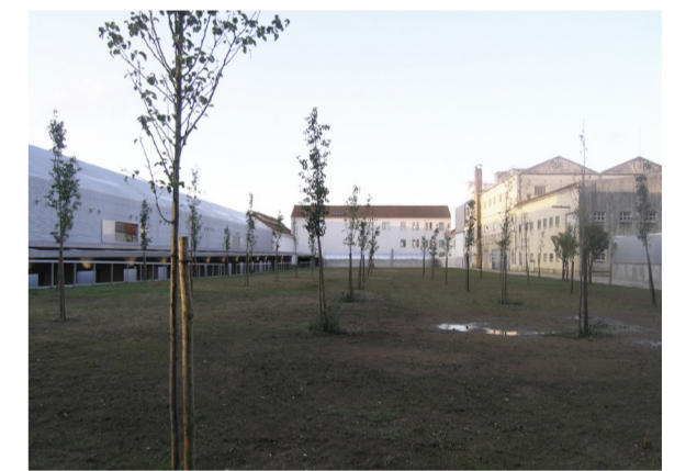
Fig. 168 - Vista exterior del Complejo.
