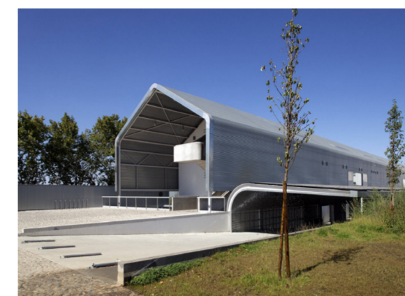
Fig. 150 - Fachada del edificio C y cobertizo.
