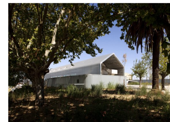
Fig. 165 - Encuentro de la naturaleza con el nuevo edificio C.
