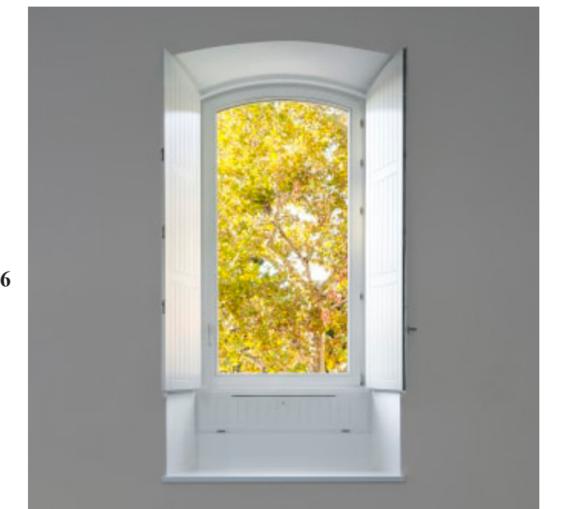
Fig. 46 - Acondicionamiento de ventanas preservando lo antiguo.
