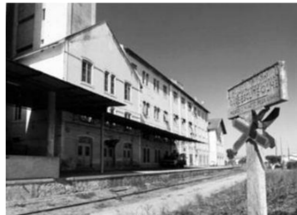
Fig. 135 - Plataformas de cargas y descargas de tren.
