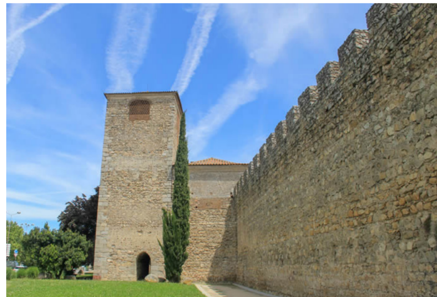
Fig. 129 - Muralla vista desde extramuros de la ciudad.
