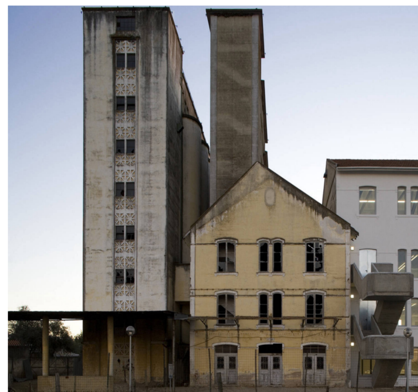
Fig. 181 - Estado actual del los silos.
