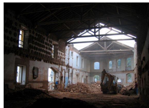
Fig. 57 - Proceso de demolición interior.
