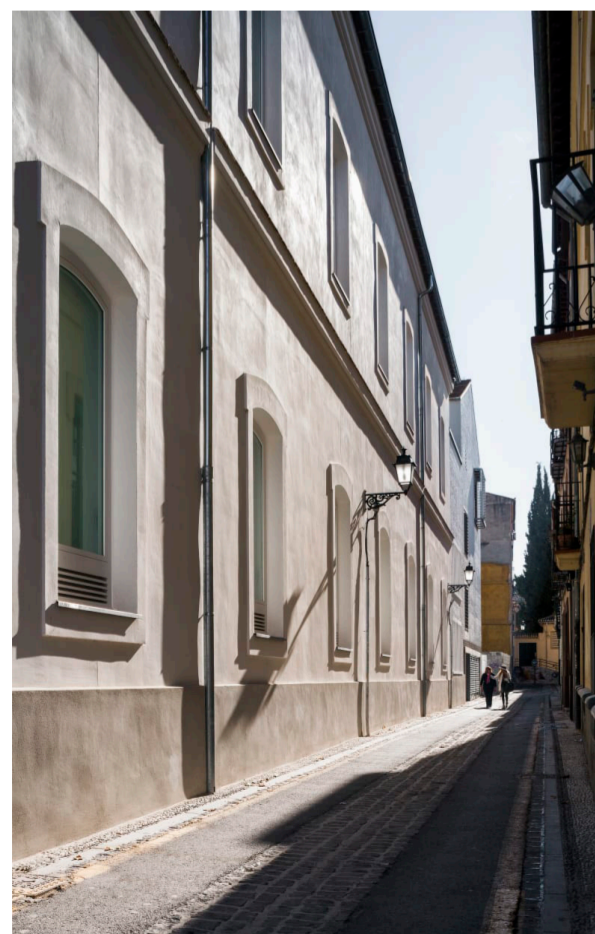
Fig. 23 - Fachada exterior ETSAG.
