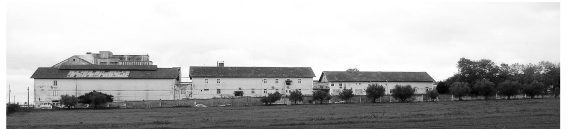
Fig. 148 - Fachada exterior antigua.
