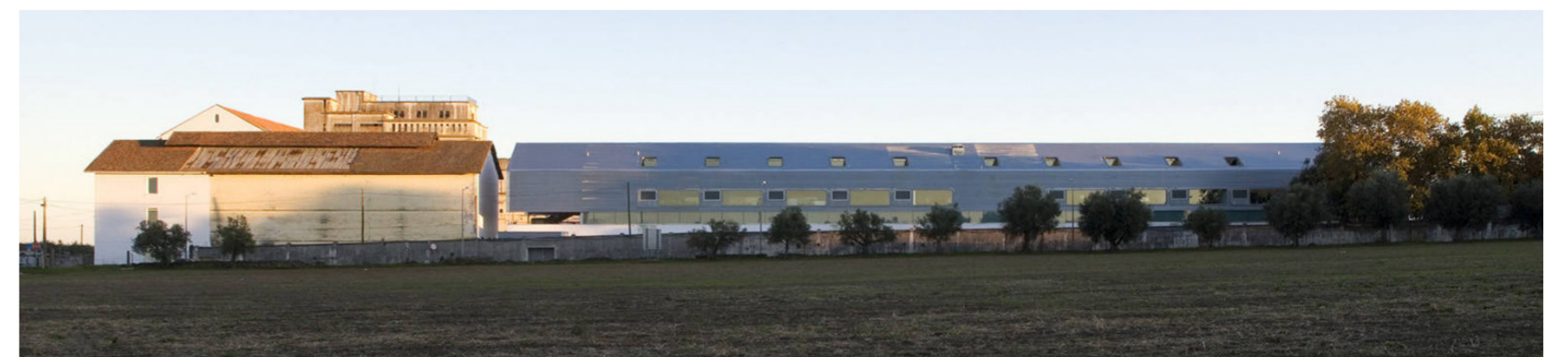
Fig. 149 - Fachada exterior nueva.
