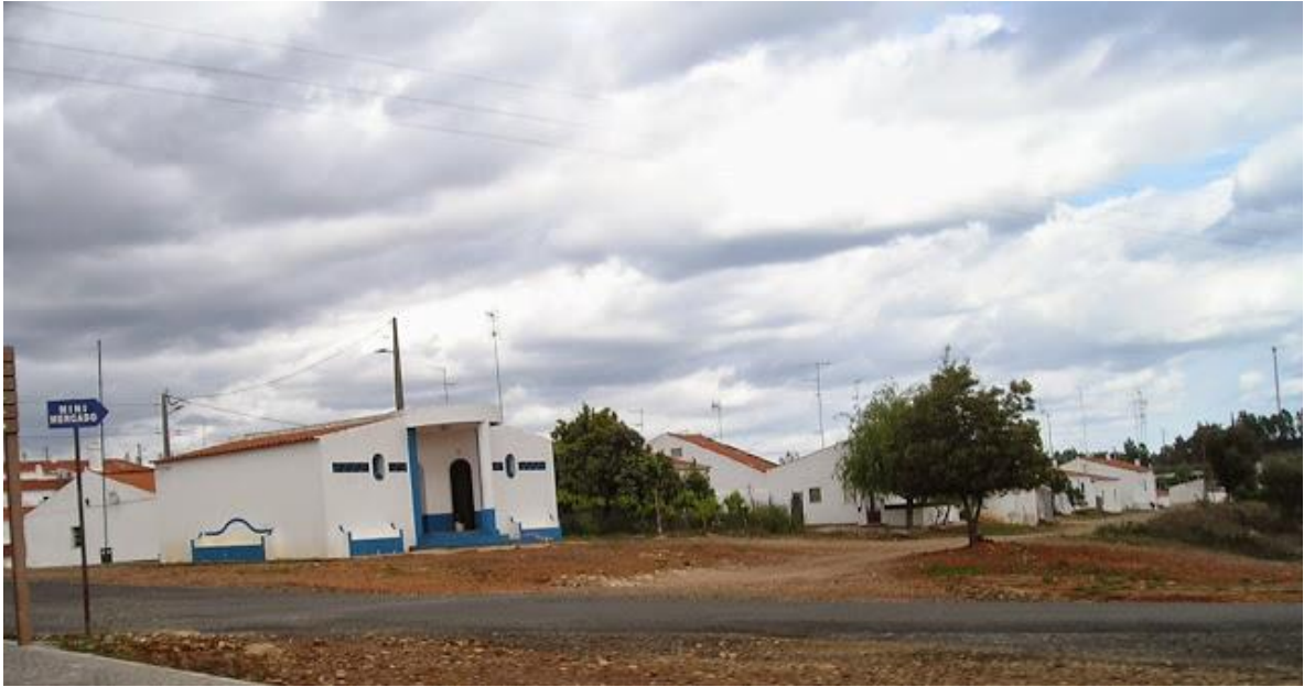
Figure 3 : Les maisons des ouvriers du Village minier de Sao Domingos
