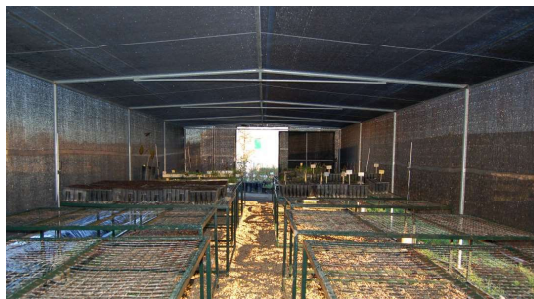
Figura 37. Umbráculo para el control de la radiación, la temperatura y la humedad durante el periodo más desfavorable en el suroeste peninsular (15 de junio a 15 de octubre).
