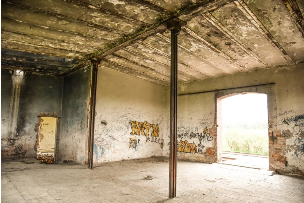
Figure 42 – Système employé pour bâtir les toits des certaines gares. Ici, des poutrelles en fer (plusieurs fois, des rails étaient utilisés) conformément la structure qui soutient le toit. Le toit a été bâti aussi en utilisant des poutrelles en fer qui soutient des voûtes faites en brique. Il s’agit de l’intérieur de la gare de Tecuac, du Ferrocarril Interoceánico .
