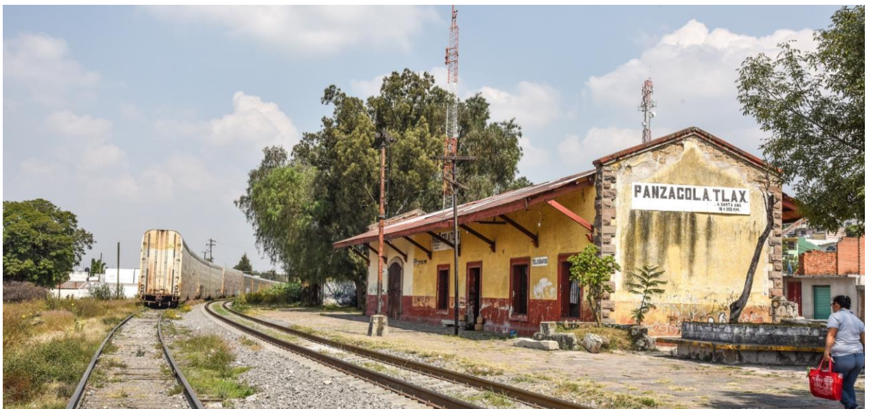
Vue panoramique du côté droit de la façade de la gare et du quai.
