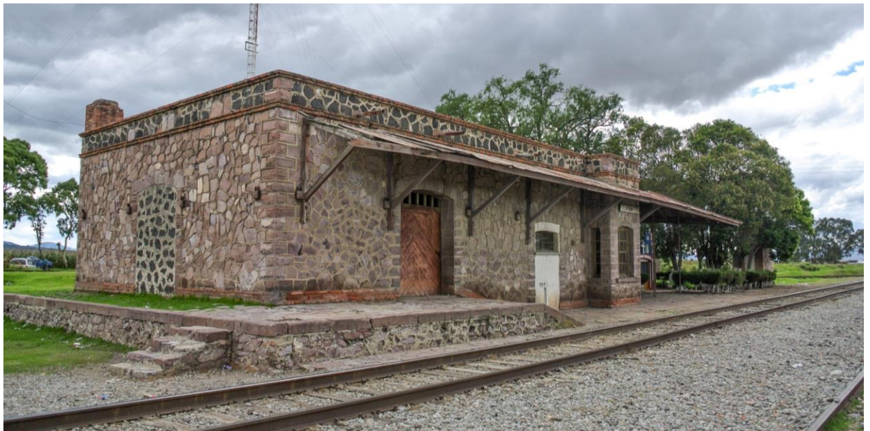
Vue du côté gauche de la façade de la gare et du quai.
