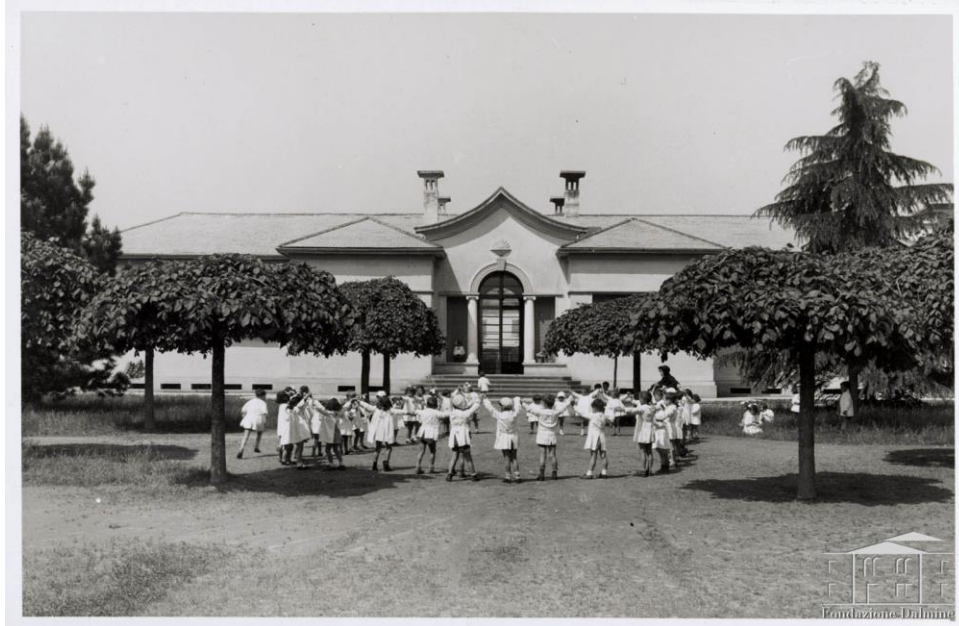
Figure 22 – Une des écoles à Dalmine
