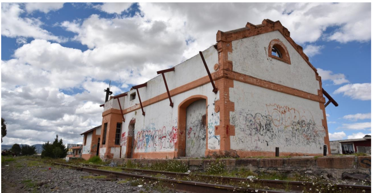
Vue du côté droit de la façade de la gare et du quai.
