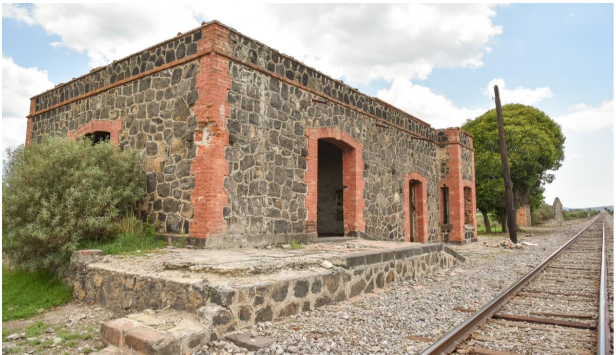
Vue du côté gauche de la façade de la gare et du quai.
