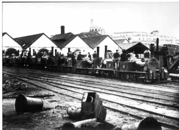
Figure 26 – Des locomotives à côté des hangars
