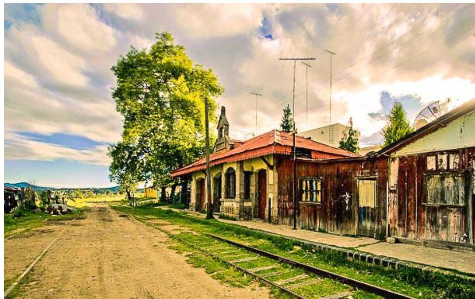
Vue panoramique du côté droit de la façade de la gare et du quai.
