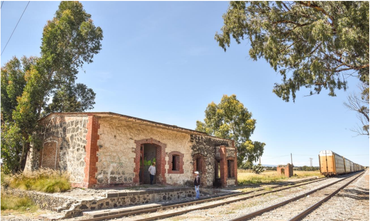
Vue panoramique du côté gauche de la façade de la gare et du quai.
