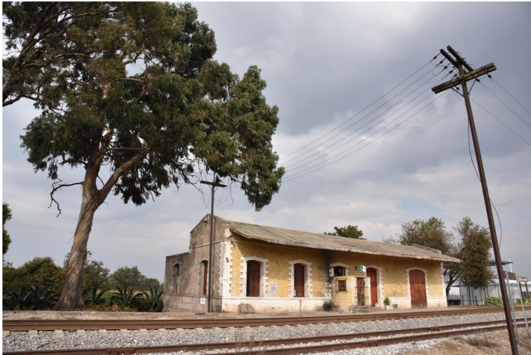
Vue panoramique du côté gauche de la gare.
