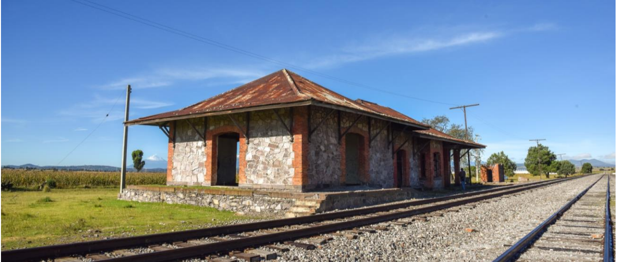
Vue panoramique du côté gauche de la façade de la gare et du quai.
