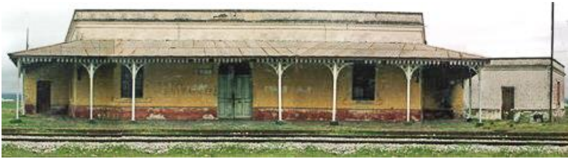
Vue frontale de la façade de la gare et du quai.
