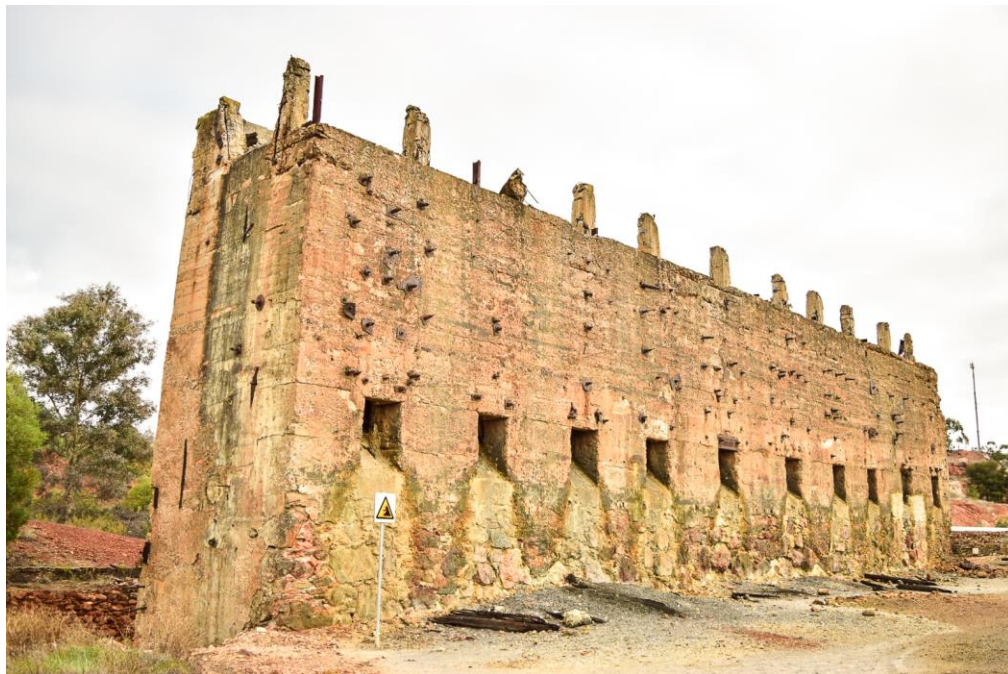
Figure 9 – Bâtiment à São Domingos. Photo prise le 29 novembre 2019.
