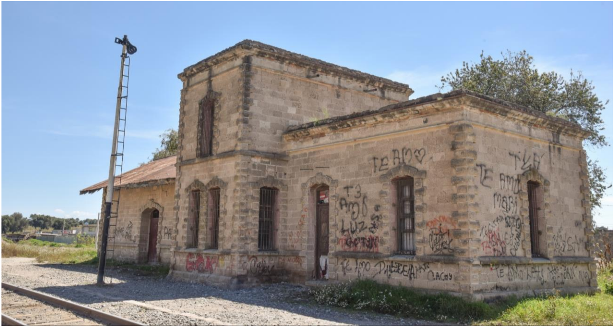
Vue du côté droit de la façade de la gare.
