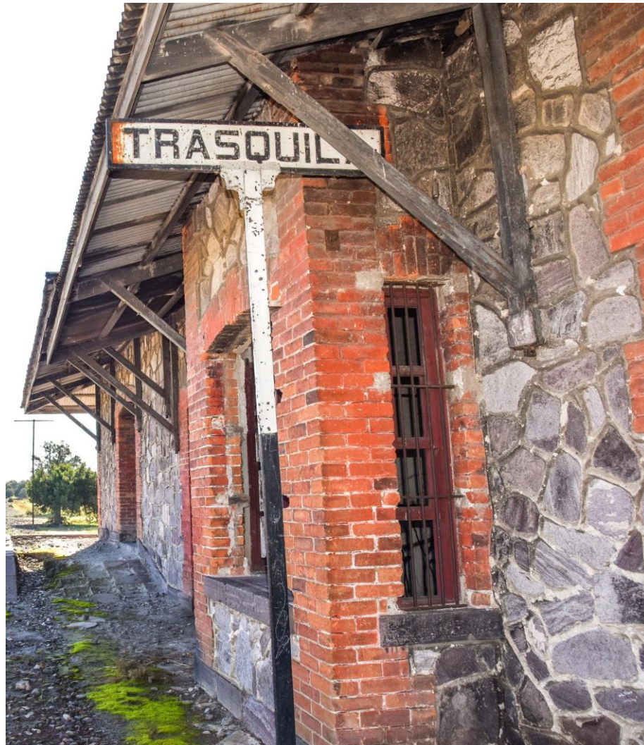
Figure 47 – Des éléments architecturaux présentes dans la gare La Trasquila. L'exemple de cette gare est utile pour illustrer comment ont été bâties les fenêtres en baie, lesquelles étaient utilisés surtout pour que les employés du telegraphe pouvaient monitorer l'arrivée et le départ des trains depuis cette position. Ici, il est possible aussi d'apprécier une partie du toit pyramidal : on peut noter la structure en bois et les tôles en zinc. Cette gare garde encore ses fenêtres faites en bois et en verre. Ces attributs étaient caractéristiques spécialement au sein des gares du Ferrocarril Interoceánico.
