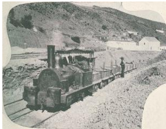
Figure 27 – Ligne São Domingos - Pomarão
