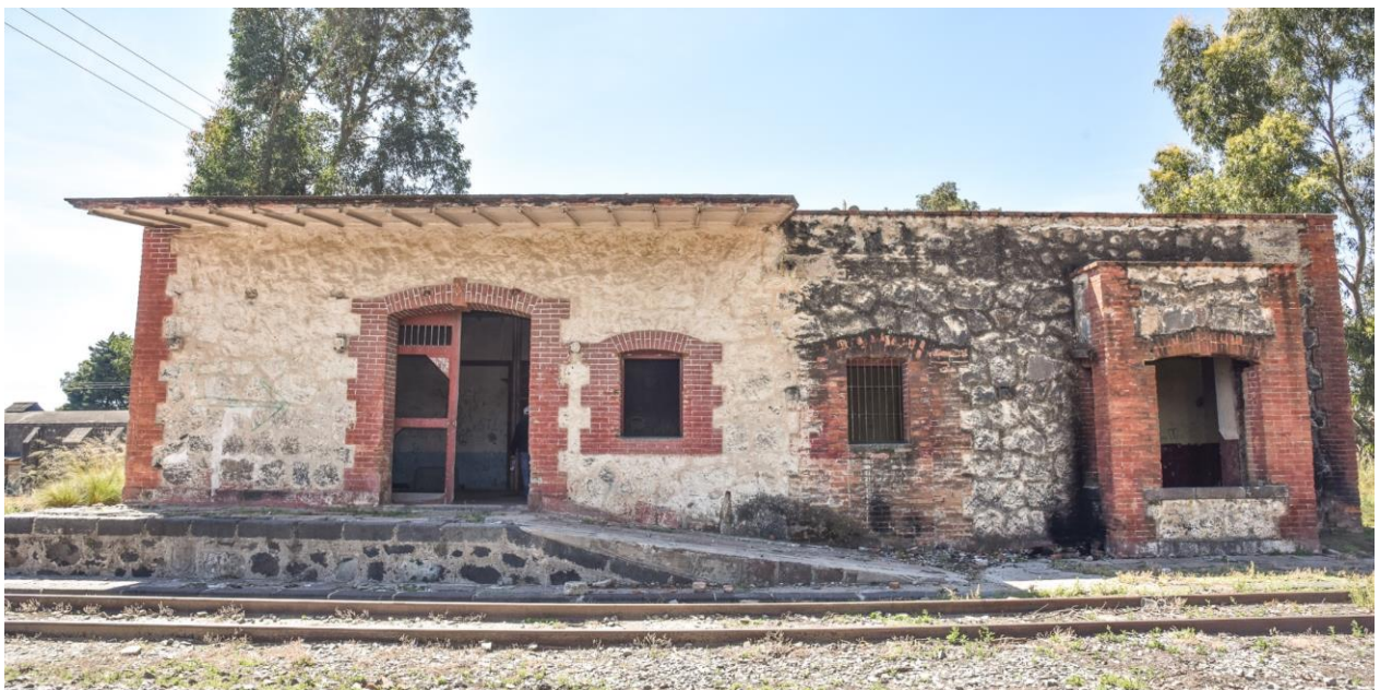
Vue frontale de la façade de la gare et du quai.
