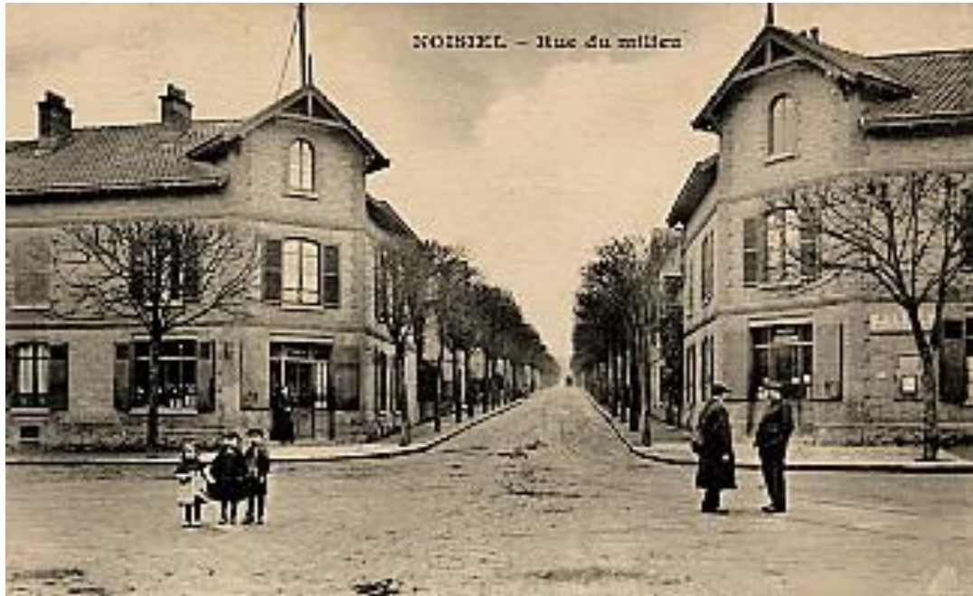
Figure 18 – Rue à Noisiel
