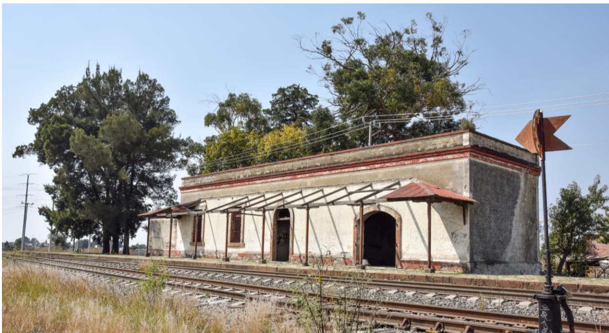
Vue panoramique du côté droit de la façade de la gare et du quai.
