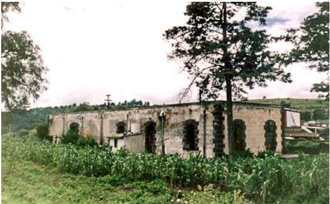
Vue posterieure de la gare.
