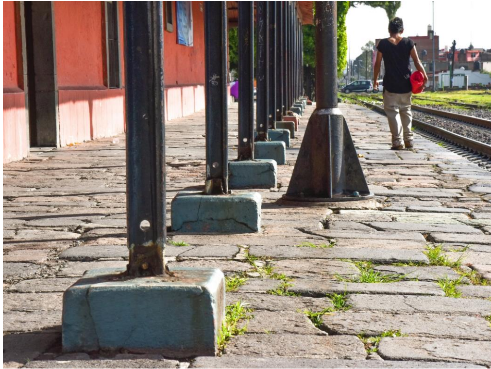
Figure 45 – Des rails employés comme des piliers. Exemple de comment des rails ont été utilisés pour soutenir la marquise à la gare de Santa Ana Chiautempan.
