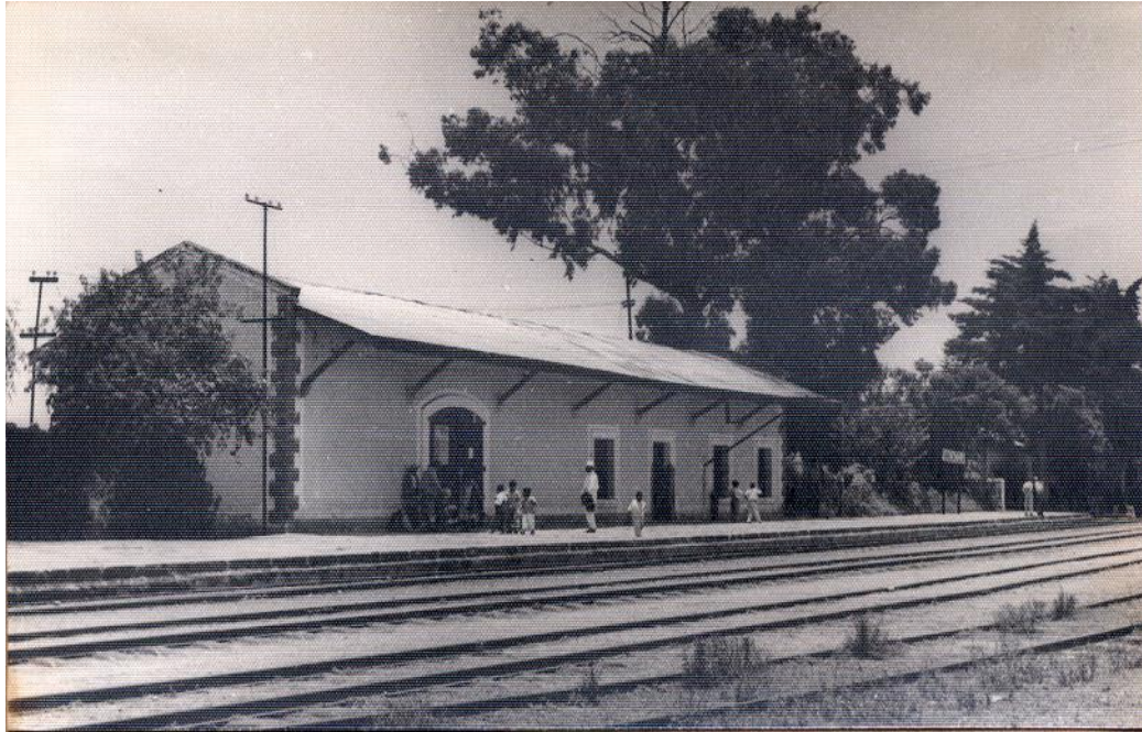
Figure 36 – Gare de Panzicola I. Date inconnue.
