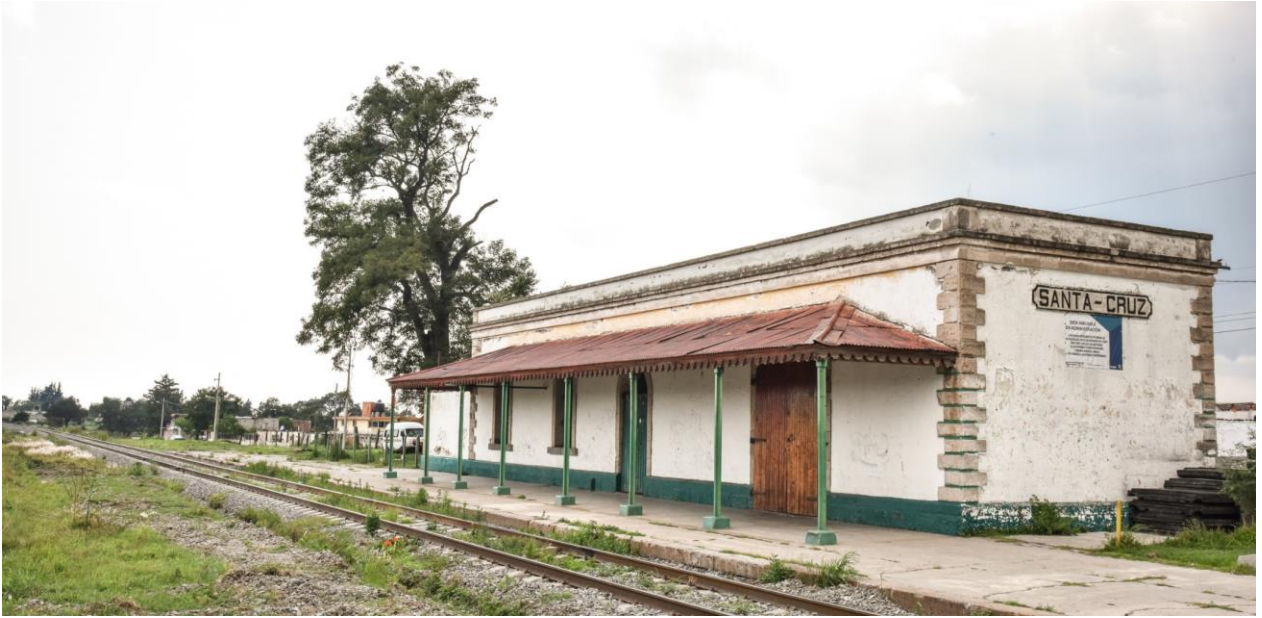
Vue du côté droit de la façade de la gare et du quai.
