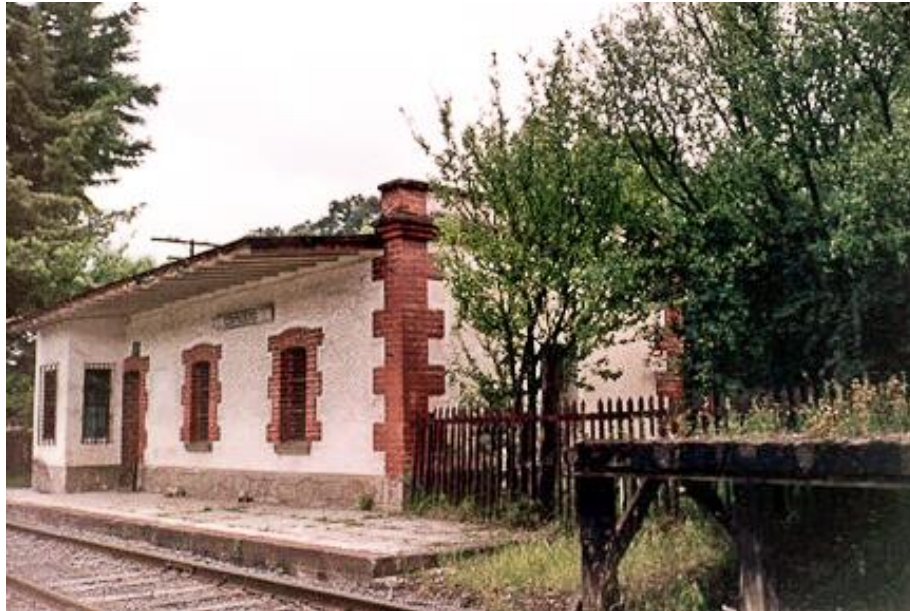
Vue du côté droit de la façade de la gare.
