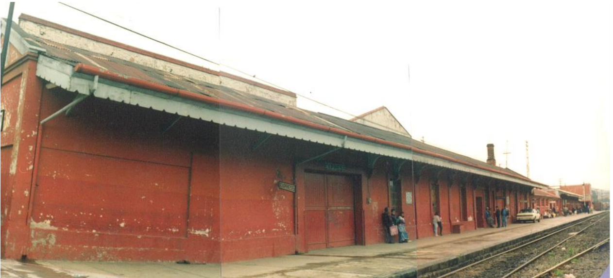
Vue du côté gauche de la façade de la gare et du quai.
