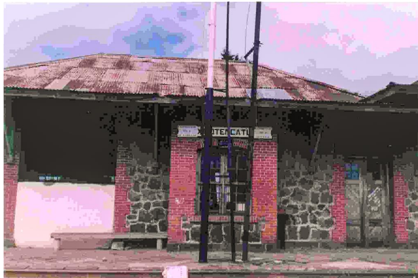
Close-up de la vue frontale de la façade de la gare et du quai.
