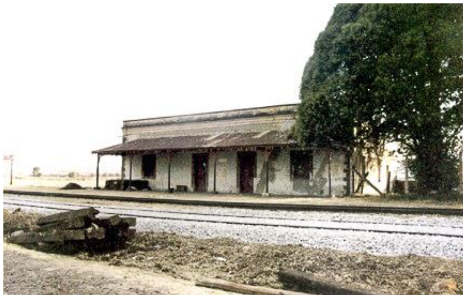
Vue du côté droit de la façade de la gare et du quai.
