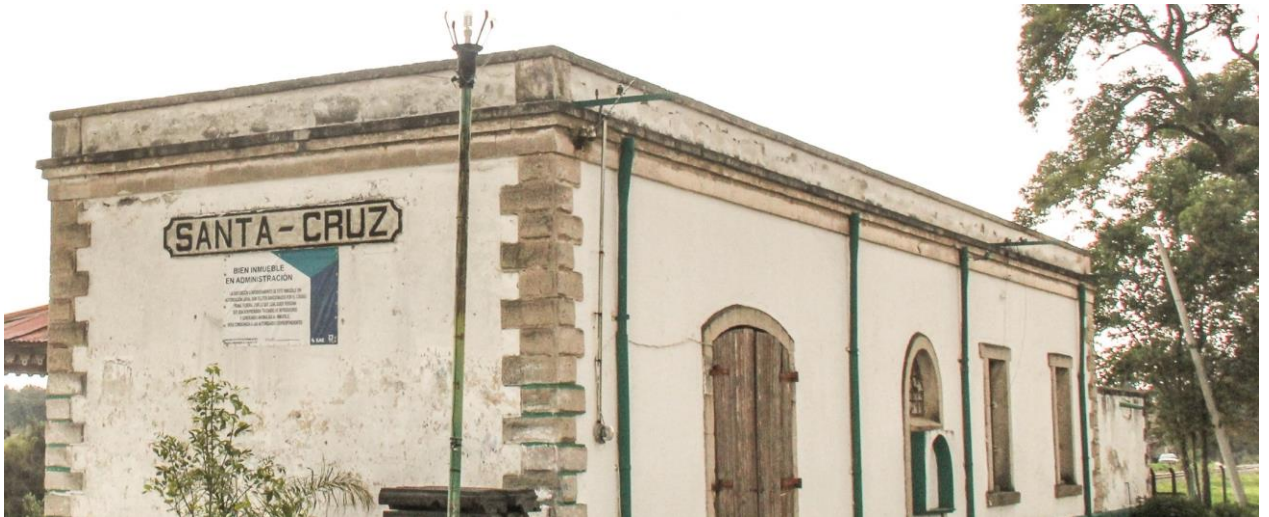
Figure 44 – Comparation de l’allure des gares. En haute, la gare de Tecoac, du Ferrocarril Interoceánico ; en bas, la gare de Santa Cruz, du Ferrocarril Mexicano . Malgré le fait que chaque gare présente des caractéristiques particulières, en générale il est possible d’affirmer que la plupart des gares du réseau du Mexicano ont reçu un enduit sur ses murs, cas contraire à celles du Intéroceánico , dans lesquelles les matériaux des murs sont restés exposés. Dans les deux cas, il est possible aussi de noter des détails en bossage mis en place pour décorer les encadrements des fenêtres, des portes et les angles des bâtiments. Ces deux gares sont couronnées avec un parapet simple. Il faut dire qu’au moins dans la région comprise par les États de Tlaxcala et de Puebla, de nombreux bâtiments industriels présentent la même allure que les gares de l’ Interoceánico .
