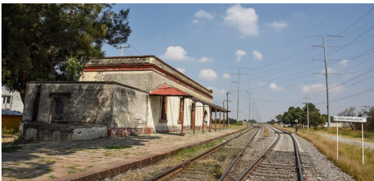
Vue panoramique du côté gauche de la façade de la gare et du quai.
