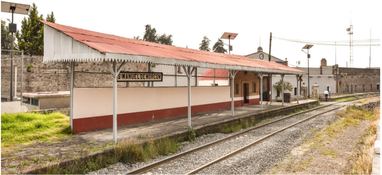
Vue du côté gauche de la façade de la gare et du quai. Au fond, l'entrée de l'usine textile de San Manuel.
