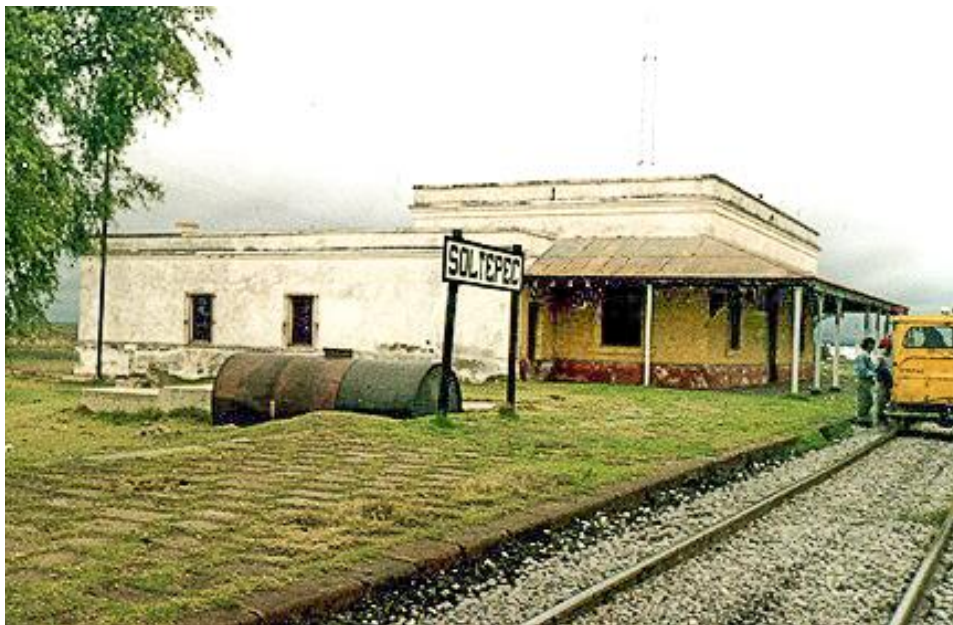
Vue du côté gauche de la façade de la gare et du quai.
