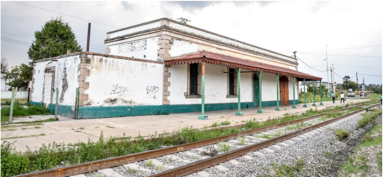
Vue du côté gauche de la façade de la gare et du quai.
