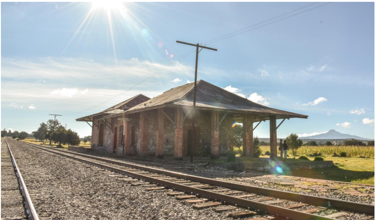
Vue panoramique du côté droit de la façade de la gare et du quai. Il est possible de remarquer l'hangar.
