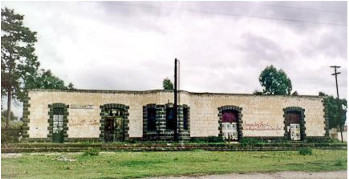
Vue frontale de la façade de la gare et du quai.
