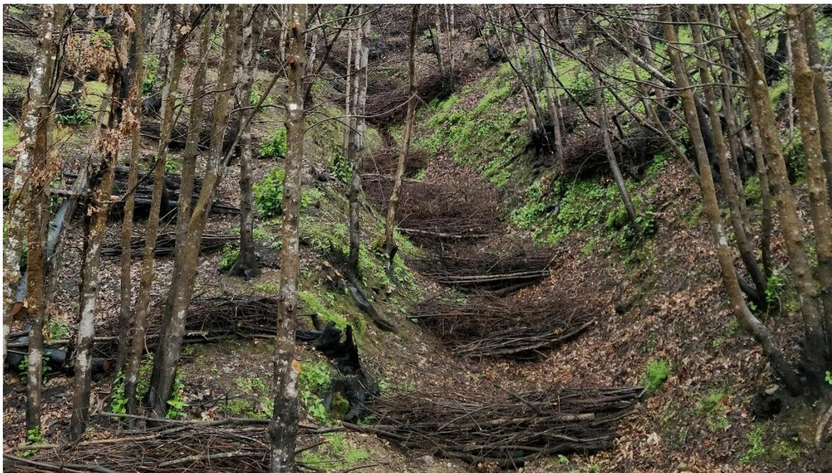
Figura 4 – Construção de micro açudes, ao longo das encostas e talvegues, com árvores queimadas e cortadas, após incêndio florestal, na Serra do Açor. Fotografia. Autoria Própria: 2018.
