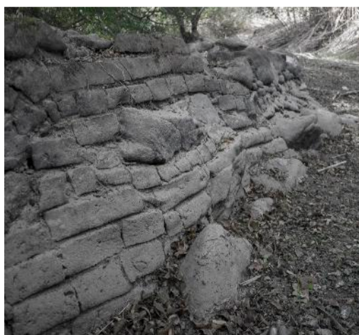
FIG. 137 | Moinho Novo - Adução, pormenor do muro na transição do dique para o canal, pelo interior do açude. Fonte: Fotografias do autor 2017.
