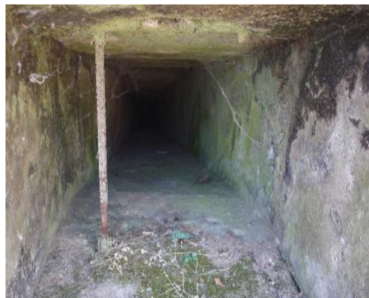
FIG. 60| Moinho da Ponte de Évora - Entrada de água, no cubo. Fonte: Fotografia do autor, 2017
