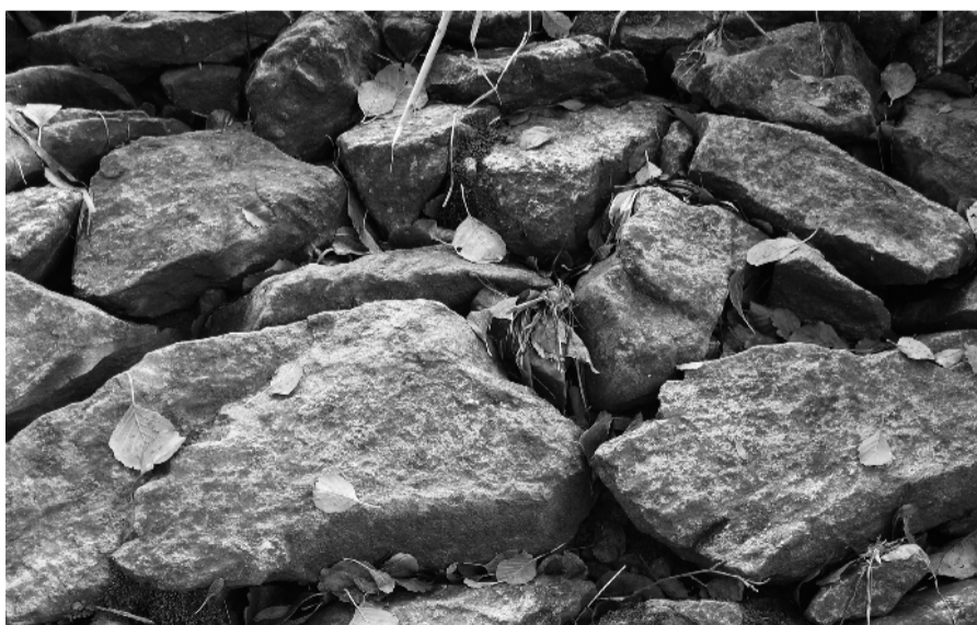
FIG. 51| Rio Almansor - Dique do Açude do Zangalho, junto ao moinho com o mesmo nome, pormenor construtivo - Parte exterior do muro (jorramento) em "pedra sossa". Foto: Fotografia do autor, 2017.
