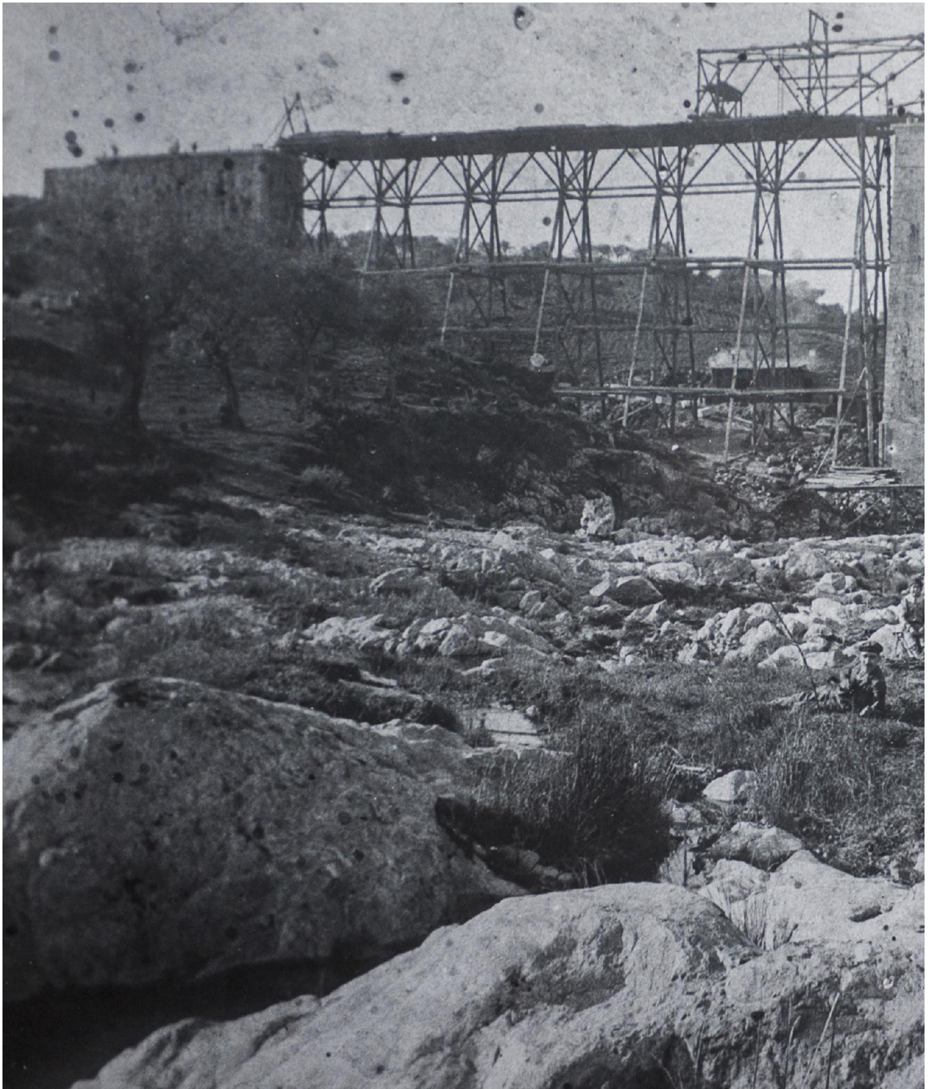
FIG. 140| O moinho da Abóbada. Leito roqueiro do rio. Ponte ferroviária em construção, inaugurada em 1909. Fonte: CM de Montemor-o-Novo. Fotografia do início do Século XX.
