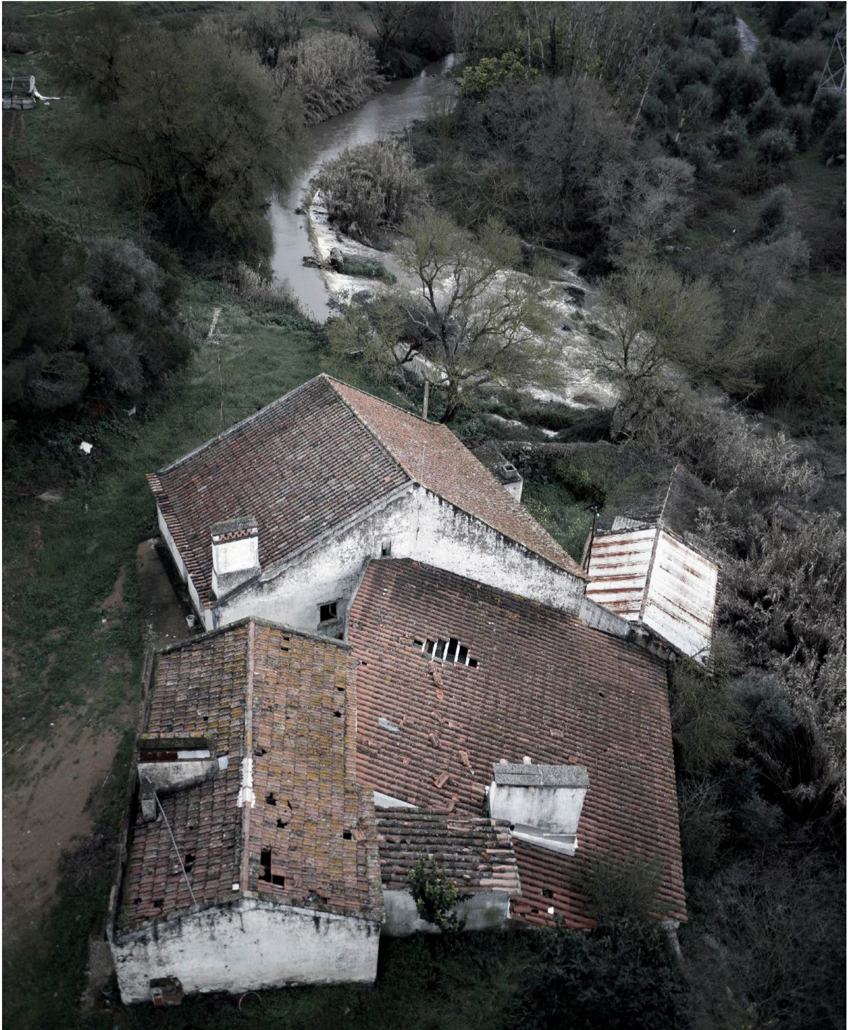
FIG. 139| Núcleo da Abóbada - O Moinho (de submersão), o edificado envolvente e o canal de adução. Fonte: Fotografia do autor, 2018.
