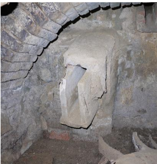
FIG. 123| Moinho do Ananil- Interior dos caboucos, vista da seteira. Fonte: Fotografia do autor, 2017
