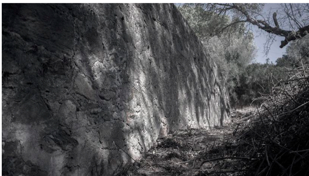
FIG. 152| Moinho da Abóbada - Adução, muro no canal de adução na transição do dique para o canal. Parede maciça e Arco do cabouco em granito com as juntas argamassadas. Pormenores, métodos construtivo e materiais aplicados. Fonte: Fotografias do autor 2017.
