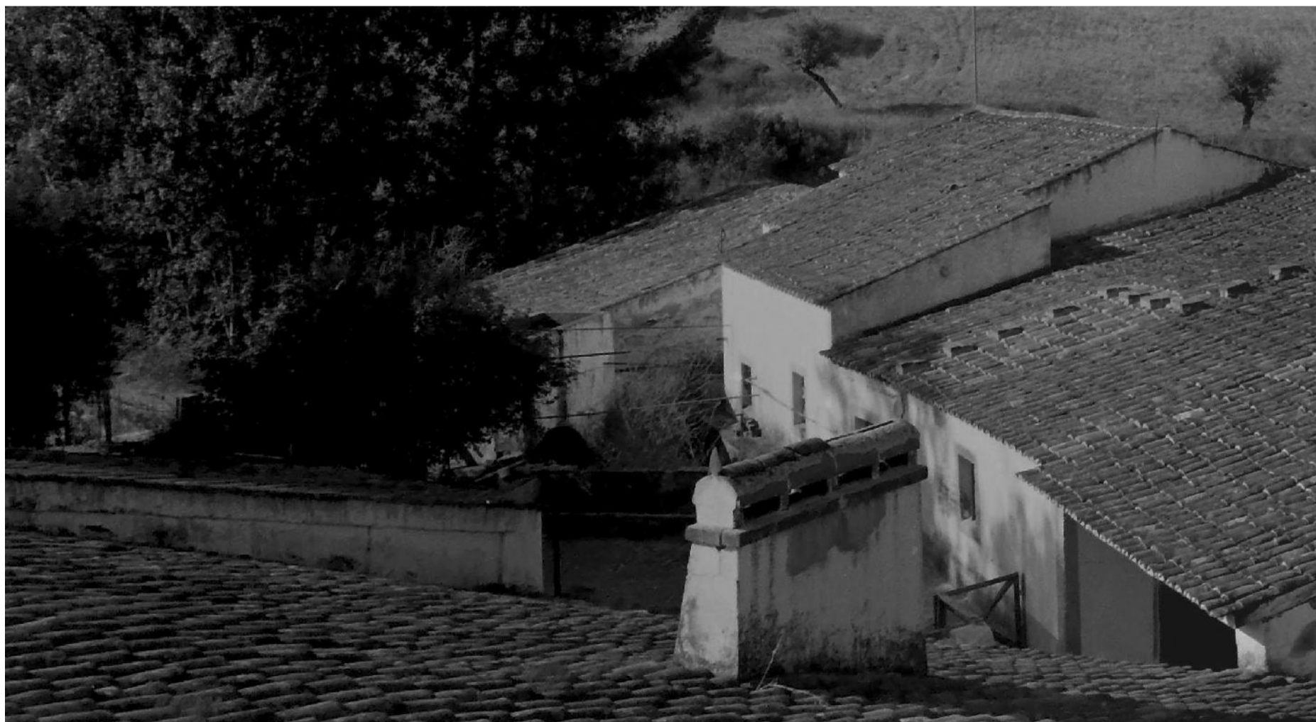
FIG. 118 | Moinho do Ananil ou do Bispo - Vista norte. Fonte: Fotografia do autor, 1984.
