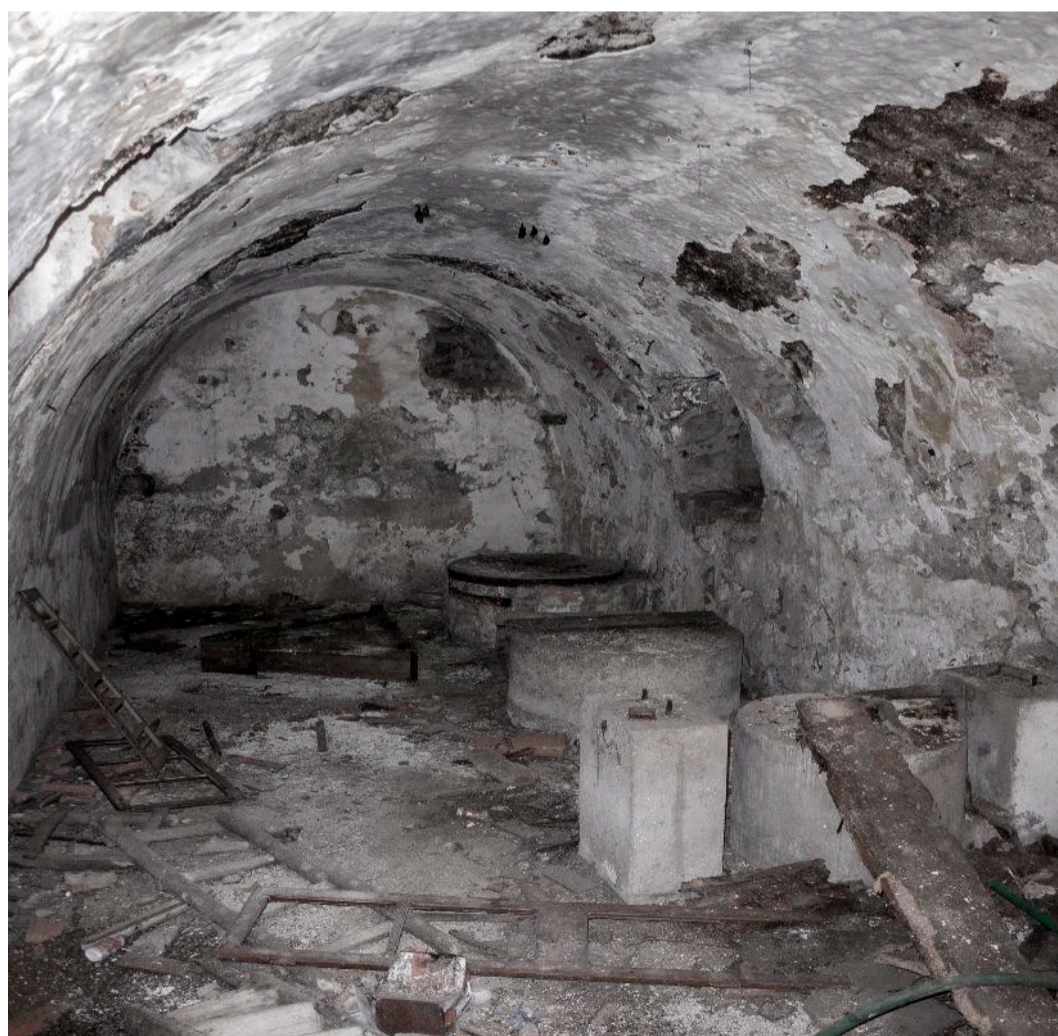
FIG. 149| Moinho da Abóbada - Sala de moagem em abóbada de pedra com os três pares de mós em linha.
