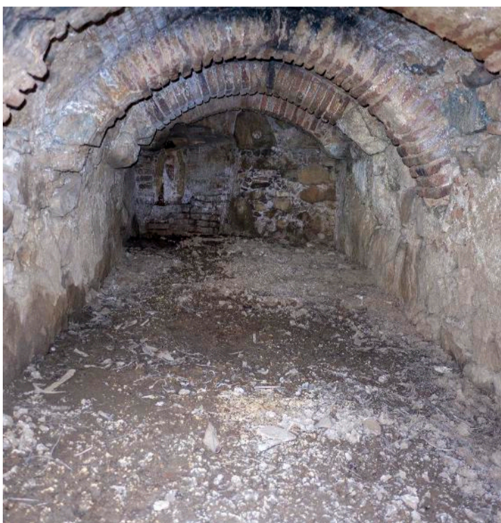
FIG. 168 | Núcleo da ponte de Lisboa - Saida de água do rodízio. Interior de um dos caboucos do moinho de cima. Fonte: Fotografias do autor 2017.
