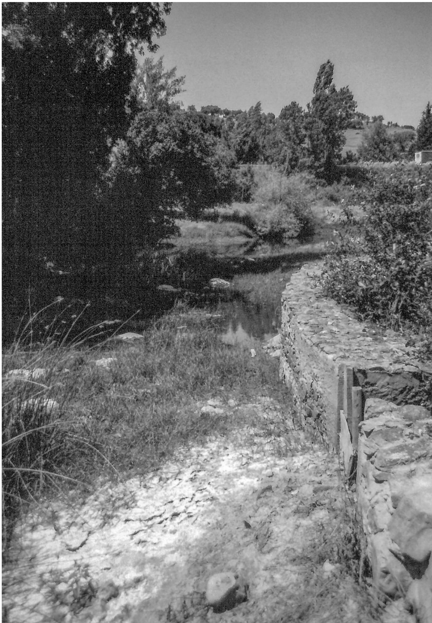
FIG. 62| Açude da Rata- Adução do moinho da Ponte de Évora – Face interior do muro do açude. Fonte: Gabinete Técnico Local- GTL de Montemor-o-Novo em 2000
