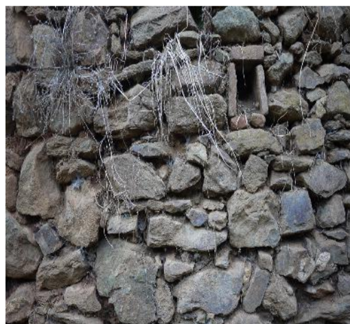
FIG. 138 | Moinho Novo - Muro de suporte dos socalcos em pedra com junta seca e pormenor dos boeiros. Fonte: Fotografias do autor 2017.
