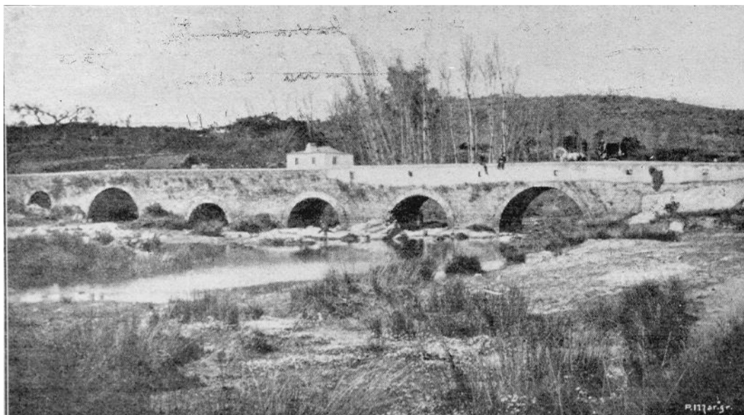
FIG. 56| Local de Atravessamento da antiga Estrada Real Montemor-Évora sobre o rio Almansor, pela Ponte de Évora (sec. XII) em primeiro plano e em segundo plano o moinho da ponte de Évora. Vista jusante a partir da margem esquerda do rio. Fonte: Fotografia in revista Brasil Portugal de autor desconhecido
