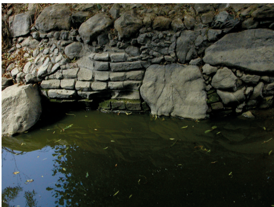
FIG. 50| Rio Almansor - Dique do Açude da Volta, junto ao moinho Novo, detalhe construtivo da boca da levada. Foto: Fotografia de Tiago Frois, 2004.
