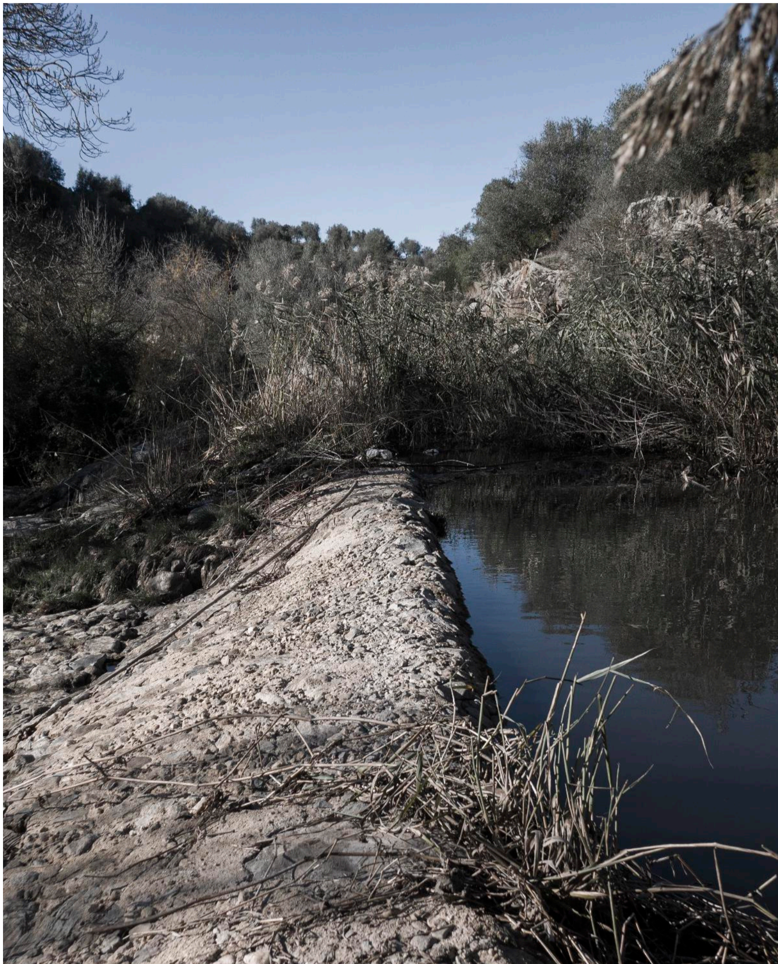
FIG. 160| Adução dos moinhos da Azenha. Dique do açude com o efeito de jorrimento. Fonte: Fotografia do autor, 2017.
