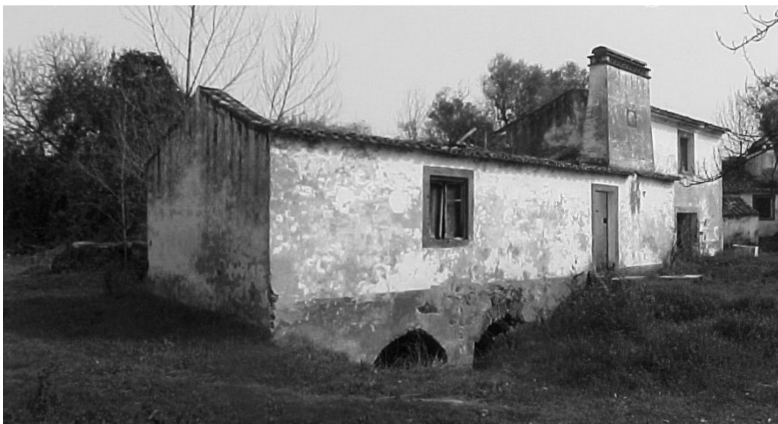
FIG. 85| Moinho do Canal - Vista sul-poente, saída de água- caboucos e enxógadoiro. Fonte: Foto de Joana Ramirez Carvalho, Arquitecta autora do projecto de adaptação do moinho, 2000.
