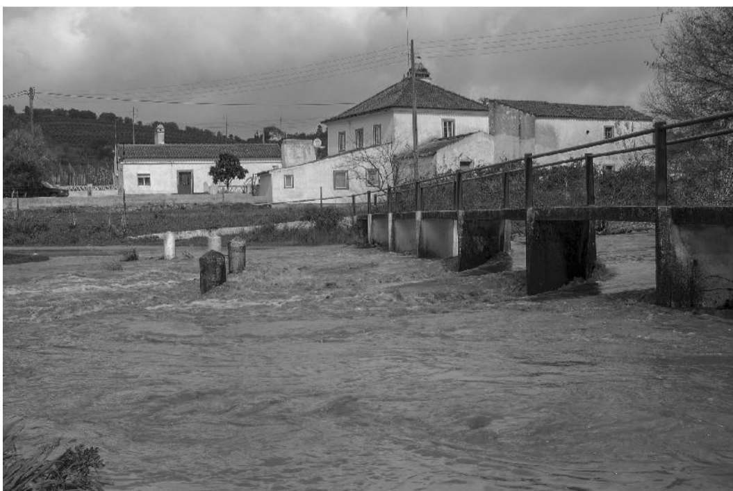
FIG. 94 | Moinho do Porto das Lãs - Vista nascente. Em primeiro plano, o rio e uma ponte pedonal de betão para atravessamento, que substituiu as antigas alpondras - formada por blocos de pedra apurados. Fonte: Fotografia cedida pela Câmara Municipal de Montemor-o-Novo, 1996.
