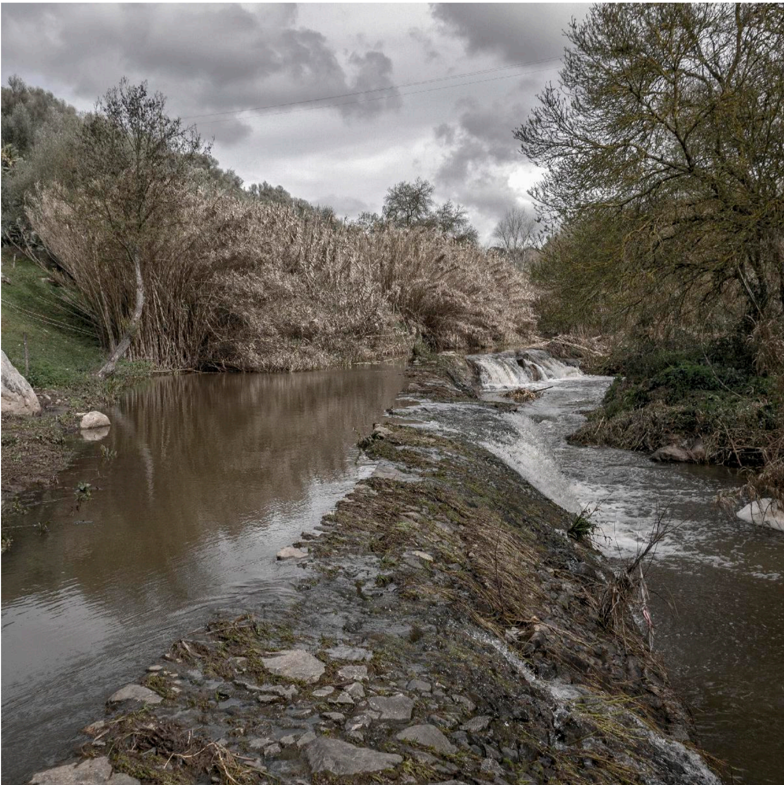
FIG. 167| Núcleo da ponte de Lisboa. Adução dos moinhos - Dique do açude e canal em pedra aglutinada. Fonte: Fotografia do autor, 2017.
