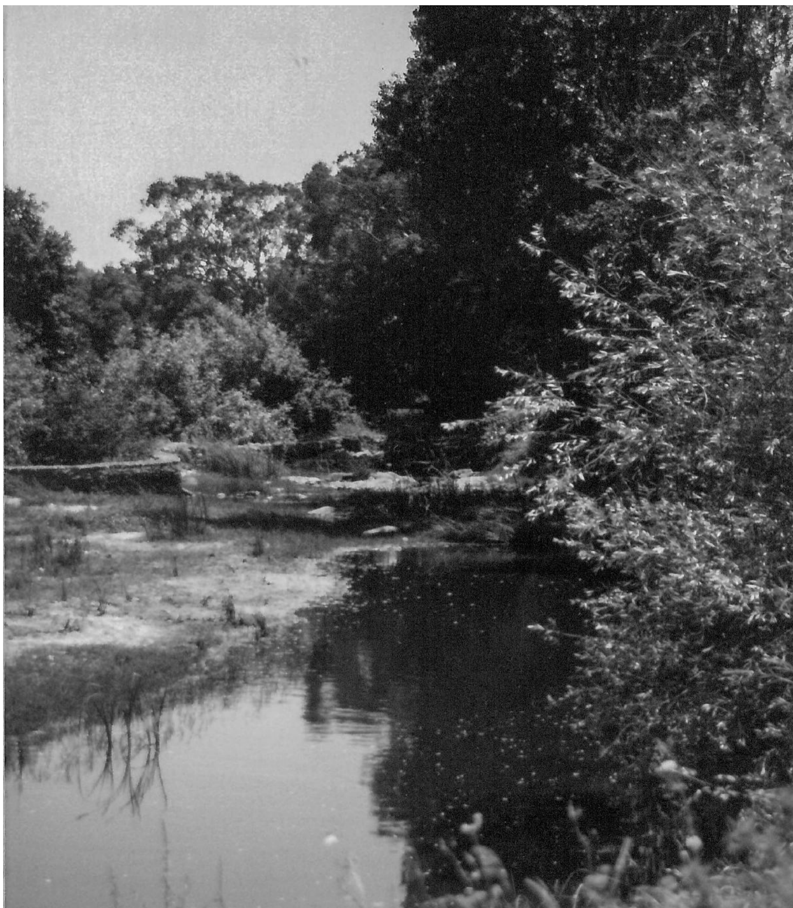
FIG. 63 | Açude da Rata- Adução do moinho da Ponte de Évora, vista do interior para jusante. Muro do açude e boca da levada. Fonte: Gabinete Técnico Local- GTL de Montemor-o-Novo, 2000.
