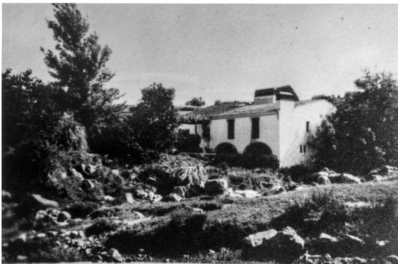
FIG. 165| Núcleo da Ponte de Lisboa - Margem norte do rio, moinho de cima. Vista dos Caboucos. Fonte: Jornal "O Montemorense", fotografia de autor desconhecidos.
