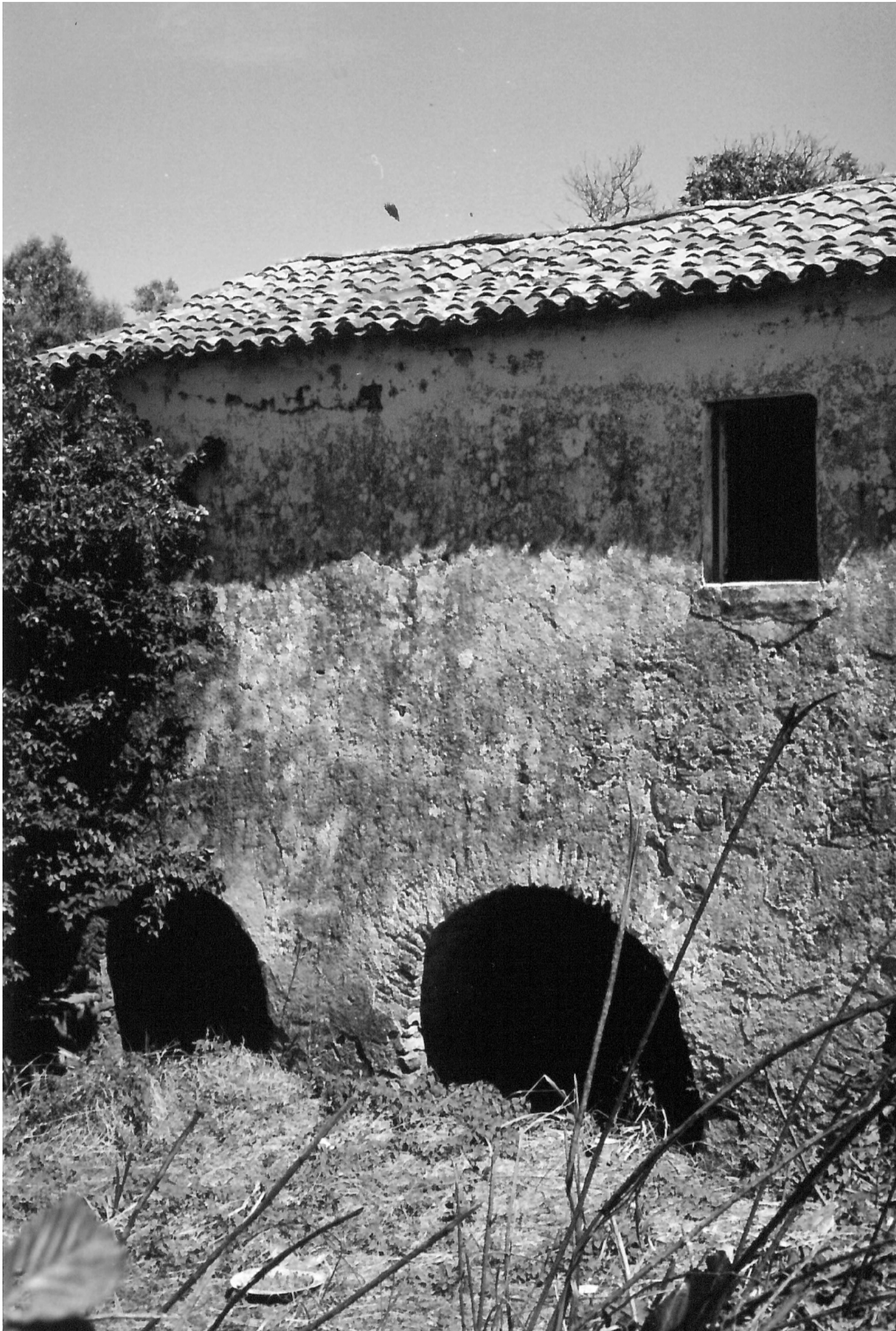
FIG. 72| Moinho da Pintada - Vista sul, caboucos e enxógadoiro. Fonte: Gabinete Técnico Local- GTL de Montemor-o-Novo, 2000.
