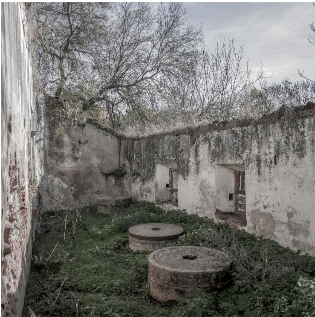
FIG. 112 | Moinho do Zangalho - Interior da sala de moagem, com três pares de mós em linha. Fonte: Fotografia do autor, 2017.
