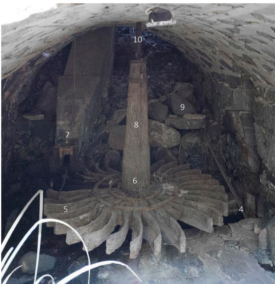
FIG. 43| MOINHO DE RODÍZIO - Mecanismo de moagem. Vista Interior do Cabouco - Sétia, veio, pela e penado. Moinho do Poucochinho, Serra de Monchique. Fonte: Fotografia do autor em 2018
