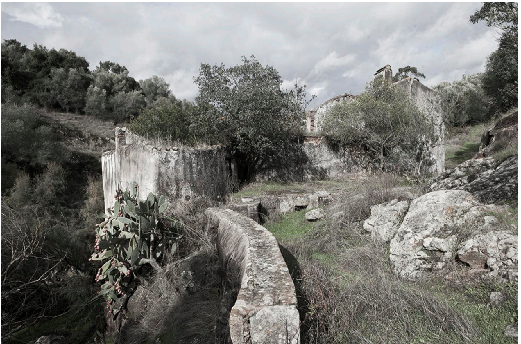
FIG. 153 | Núcleo da Azenha - Canal de adução e caldeira do moinho de cima. Fonte: Fotografia de Tiago Frois, Workshop Oficina da Luz 2018, sob a orientação de José M. Rodrigues e Duarte Belo.
