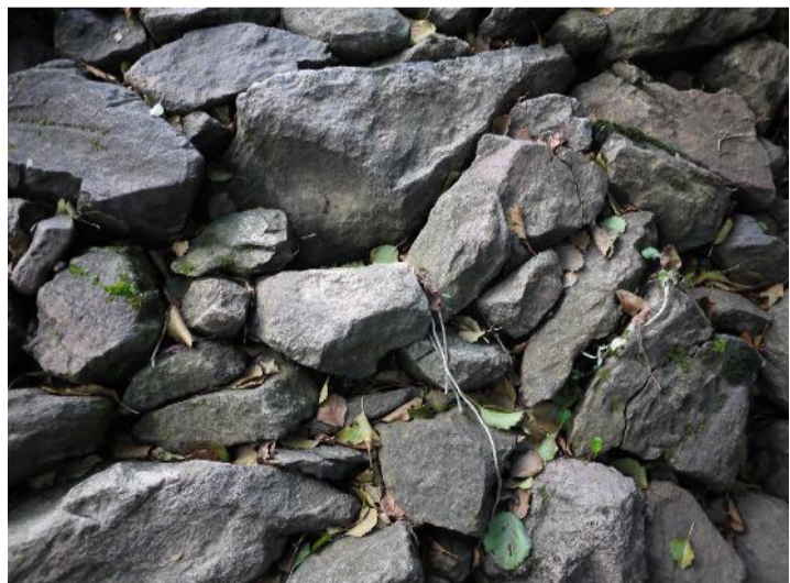
FIG. 124| Moinho do Ananil - Método construtivo, pedra imbricada ou pedra sossa, sem aplicação de ligante. Fonte: Fotografias do autor 2017
