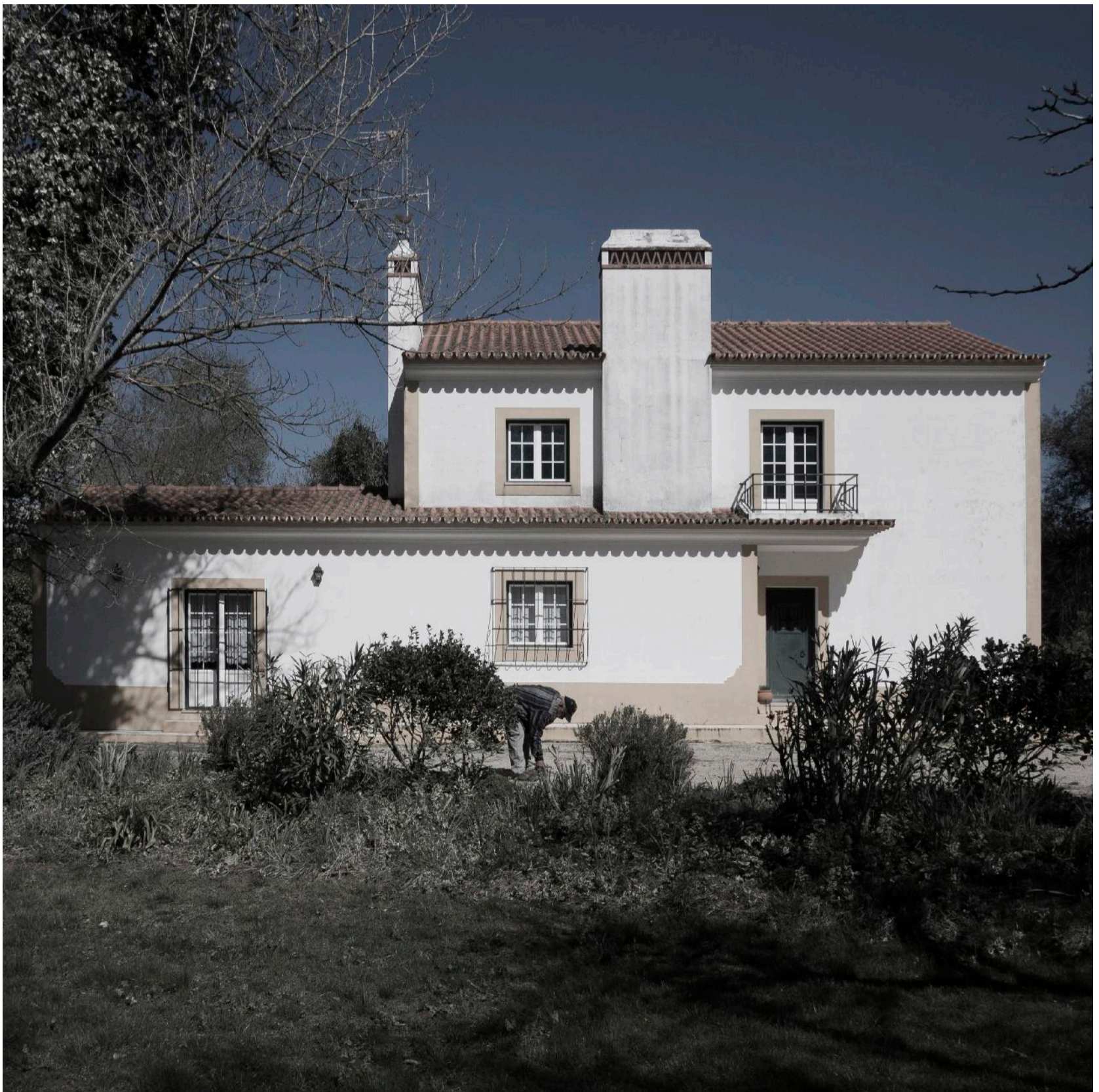
FIG. 83| Estado actual do antigo moinho do Canal, transformado em habitação do proprietário - Vista sul, do lado do antigo enxógadoiro. Fonte: Fotografia do autor, 2017.
