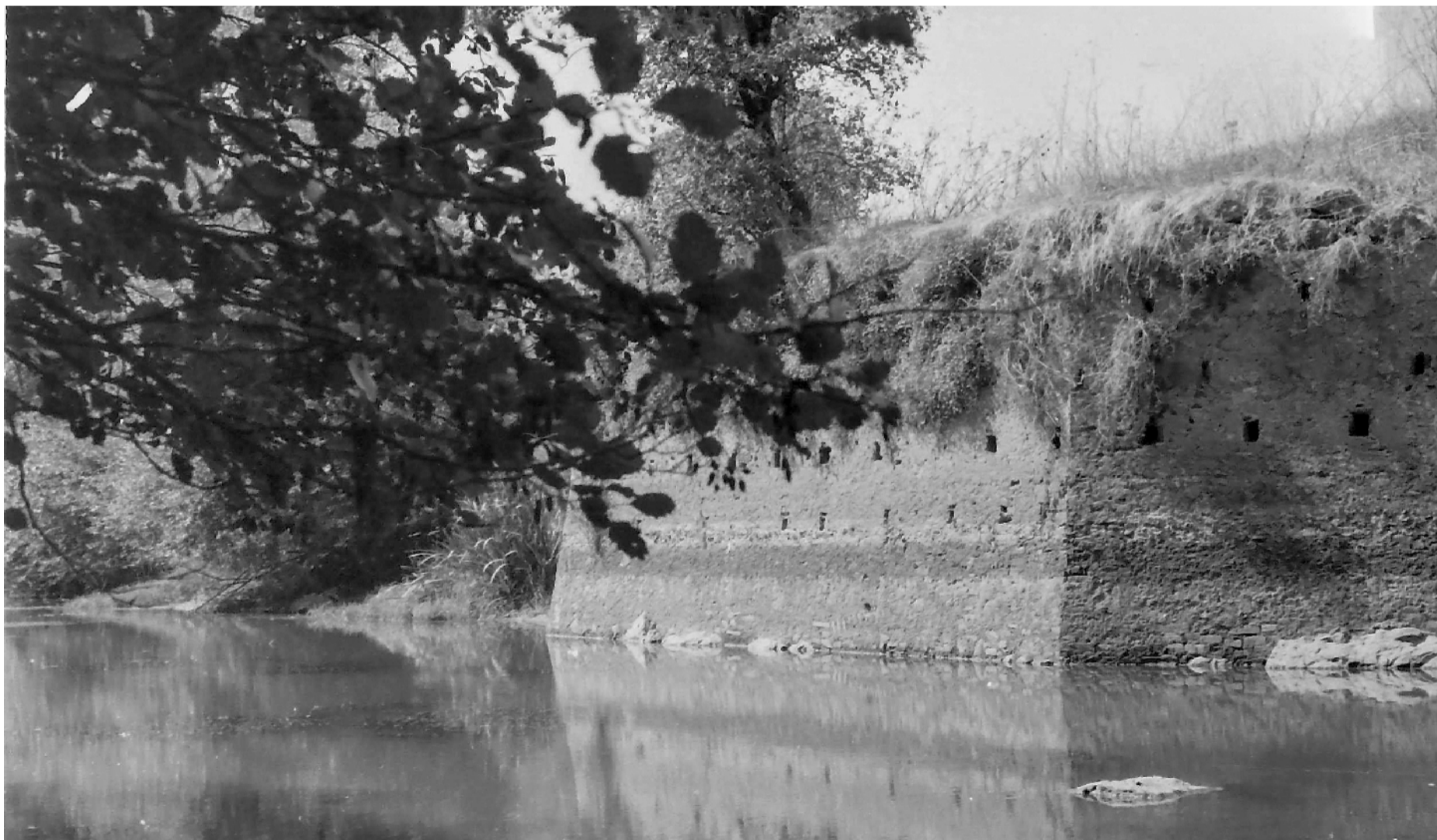
FIG. 110| Moinho e açude do Zangalho- Vista sul / nascente do muro de suporte em taipa da plataforma, sobranceira ao rio. Fonte: Fotografia do autor, 1984.
