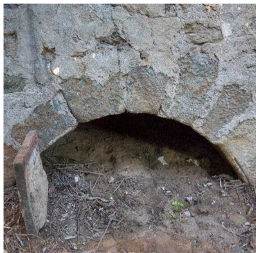
FIG. 151| Arco do cabouco em granito.
