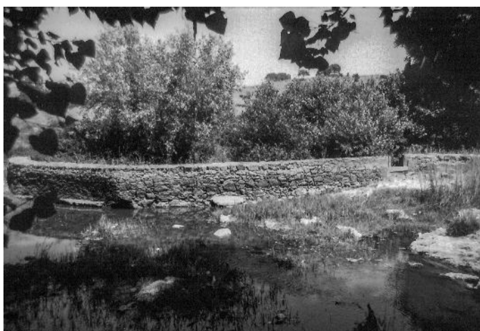
FIG. 64 | Açude da Rata- Adução do moinho da Ponte de Évora – Vista do interior do açude, pormenor da parede do dique. Fonte: Gabinete Técnico Local- GTL de Montemor-o-Novo em 2000
