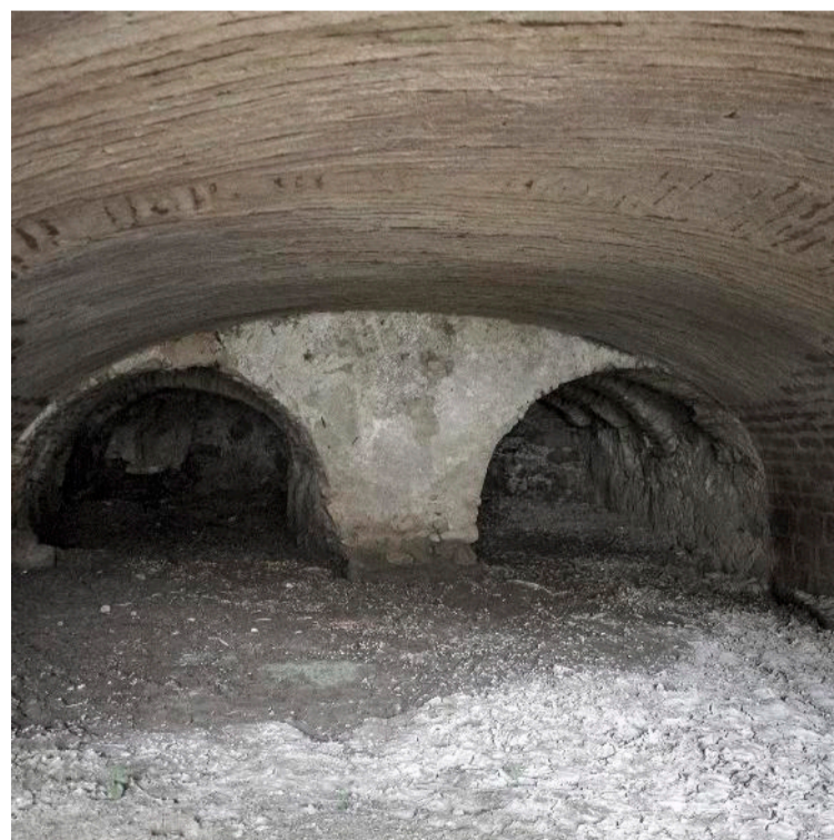
FIG. 169 | Núcleo da ponte de Lisboa - Saida de água dos rodízios. Vista interior de dois dos caboucos e a abóbada da galeria do moinho de cima. Fonte: Fotografias do autor 2017.
