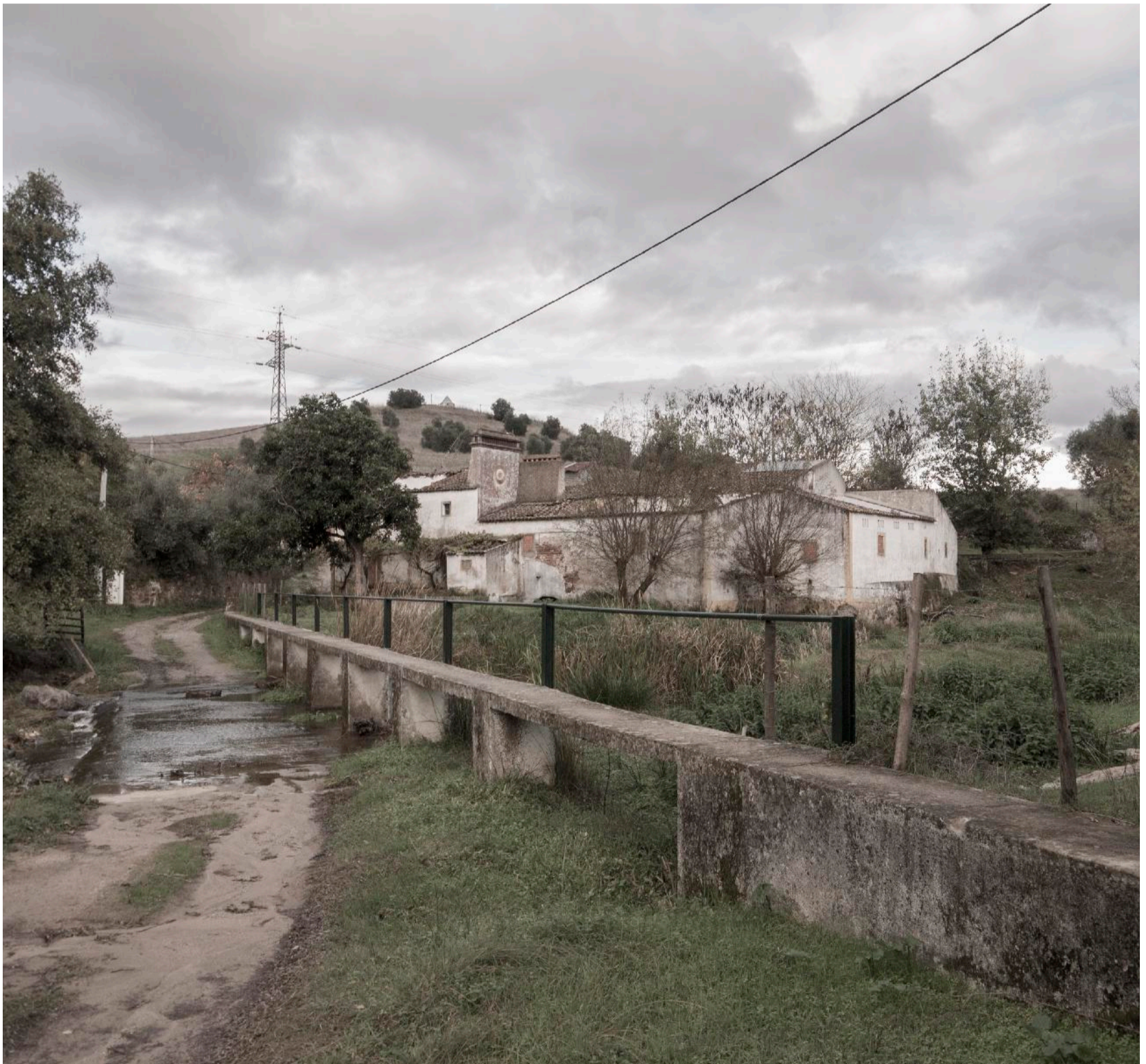
FIG. 113| Moinho do Ananil ou do Bispo - Vista sul - atravessamento a vau do rio e ponte pedonal, que substituiu as antigas alpondras. Fonte: Fotografia do autor, Workshop "Oficina da Luz" com Duarte Belo e José Manuel Rodrigues, Outubro de 2018.
