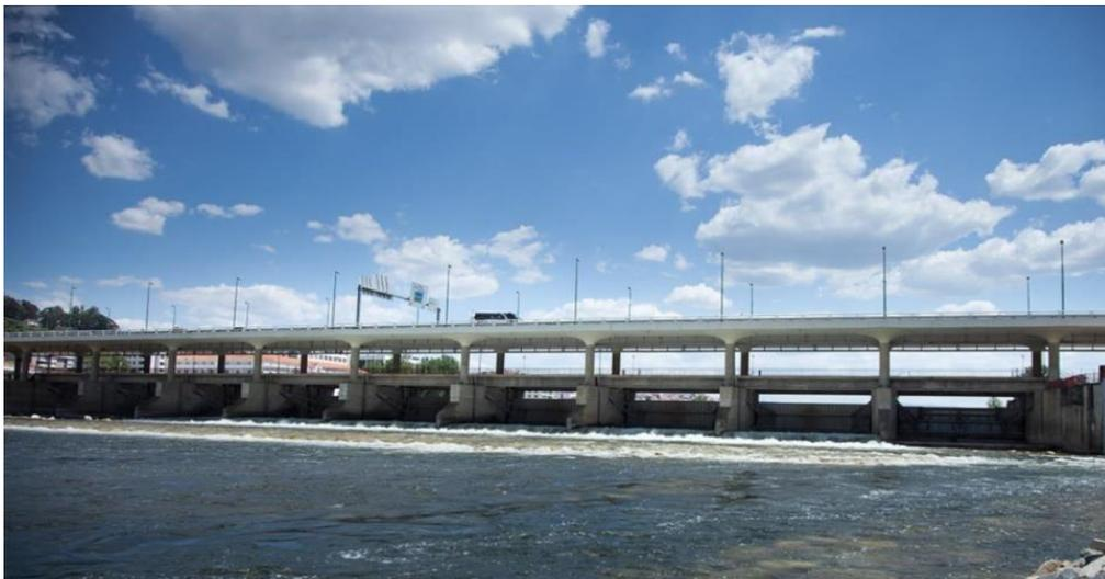
**Figura 5** - Vista a jusante do Açude-Ponte de Coimbra ilustrando a presença das nove comportas associadas a esta infraestrutura.
