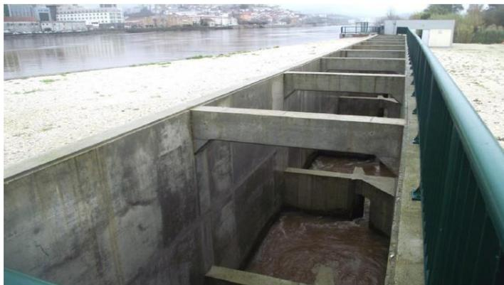
**Figura 6** – Imagem da Passagem Para Peixes de bacias sucessivas e fendas verticais presente no Açude-Ponte de Coimbra.
