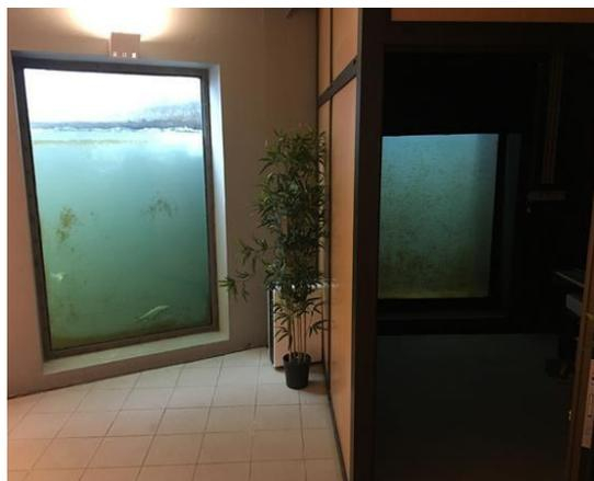
**Figura 9** – Interior da estação de monitorização da PPPeixes do Açude-Ponte de Coimbra. À esquerda a janela vertical para visitantes e à direita a janela vertical para a monitorização biológica.
