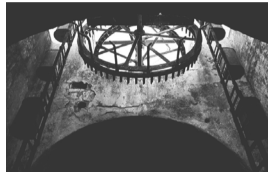
FIG 084 Poço com Nora no Convento de São Francisco
