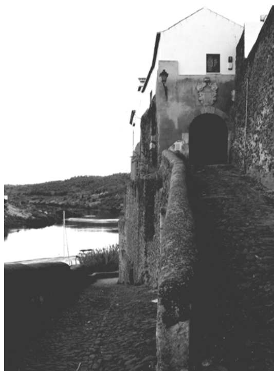
FIG 066 Porta da Ribeira Porta principal de Mértola quando o rio dava acesso ao Mediterrâneo. Esta porta ligava diretamente o centro histórico ao porto e à Torre do Rio .
