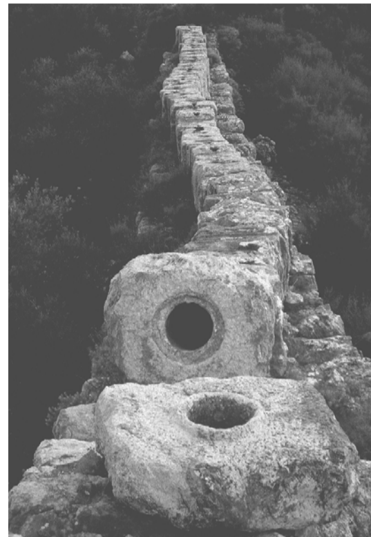
FIG 052 Aqueduto de Patara Situada na Turquia, a antiga infraestrutur romana de transporte de água abastecia a cidade de Patara com água proveniente de uma nascente a 20 km de distância.
