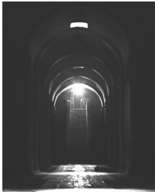
FIG 056 Cisterna Militar de Elvas
