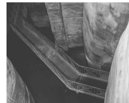
FIG 041 Cisterna de Água
