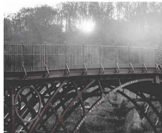
FIG 061 Ponte Ironbridge Desenhada por Thomas Farnolls Pritchard e datada de 1779, a ponte sobre o rio Severn, em Coalbrookdale (Inglaterra), foi a primeira ponte construída em ferro fundido.
