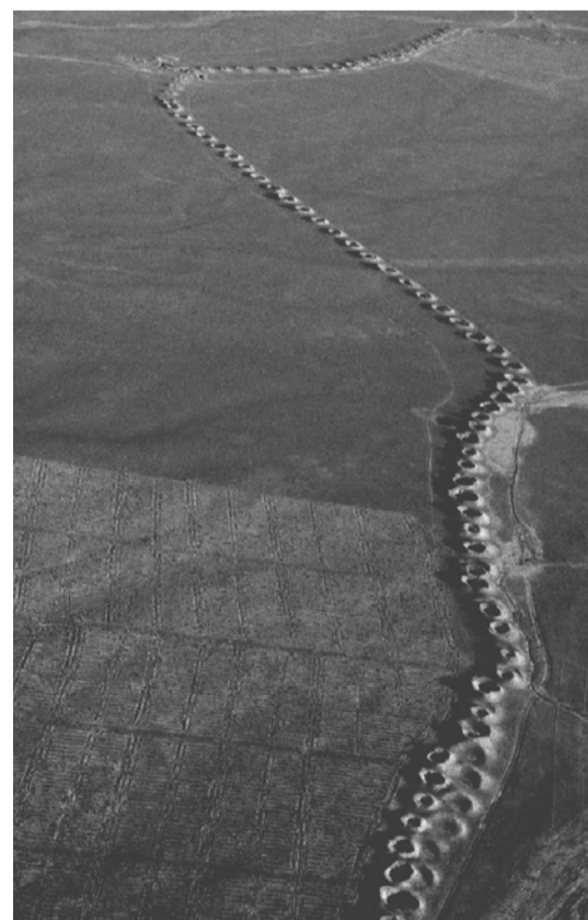
FIG 053 Qanat Desenvolvido na antiga Pérsia, o sistema de condução de água conhecido como Qanat consistia numa rede de canais subterrâneos conectados por poços.
