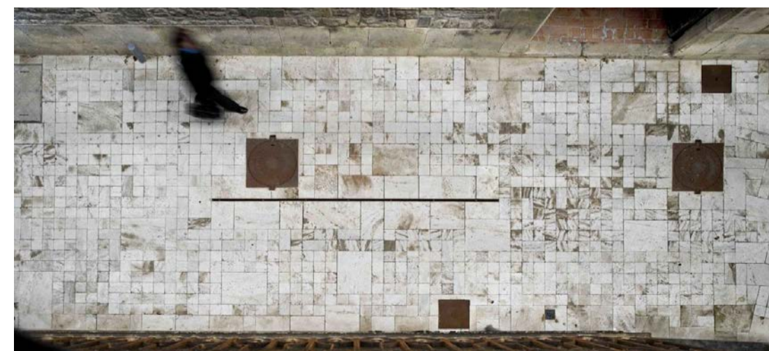
FIG 054, FIG 055 Banyoles - Josep Miás O projeto do arquiteto na cidade catalã de Banyoles consiste num aproveitamento de sistemas de drenagem das águas, construídos no século IX pelos monges que habitavam a cidade. Os canais, escavados na rocha, atravessavam a cidade e, além de providenciarem águas aos habitantes, serviam para escoar as águas das frequentes cheias. Foram totalmente cobertos e abandonados até que Josep Miás os devolveu à cidade, reincorporando-os nas ruas e reintreperando os vazios urbanos, associados a uma nova/velha infraestrutur.
