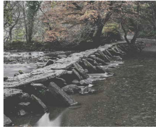
FIG 060 Ponte Tarr Steps Consiste num modelo rudimentar de ponte, com lajetas de pedra assentes em pilares de pedra, com cerca de 1 metro de altura. É a maior infraestrutura, ainda existente, deste tipo.
