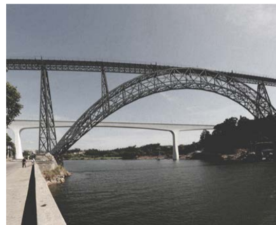
FIG 062 Ponte de D. Maria Pia e Ponte de São João Duas das seis pontes sobre o Rio Douro, na cidade do Porto. Em primeiro plano, a infraestrutura desenhada pelo engenheiro francês Gustave Eiffel, e em segundo, a estrutura do Engenheiro Edgar Cardoso.
