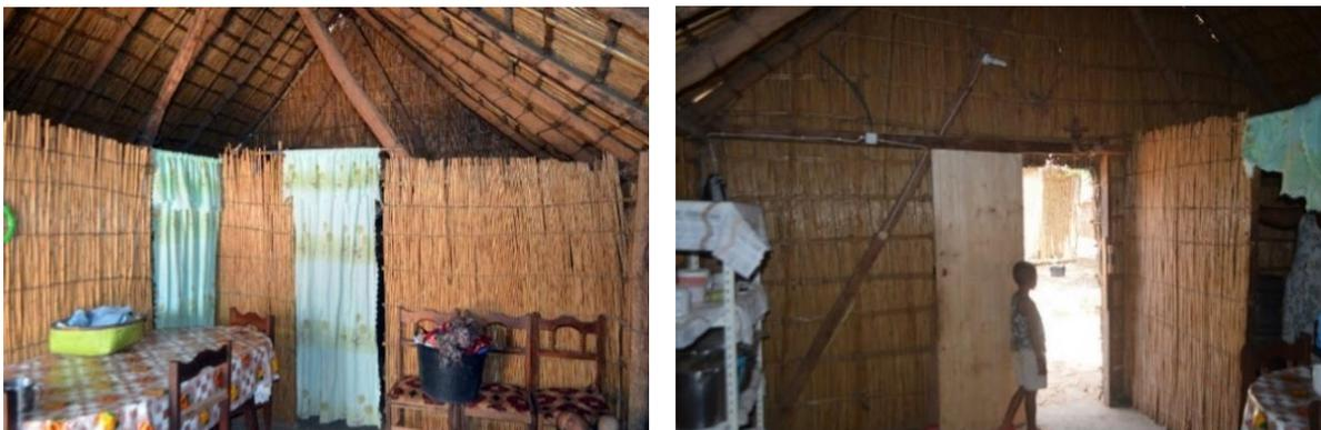
**Figura 28.** Acabamento interno das paredes e coberturas com caniço, comunidade dos rabelados (Fotografias do dissertando).
