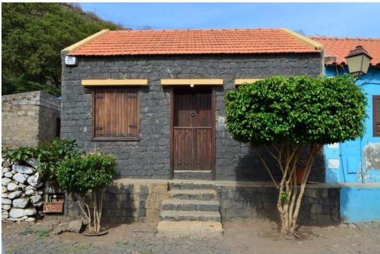
**Figura 39.** Diversas formas de revestimento com pedras basálticas (Cidade Velha). (Fotografia do dissertando).
