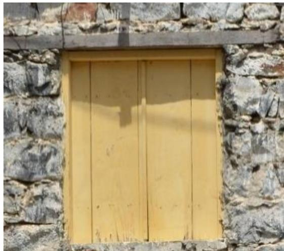
**Figura 119.** Janelas de uma e duas folhas com tábuas de madeira justaposta (à esquerda: parcela **B8**; à direita: **Ca6**).
