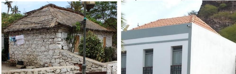
**Figura 92.** Cobertura de quatro águas: com beiral (à esquerda: Parcela **B18**); sem beiral (à direita: Parcela **C3**);
