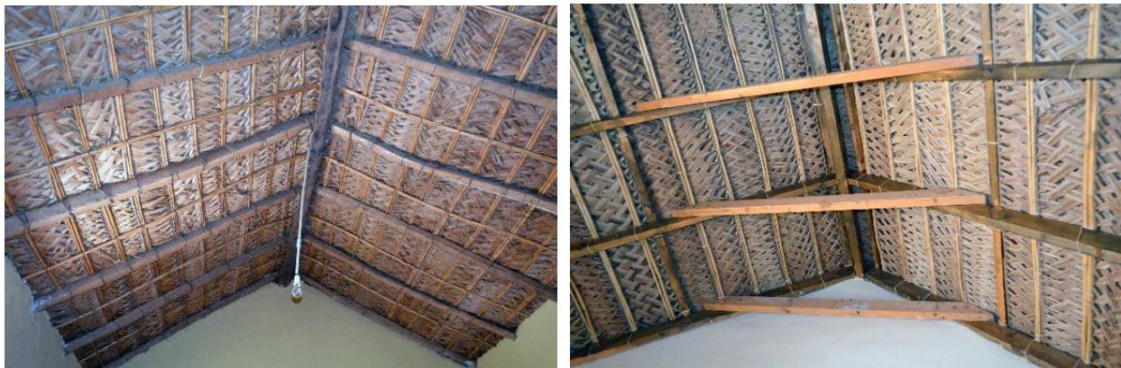
**Figura 42.** Pormenor de montagem da cobertura de palha, na Cidade Velha. (Fotografias do dissertando).
