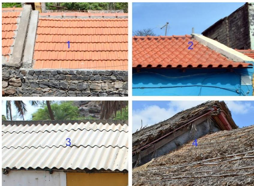
**Figura 77.** Tipos de coberturas inclinadas.
