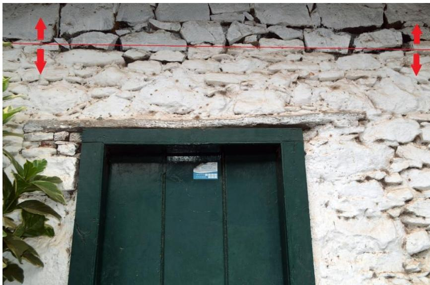
**Figura 56.** Diferente utilização de emparelhamento da Alvenaria de pedra consoante à altura. (Fotografia do dissertando).
