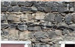
Alvenaria de pedra com junta de argamassa de cimento (parcelas B5 e B6)
