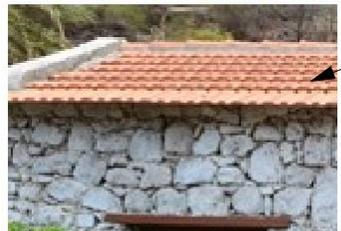
Alvenaria de pedra com junta de argamassa de cimento, caiado (parcela B3)
