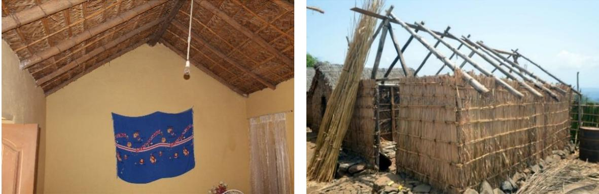
**Figura 27.** Estrutura da cobertura em madeira de coqueiro: figura esquerda- Cidade Velha; figura direita-comunidade dos rabelados (Fotografias do dissertando).;
