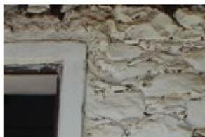
Alvenaria de pedra com junta de terra argilosa, tijoleira e argamassa de cimento (caiado, parcelas B5 e B6)
