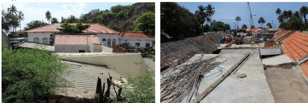
**Figura 93.** Cobertura de uma água (à esquerda: anexos da parcela **M1**) e plana (à direita: anexo entre **B6** e **Ca3**);
