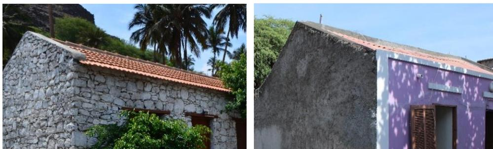
**Figura 91.** Cobertura de duas águas: com beiral (à esquerda: Parcela **B3**); sem beiral (à direita: Parcela **M1**);
