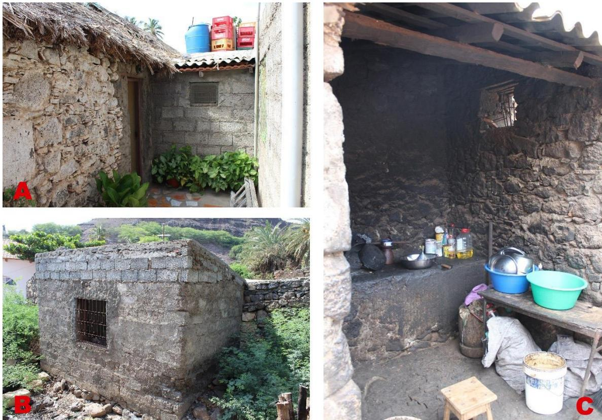
**Figura 66.** Anexos construído com blocos de cimento (A e B pertencente, respetivamente, as parcelas **B7** e **M1**) e alvenarias de pedra (C pertencente a parcela **P1**).
