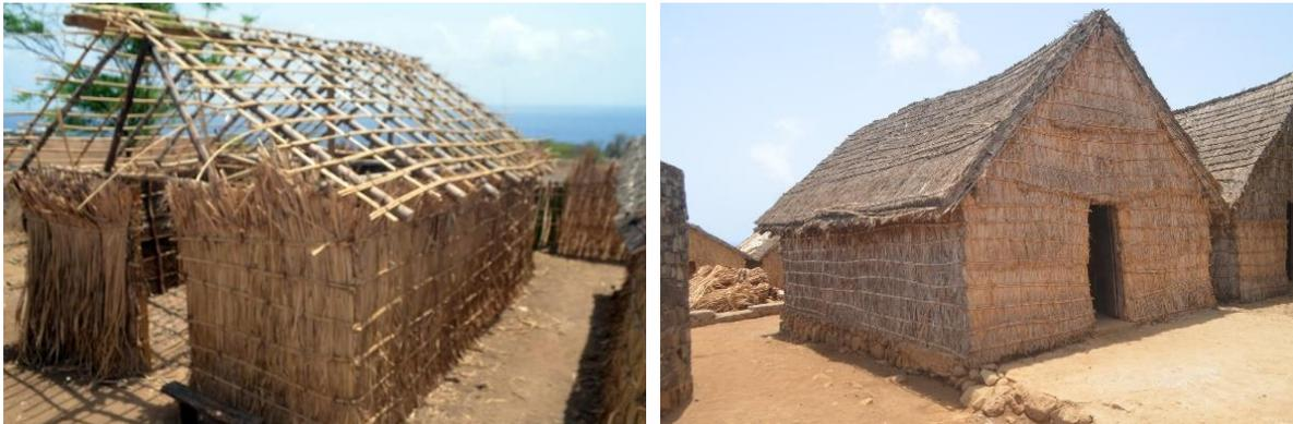
**Figura 29.** Construção com palhas nas paredes e coberturas, comunidade dos rabelados. (Fotografias do dissertando).
