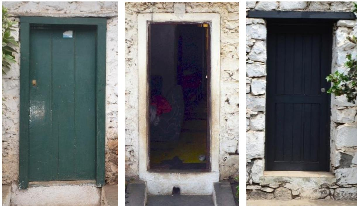
**Figura 117.** Três tipos de aros e soleiras (Tipo 1 à esquerda: parcela **B6**; Tipo 2 no meio: **B9**; Tipo 3 à direita: **B4**).
