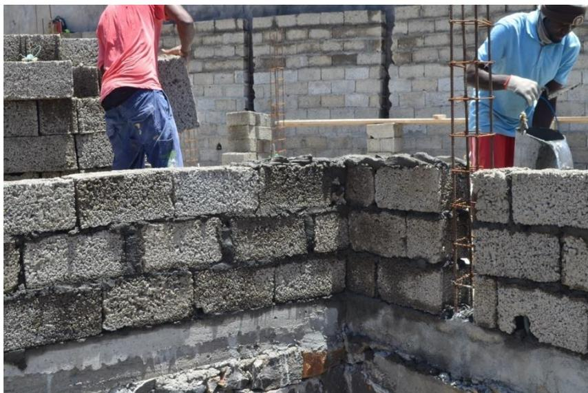
**Figura 23.** Assentamento de bloco de cimento. (Fotografia do dissertando).
