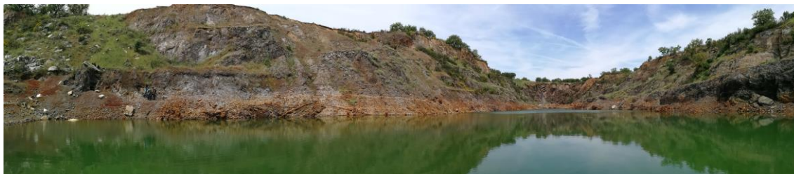
Figura 16 – Mina de Miguel Vacas, aspeto geral da exploração a céu aberto, que atualmente se encontra inundada.
